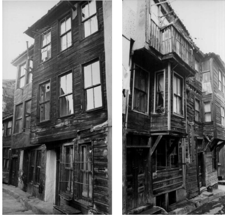
Şekil 4.9 1970'li Yıllarda 24-25-26-27 No'lu Parseldeki Yıkılmış Tescilli Kültür Varlığı Yapılar [44].
