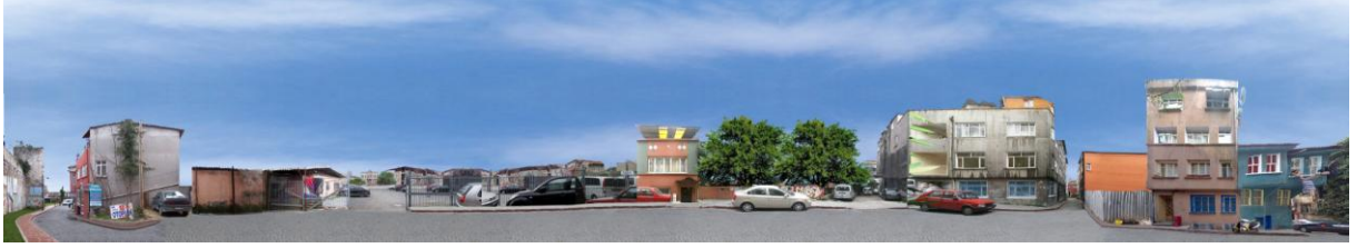
Şekil 5.6 Yeni Sarıçane Sokak Kuzey Yönüne Bakan Cephe Silueti, 2010
