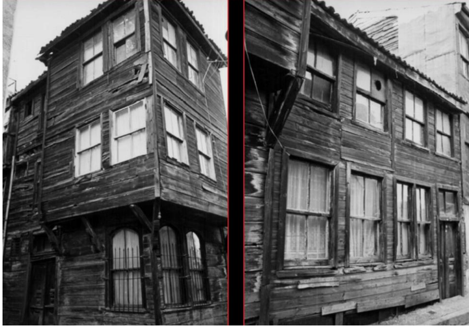
Şekil 4.8 1970'li Yıllarda 26 No'lu Parseldeki Yıkılmış Tescilli Kültür Varlığı Yapılar [44].
