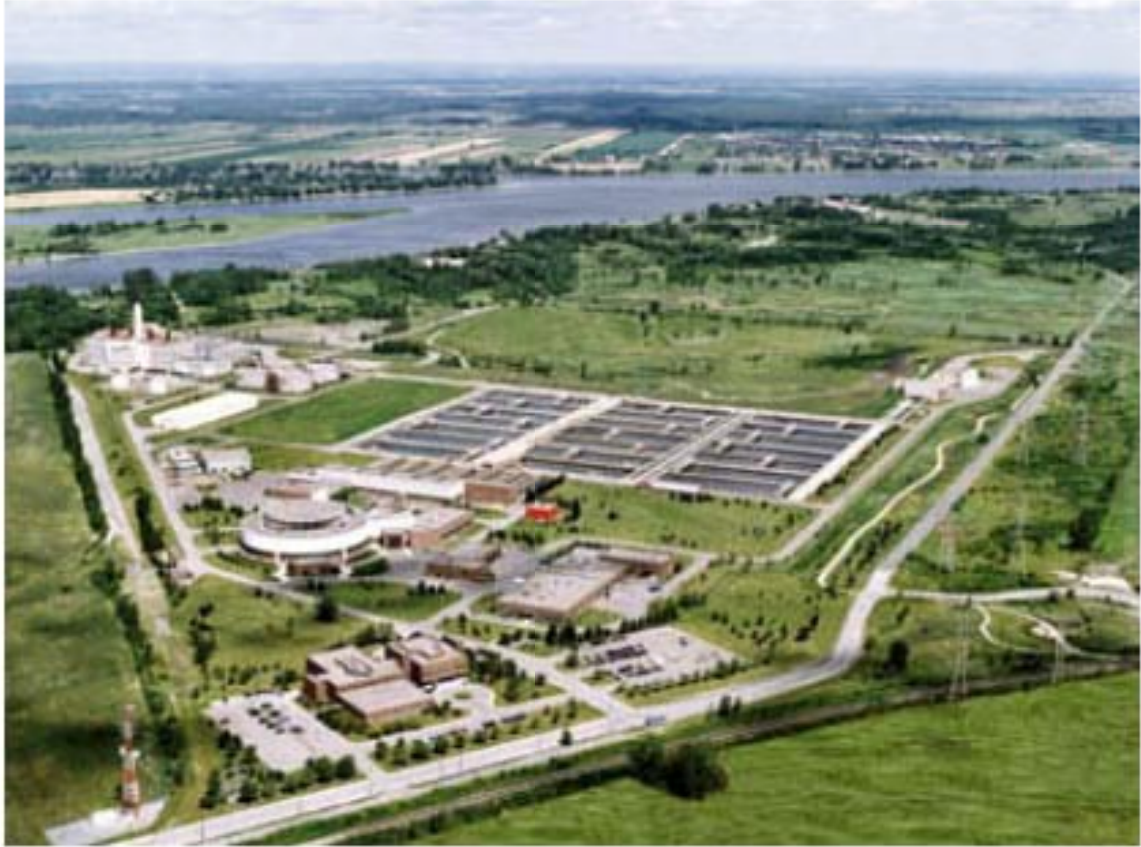
Şekil 2.20 Saint-Laurent nehri suyunun kullanıldığı su arıtma tesisi [4]
