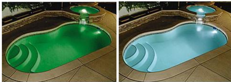
Şekil 5.34 LED ile Havuz Aydınlatma Örneği [95]
