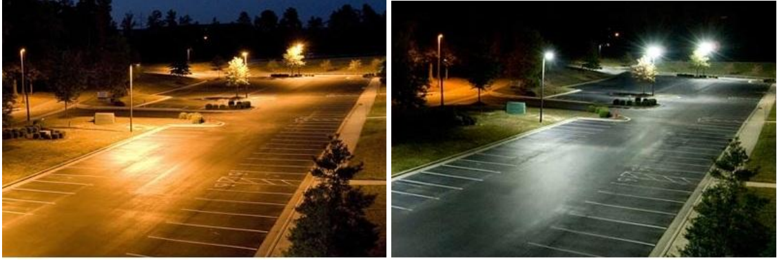
Şekil 5.58 Açık Otopark Örneği (metalik halojenürlü-LED) [117]
