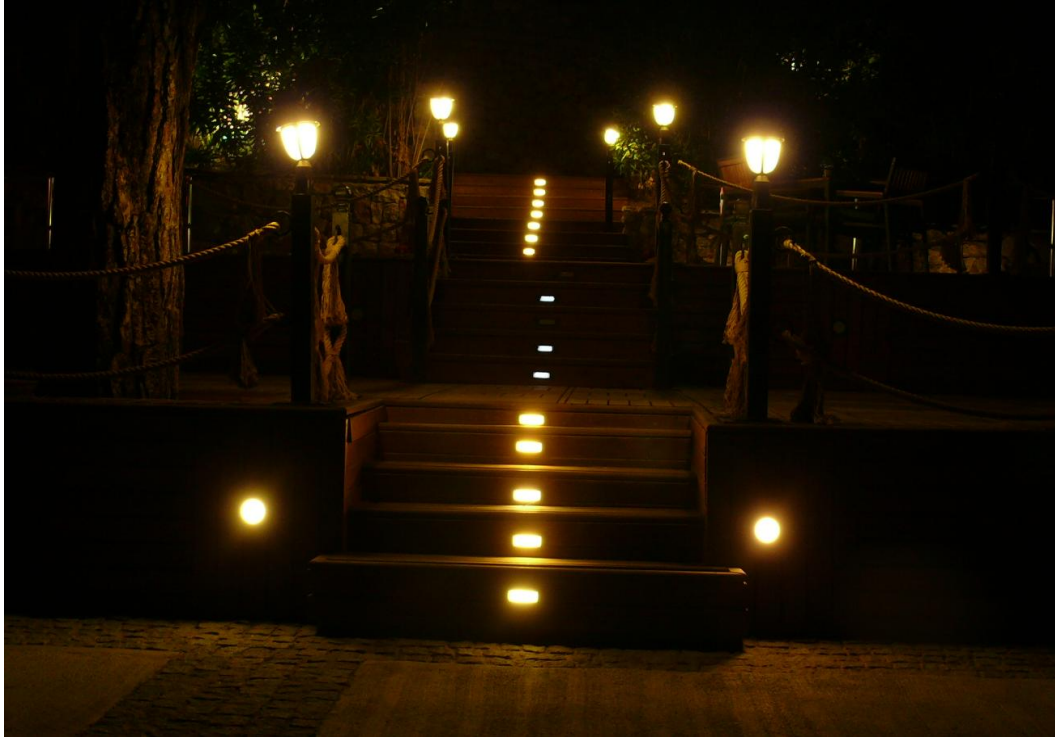
Şekil 7.31 Club Turban Tatil Köyü Merdiven Aydınlatması Örneği
