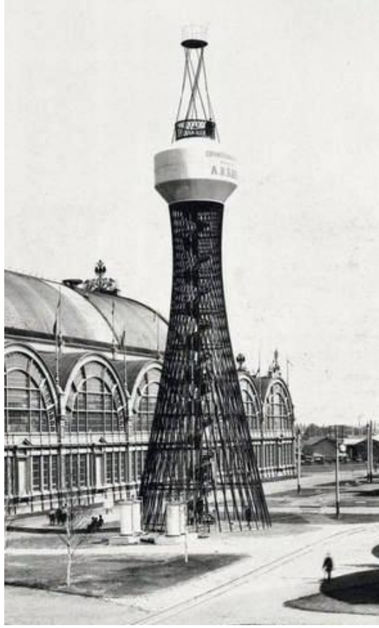
Şekil 4.1 Dünyanın ilk hiperboloit yapısı, Shukhov, 1896 [56]
