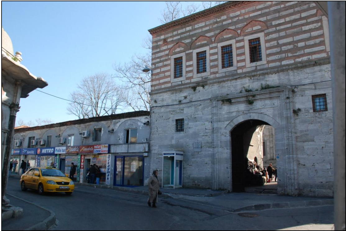
Şekil 5.5 A bölgesi Balaban Sokak görünümü
