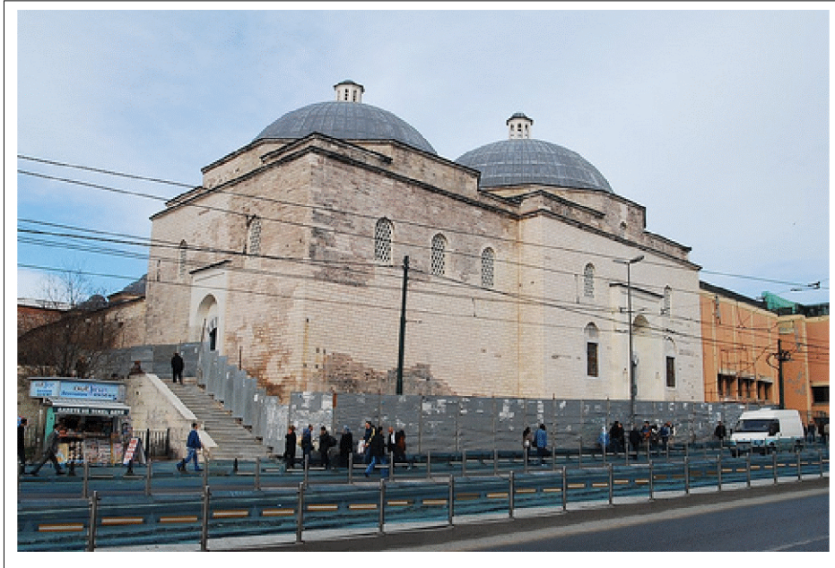
Şekil 4.24 Beyazıt Hamamı Soğukluk Cephesi [32]
