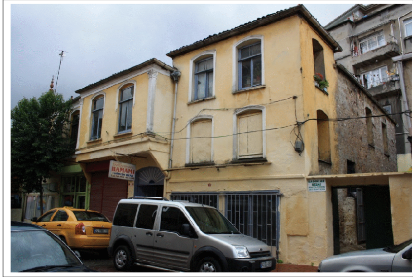
Şekil 4.11 Tahtaminare Hamamı Giriş Kapıları
