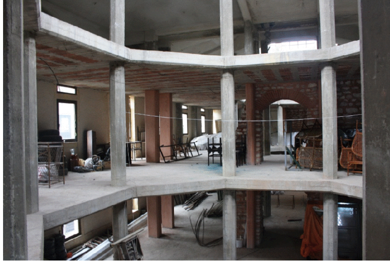
Soğukluk Bölümüne Yapılan Betonarme Ara Katlar
