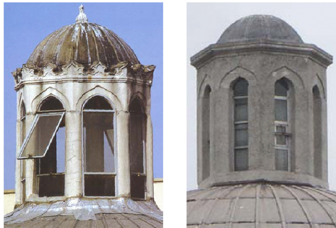
Şekil 3. 5 Soğukluk – Çatı Fenerleri [17]
