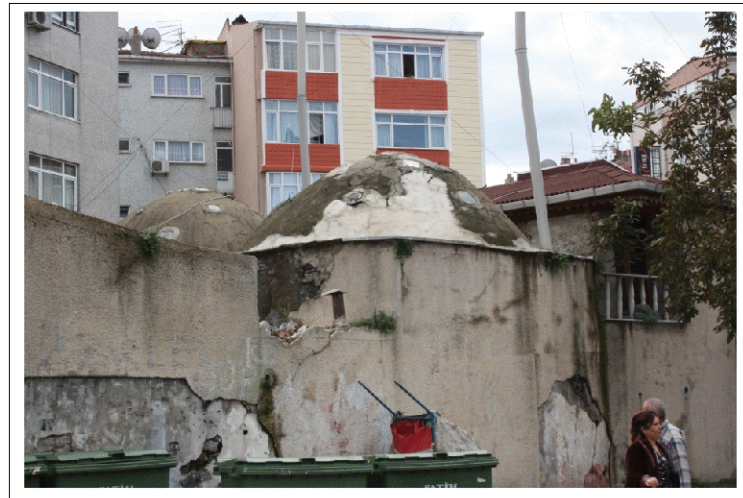
Şekil 4. 21 Küçük Hamam Çatısı
