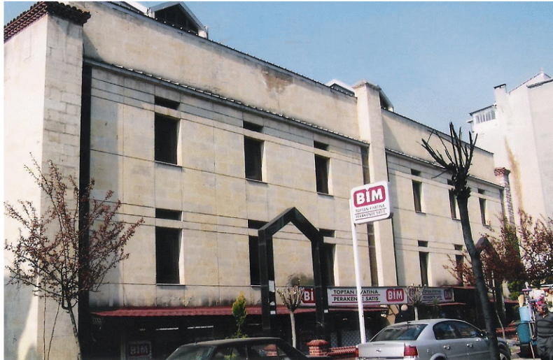
Hamamın Yeni Cephesi
