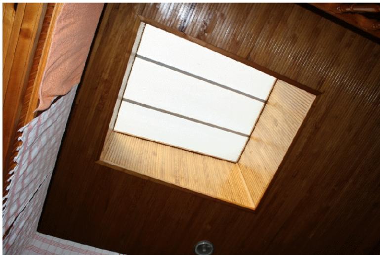
Erkekler Bölümünün Yeni Çatı Feneri
