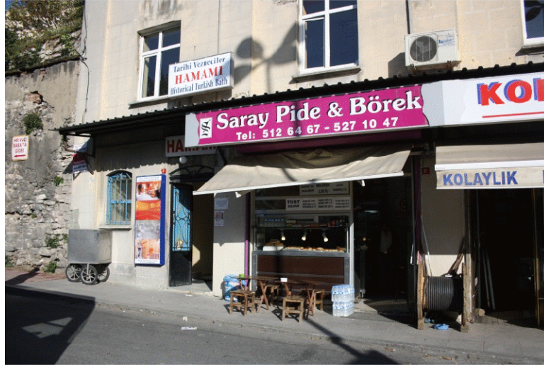
Hamamın Giriş Kapısı
