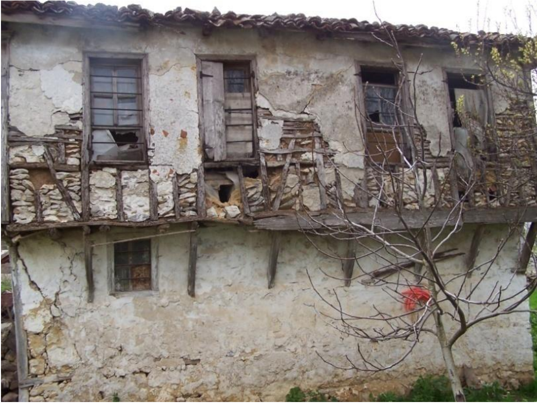
Şekil 5.3 Ahşap hatılların birleşim detayına örnek ( Envanter No:53)
