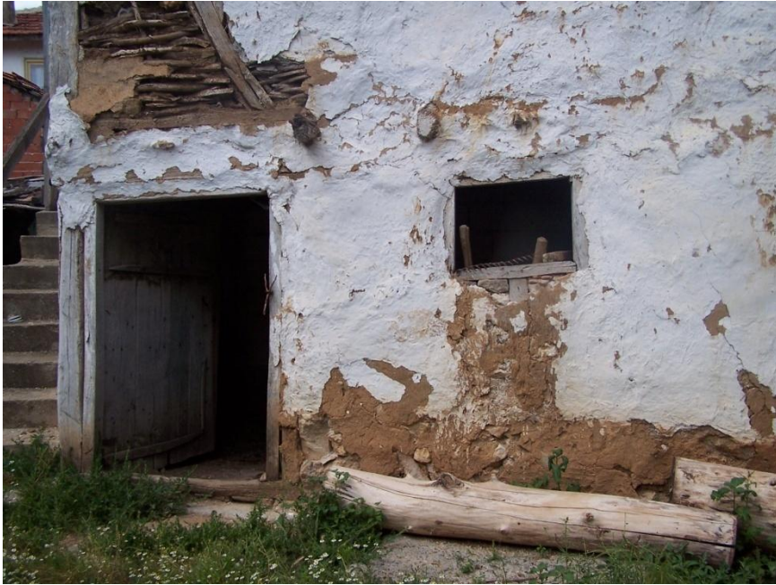
Şekil 4.63 Tek kanatlı ahşap giriş kapısına bir örnek ( Envanter No:2)
