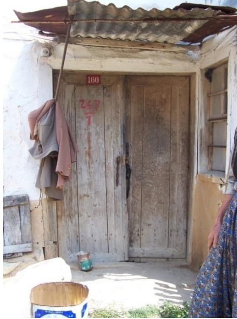
Şekil 4.62 Çift kanatlı ahşap giriş kapısına bir örnek ( Envanter No:32)
