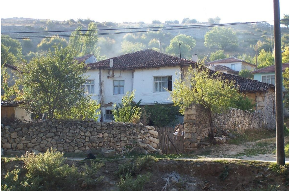
Şekil 5.11 Alaturka kiremit örtülü kırma çatı ( Envanter No:6)
