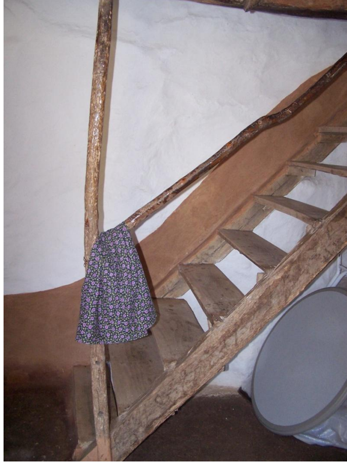
Şekil 4.26 Taşlıktan sofaya çıkışı sağlayan tek kollu merdiven ( Envanter No:41)
