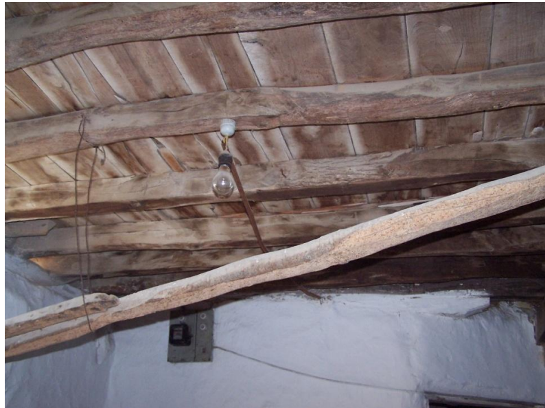
Şekil 4.36 Zemin kat tavanı ( Envanter No:54)
