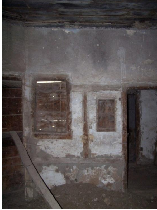
Şekil 6.34 Duvarda yer alan niş ve kapı ve pencere
