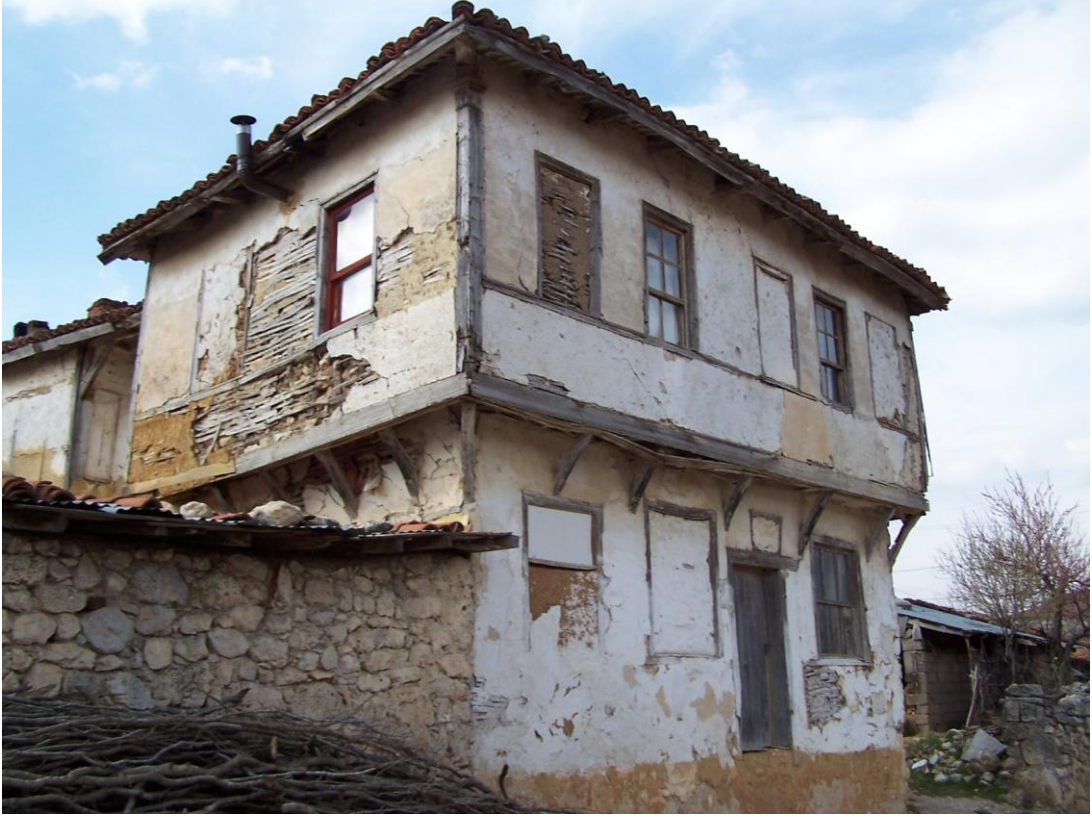
Şekil 4.49 Cephede çift yönde çıkma örneği ( Envanter No:54)
