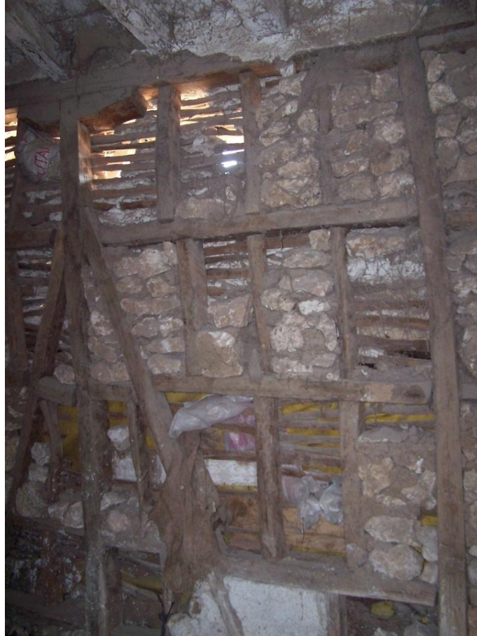
Şekil 5.6 Ahşap taşıyıcı sistem arası moloz taş örneği ( Envanter No:54)
