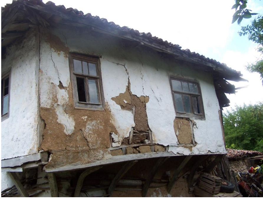
Şekil 5.5 Ahşap taşıyıcı sistem üzeri çamur sıva ve kireç örneği ( Envanter No:27)
