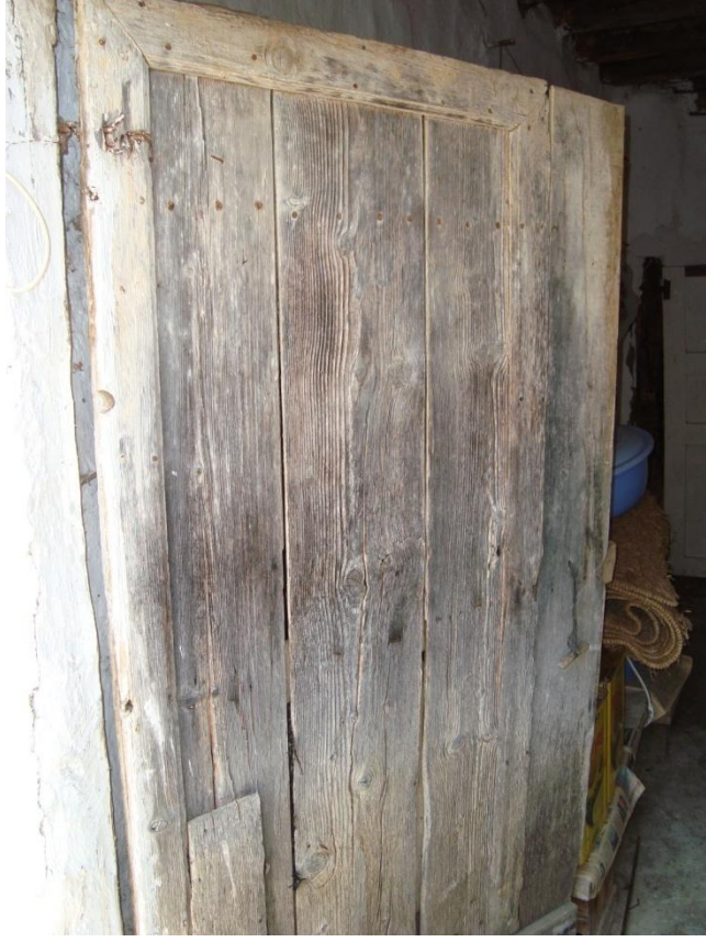
Şekil 4.63 Tek kanatlı ahşap giriş kapısına bir örnek ( Envanter No:2)
