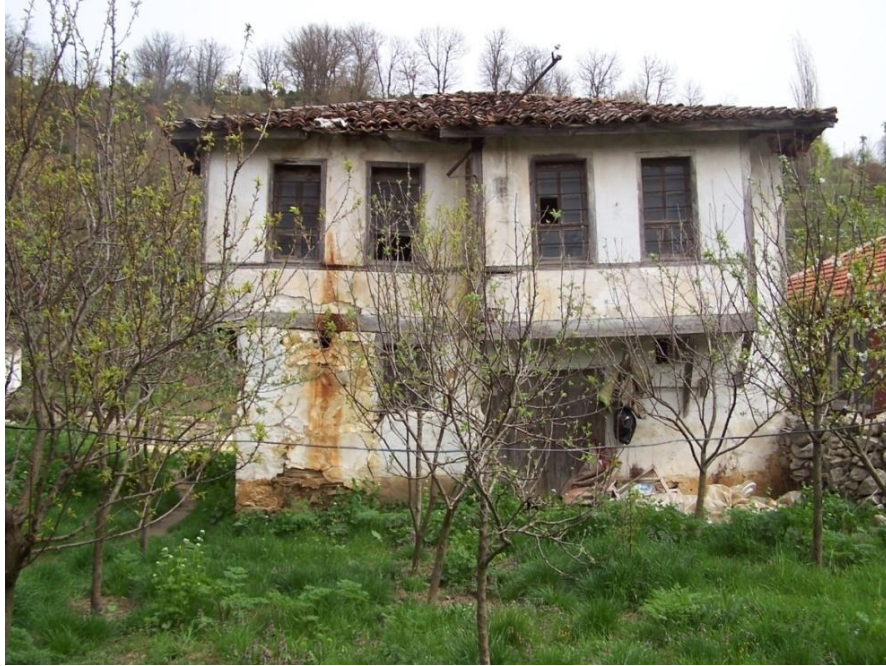
Şekil 5.12 Alaturka kiremit örtülü kırma çatı ( Envanter No:14)
