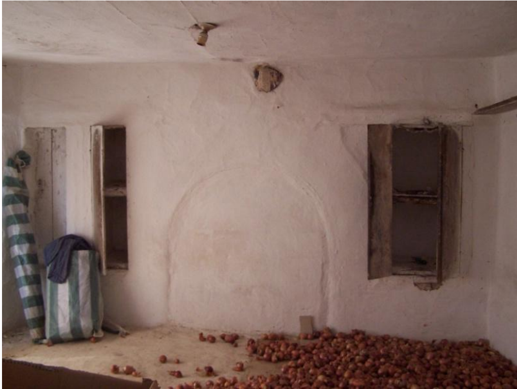
Şekil 4.16 Soğucak evlerinde kapatılmış ocak ve dolaplar ( Envanter No:42)
