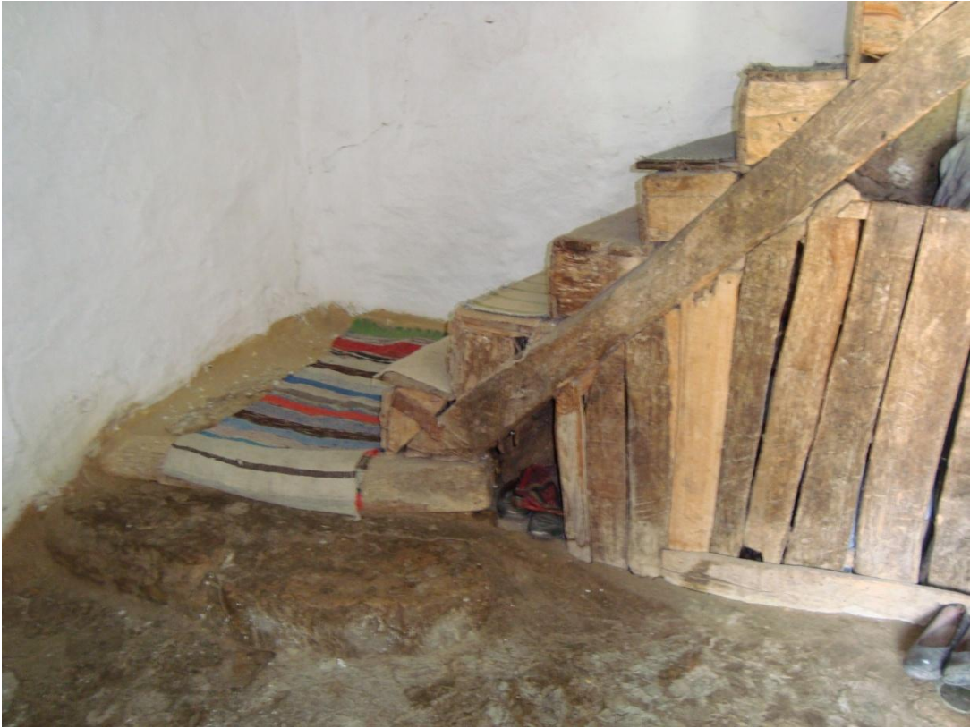
Şekil 5.8 Zemin kat döşemesinde taş kullanılması ( Envanter No:57)
