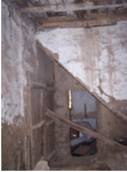
Şekil 6.31 ZK03_Odaya geçişi sağlayan kapı boşluğu
