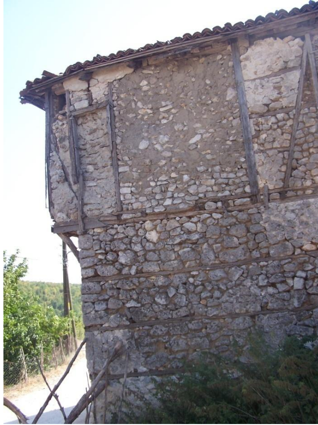
Şekil 4.43 Kuzey cephesi ( Envanter No:54)
