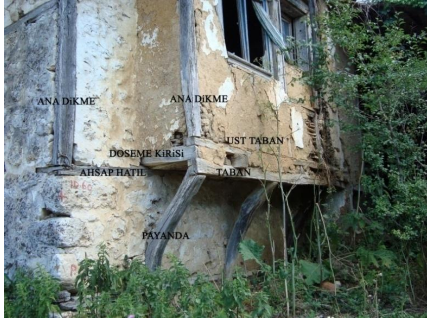
Şekil 4.45 Cephede çıkma oluşturulması ( Envanter No:44)
