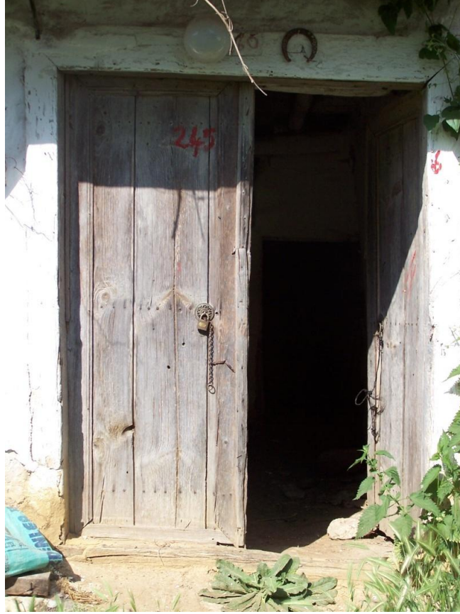
Şekil 4.61 Çift kanatlı ahşap giriş kapısına bir örnek ( Envanter No:31)
