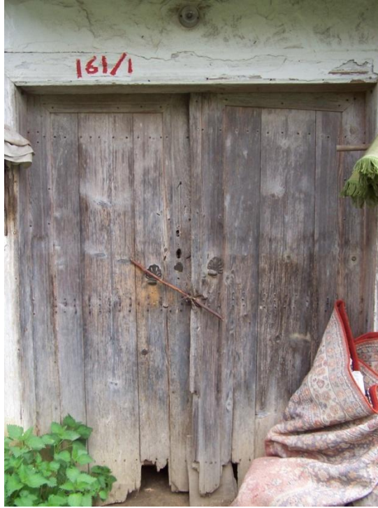
Şekil 4.60 Çift kanatlı ahşap giriş kapısına bir örnek ( Envanter No:14)
