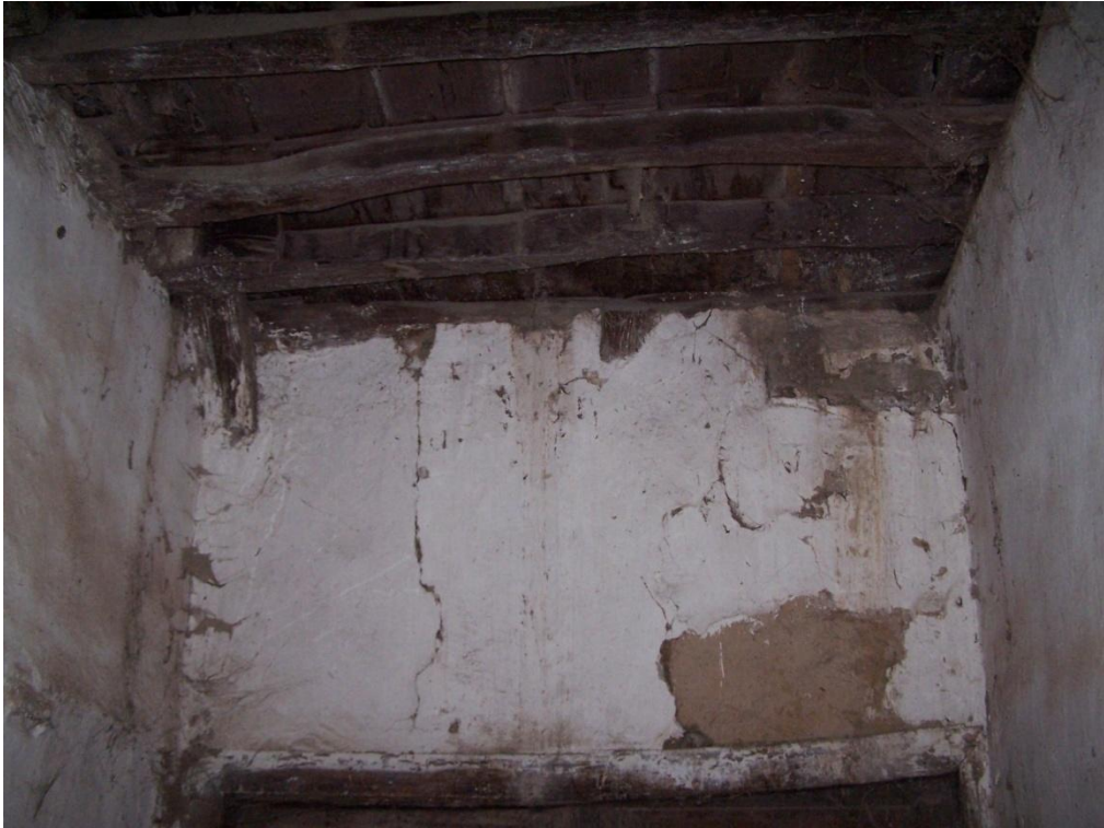
Şekil 5.10 Ahşap kiriş ve döşemelerin yerleşimi ( Envanter No:8)
