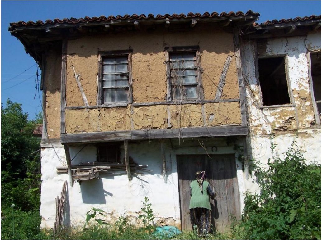
Şekil 4.50 Girişin üstünde konumlanan tek yönde çıkma örneği ( Envanter No:31)
