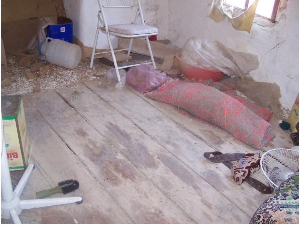
Şekil 4.21 Soğucak evlerinde döşeme kaplaması ( Envanter No:49)
