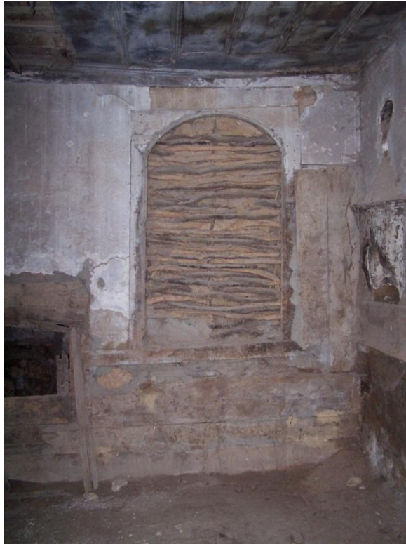
Şekil 6.35 Kapatılan pencere- dolap nişi ve davlumbazlı ocak
