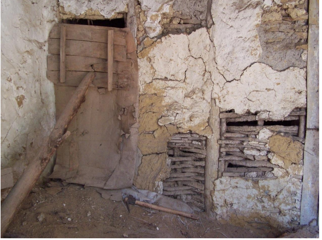
Şekil 6.45 Dış duvardaki hasarlar
