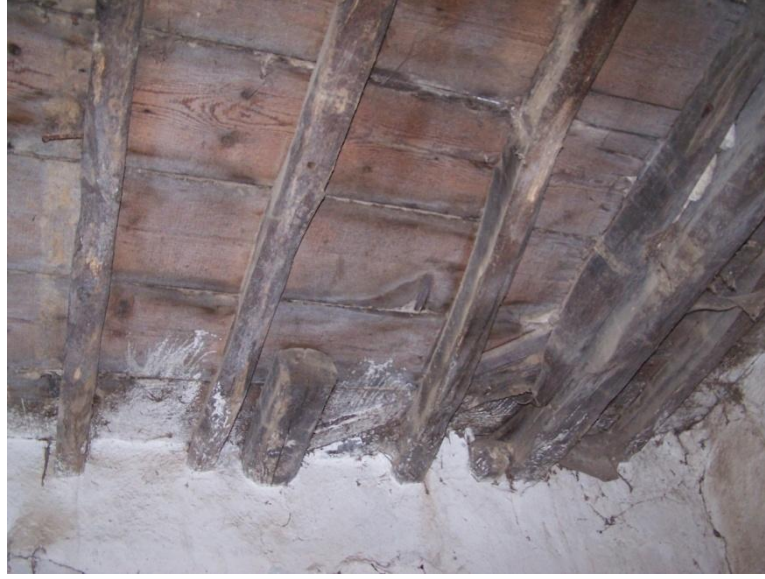
Şekil 6.11 Tavanda gözüken döşeme kirişleri ve üst kat döşeme kaplaması
