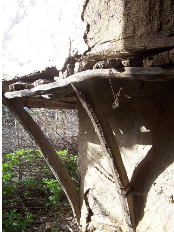
Şekil 4.46 Cephede çıkma oluşturulması ( Envanter No:5)
