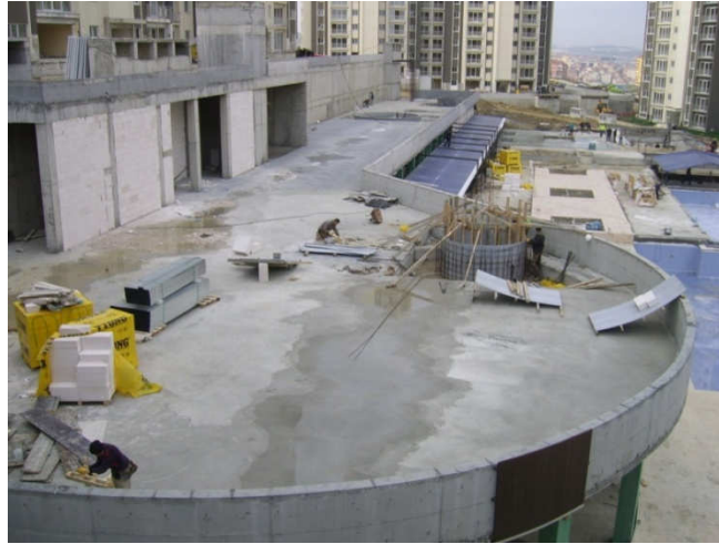
Şekil 6.61 Innovia fitnes binası yapımı görüntüsü
