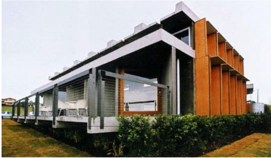
Şekil 3.25 Macarthur bahçeleri eğitim ve tanıtım binası [17]
