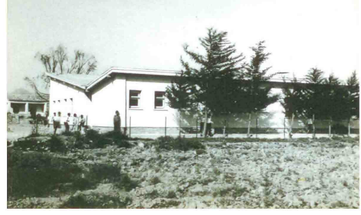
Şekil 5.304 Gönyeli Spor Kulübü (1966-1967), mimarlar Ayer Kaşif, Hakkı Atun
