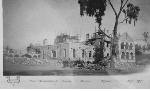
Şekil 5.63 İnşaat halindeki Koloni Yönetimi Vali Konağı binası (1934), güneydoğu yönünden görünüşü
