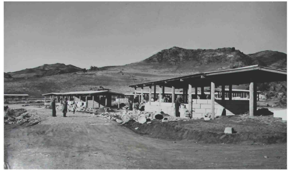
Şekil 4.68 Yeniden kurulan Phasoula köyündeki deprem konutlarının dış duvarları örülüyor.
