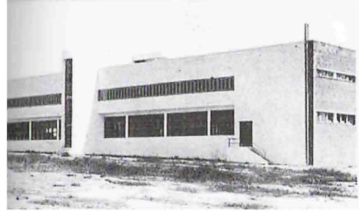
Şekil 5.122 Yetimhane Binası (1936), Lefkoşa, binanın arka cephesi
