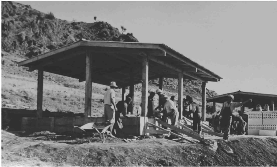
Şekil 4.67 Deprem konutlarının dış duvarları örülüyor.
