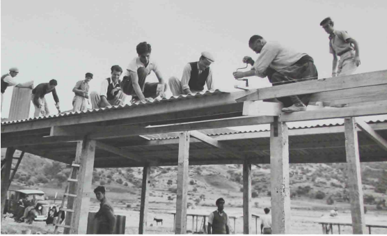
Şekil 4.65 Deprem konutlarının ahşap çatı işleri yapılıyor.
