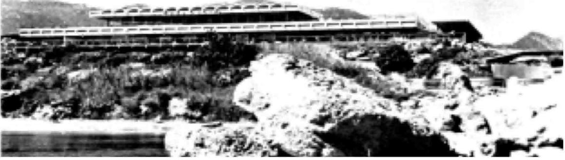
Şekil 5.284 Bands Hotel Mare Monte (1968), Girne, doğu cephesi
