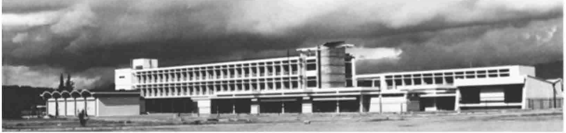
řekil 5.326 Okul kompleksinin dođu görünüşü. [151]
