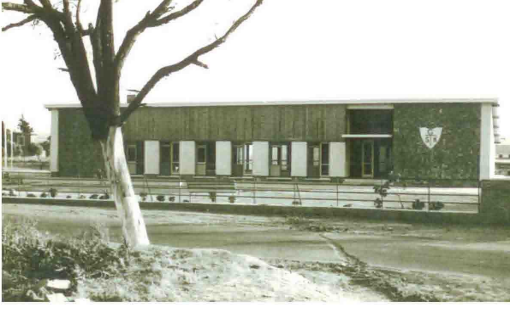
Şekil 5.303 Gönyeli Spor Kulübü (1966-1967), mimarlar Ayer Kaşif, Hakkı Atun
