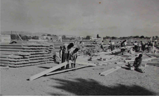
Şekil 4.49 Ktima'daki prefabrik yapı atölyesi
