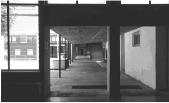
Şekil 5.215 LKL Zemin katlarda yarı açık koridorlar
