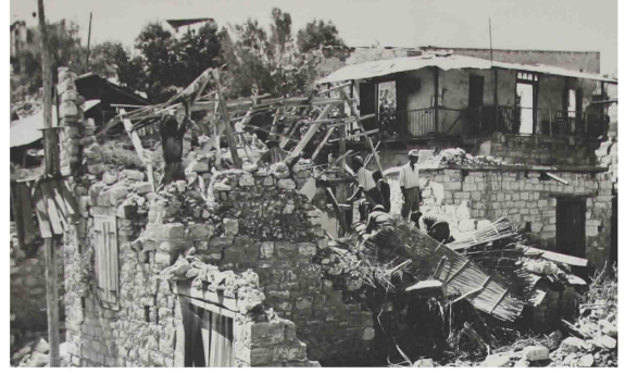
Şekil 4.37 Binaların yoğun inşasından dolayı depremde çöken yapılar
