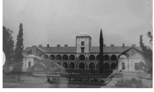
Şekil 5.62 Koloni Yönetimi Vali Konağı binası (1934), arka cephe ve bahçeden görünüş
