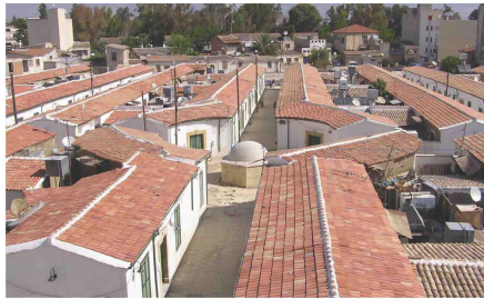
Şekil 5.86 Samanbahçe Konutları (1900- 55), UNDP rehabilitasyonundan sonra görünüş [86]
