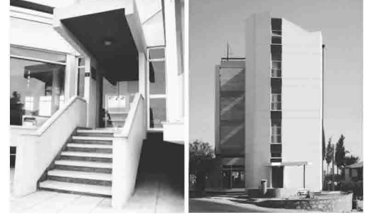
Şekil 5.332 Gabrielides Ofis Binası (1962), showroom ve ofis binasına girişler [152]
