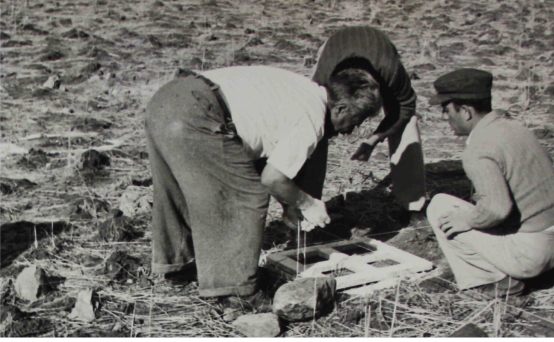
Şekil 4.55 Deprem konutlarının yerleşim düzeni için kurulan ip iskele ile kolon kazı noktaları işaretleniyor.
