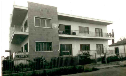
Şekil 5.301 Turan Timur Evi (1960-1961), Lefkoşa, mimarlar Ayer Kaşif, Hakkı Atun
