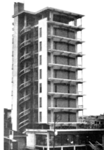
Şekil 5.166 Demetriou Apartmanı (1959), Lefkoşa, bina ön cephesinden görünüş
