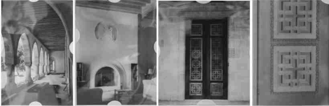
Şekil 5.72 Koloni Yönetimi Vali Konağı binası (1934), sırasıyla; batı kanadı koridoru, yaşam ünitesi, oturma salonu, avlu kapısı, tavan detayı
