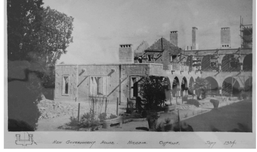
Şekil 5.64 İnşaat halindeki Koloni Yönetimi Vali Konağı binası (1934), arka cephe batı kanadına bakış
