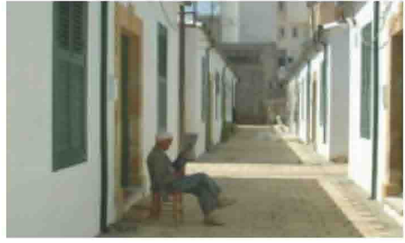
Şekil 5.87 Samanbahçe Konutları (1900-55), UNDP rehabilitasyonundan sonra görünüş [86]
