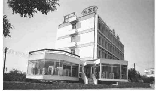
Şekil 5.330 Gabrielides Ofis Binası (1962), yapının ön cephesi [152]
