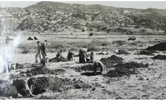
Şekil 4.59 Deprem konutlarının sütunlarının yerleşeceği yuvalar için kalıplar kuruluyor.
