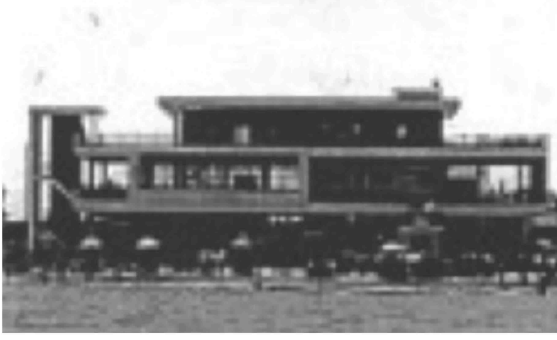
Şekil 5.239 Alashia Restorant, Mağusa
