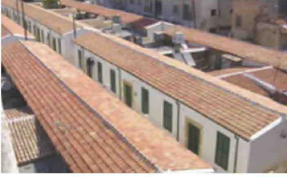
Şekil 5.86 Samanbahçe Konutları (1900-55), UNDP rehabilitasyonundan sonra görünüş [86]
