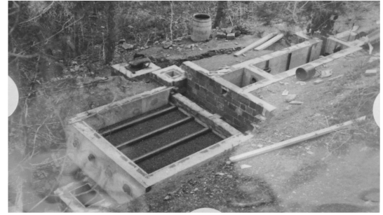
Şekil 5.68 İnşaat halindeki Koloni Yönetimi Vali Konağı binası (1934), septik tanktan görünüş
