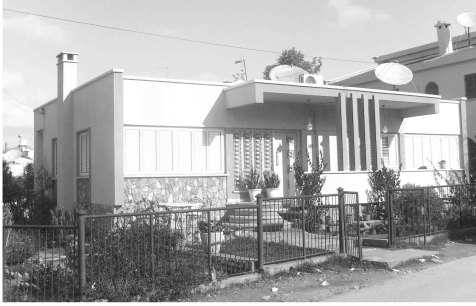
Şekil 5.106 Tek katlı konut, Lefkoşa, ön cephe
