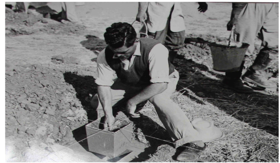
Şekil 4.60 Deprem konutlarının sütunlarının yerleşeceği yuvaların kalıpları çıkartılıyor.
