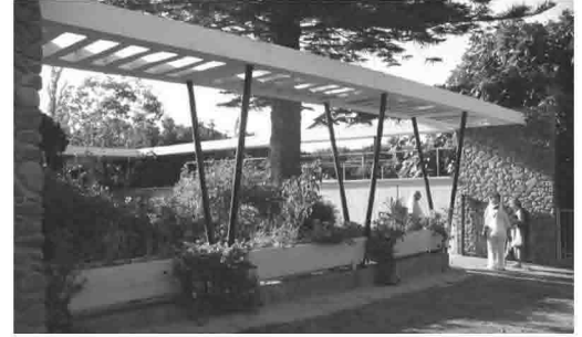
Şekil 5.197 Dr. Sömek Evi (1957), ön avluyu ayıran betonarme saçağı
