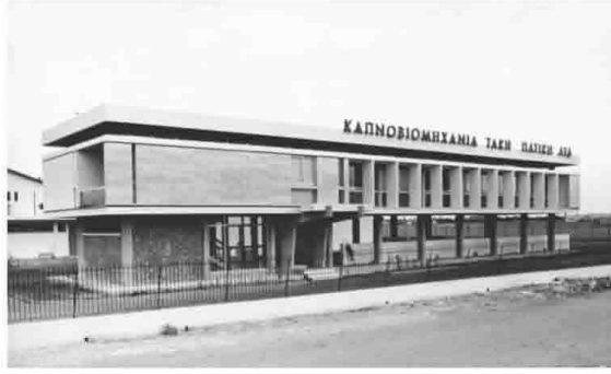
Şekil 5.344 Binanın yoldan görünüşü [155]
