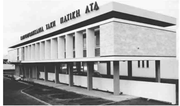
Şekil 5.348 Yapının pilotiler altında olan garaj bölümü ve üstte ofisler [155]
