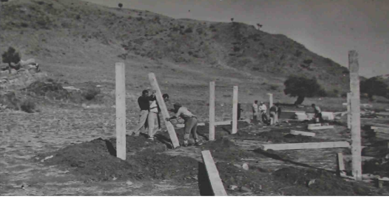
Şekil 4.61 Deprem konutlarının kolonları dikiliyor.
