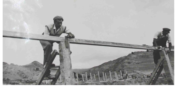
Şekil 4.62 Deprem konutlarının kolonları ve çatı kirişleri kuruluyor.
