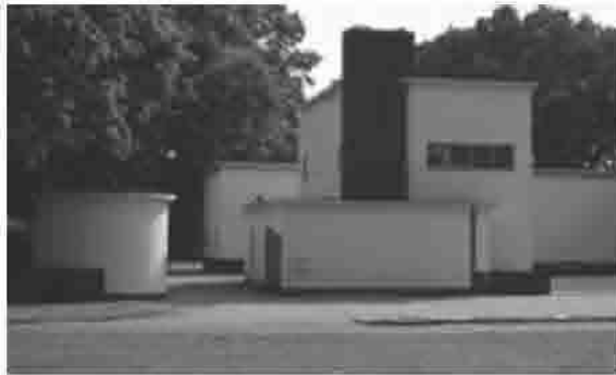
Şekil 5.138 Kuzeydeki Mezarlık Oditoryumu (1927-1930), Hilversum, Hollanda [118]
