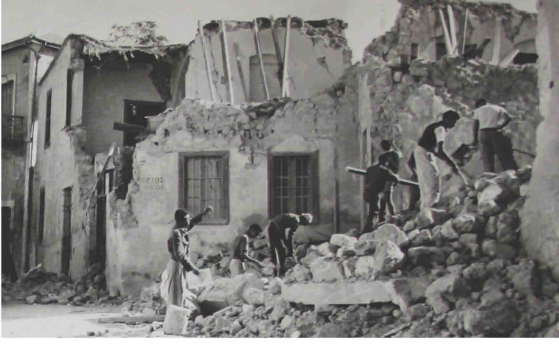
Şekil 4.36 Binaların yoğun inşasından dolayı depremde çöken yapılar
