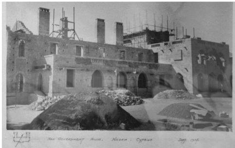
Şekil 5.59 İnşaat halindeki Koloni Yönetimi Vali Konağı binası (1934), ön cepheden görünüş
