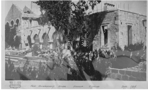
Şekil 5.67 İnşaat halindeki Koloni Yönetimi Vali Konağı binası (1934), batı kanadına bakış
