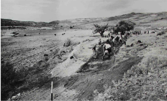
Şekil 4.51 Deprem konutlarının kurulacağı alanlardan birine yol açılıyor.
