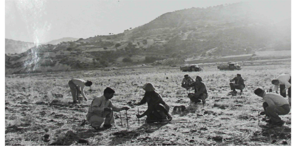
Şekil 4.54 Deprem konutlarının yerleşim düzenini sağlamak için ip iskelesi kazıklarını çakan işçiler
