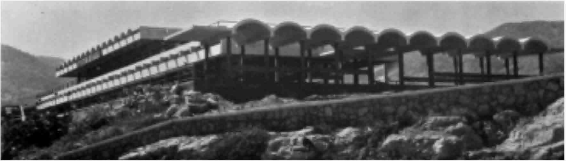
Şekil 5.285 Bands Hotel Mare Monte (1968), Girne, kuzey ve doğu cephesi
