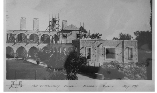
Şekil 5.66 İnşaat halindeki Koloni Yönetimi Vali Konağı binası (1934), arka
