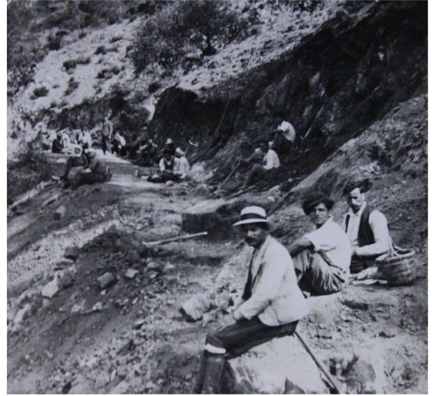
Şekil 4.32 Trodos dağının güney eteklerinde ulaşılamayan ormanlıklara doğru inşa edilen dağ yolu inşaatı
