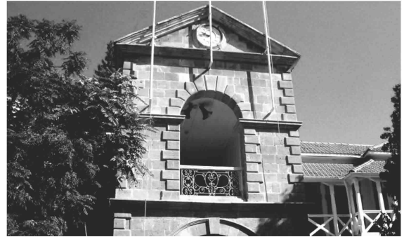
Şekil 5.6 Lefkoşa yeni Konak Binası (1900-04), giriş üzerindeki balkon [73]
