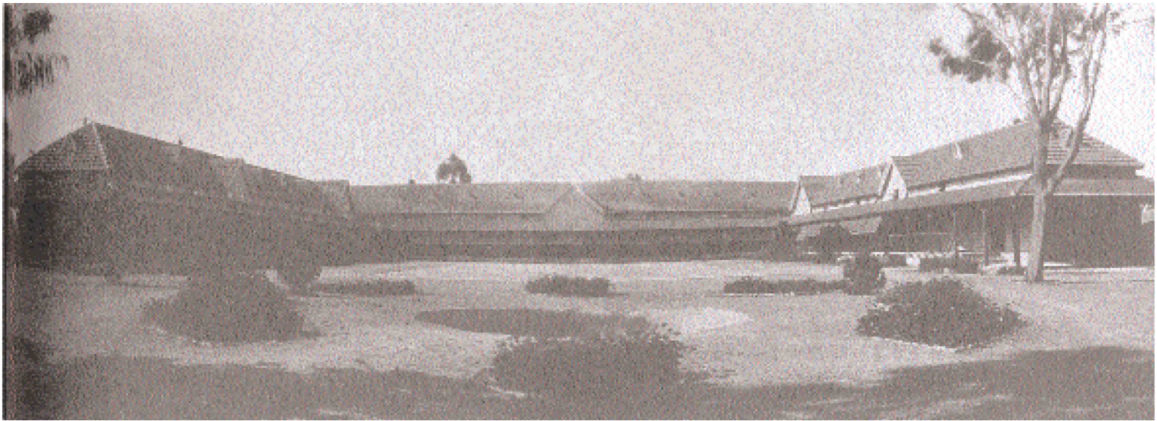
Şekil E.51 Prefabrik Kıbrıs Hükümet Konağı; yapının bahçeden görünüşü [66]
