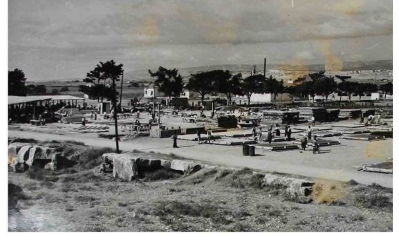
Şekil 4.48 Ktima'daki prefabrik yapı atölyesi
