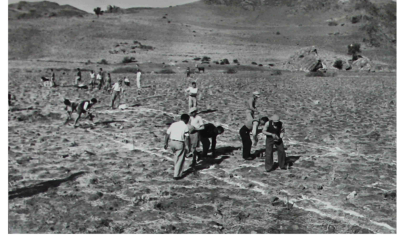
Şekil 4.56 Deprem konutlarının temel çizgileri çiziliyor.
