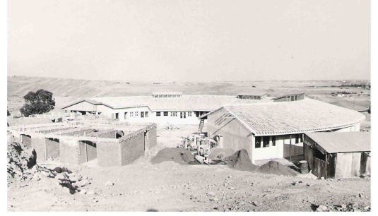
Şekil 5.352 Güçsüzler Yurdu (1968), Gönyeli, inşaattan görünüş
