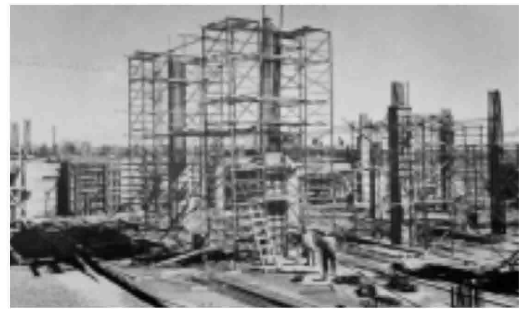
Şekil 5.283 Yüksek katlı bina iskelesi ve beton kalıpları (1966)
