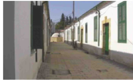
Şekil 5.87 Samanbahçe Konutları (1900- 55), UNDP rehabilitasyonundan sonra görünüş [86]
