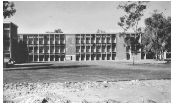
Şekil 5.218 LKL güneş kontrolü elemanları ile donatılmış doğu cephesi
