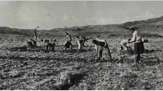
Şekil 4.57 Deprem konutlarının temelleri kazılıyor.
