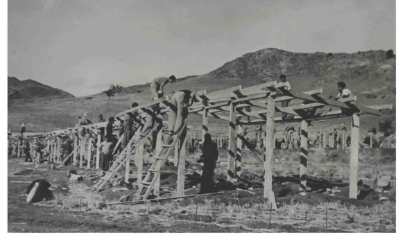
Şekil 4.64 Şekillenmekte olan yeni Phasoula köyünün deprem konutlarının ahşap çatı işleri yapılıyor.
