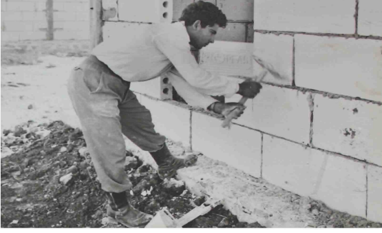
Şekil 4.69 Yeniden kurulan Phasoula köyündeki deprem konutlarından birinin örülmüş dış duvarlarının harç artıkları temizleniyor.
