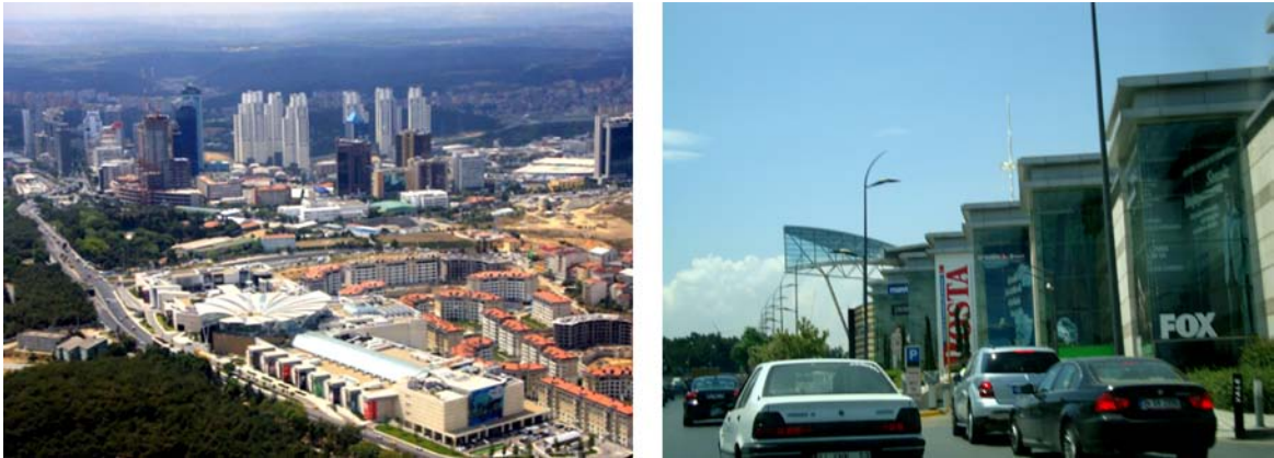
Şekil 5.16 İstinye Park Alışveriş Merkezi'nin genel görünümü ve cadde cephesinden görünümü (Düştegör, 2010; [32])
