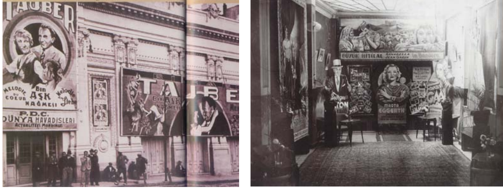
Taksim sinemasının dış görünümü ve fuayesi (Evren, 1998)
