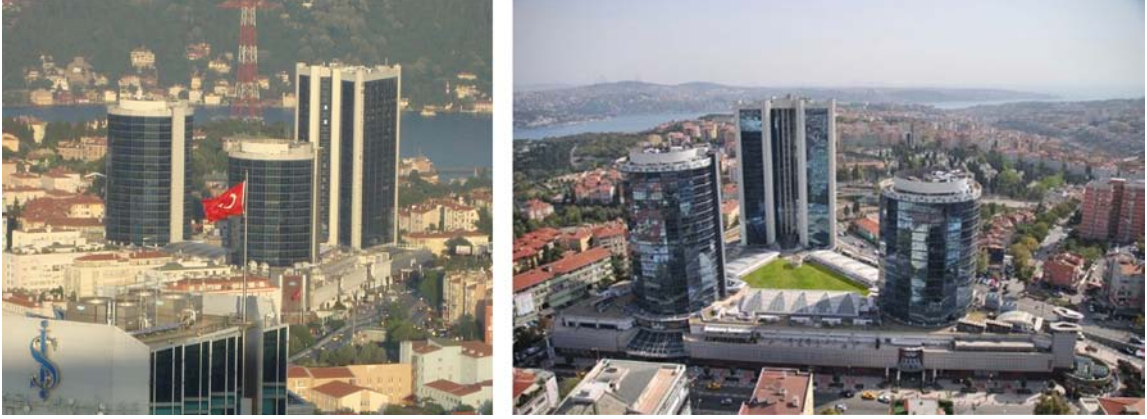
Şekil 5.20 Akmerkez Alışveriş Merkezi'nin genel görünümü (Düştegör, 2010; [1])
