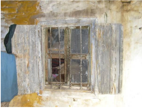
Şekil 5.25 Ahşap kepenkli, metal parmaklıklı, çift kanatlı ahşap pencereler
