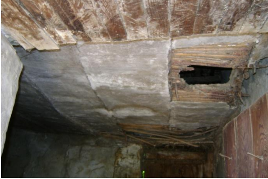
Şekil 5.41 Sehimi yapmış ve malzeme kaybına uğramış bağdadi sıvalı tavan kaplaması ve aşınmış ve sehimi yapmış pasalı ahşap tavan kaplaması
