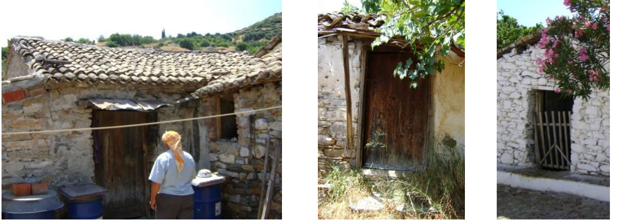
Şekil 5.33 Samanlık kapısı ve sac saçığı, müştemilat kapısı ve ahşap strüktürlü, alaturka kiremit üst örtülü saçığı ve ahır kapısı
