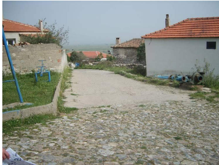
Şekil 5.44 Betona dönüştürülmüş taş kaplı sokak
