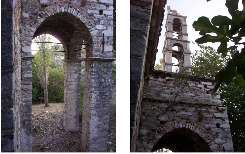
Şekil 9.30 Taş payelerin ve mermer çan kulesinin kuzey görünüşü
