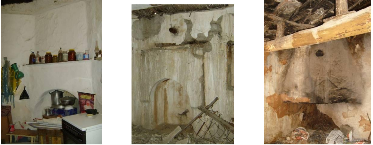
Şekil 5.29 Yapı köşesindeki ocak, duvarın ortasındaki ocak ve yapı köşesindeki eliptik ocak
