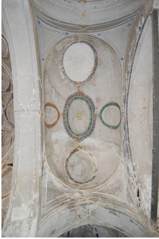
Şekil 9.40 Ana kubbeden sonra yer alan eliptik kubbe
