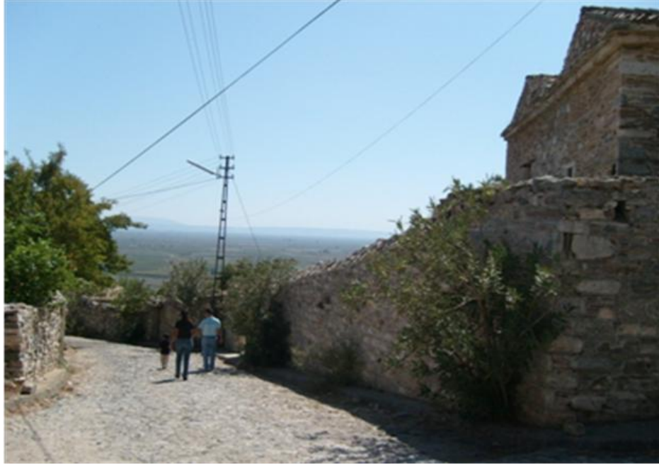
Şekil 9.7 Yapının samsun caddesine bakan bahçe duvarları ve cephesi
