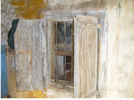
Şekil 5.40 Aşınmış ahşap pencere doğramaları, paslanmış metal parmaklıklar ve doğraması yok olmuş pencere açıklığı
