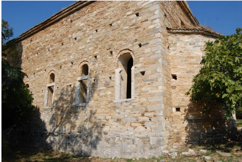
Şekil 9.47 Yapının güneybatı yönündeki duvar birleşim detayı
