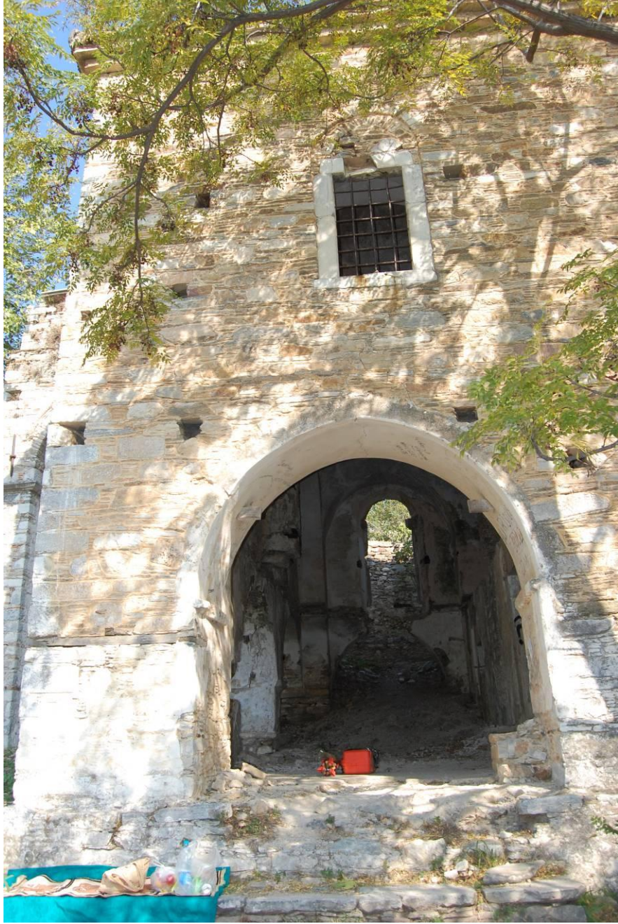
Şekil 9.21 Narteksin güney görünüşü
