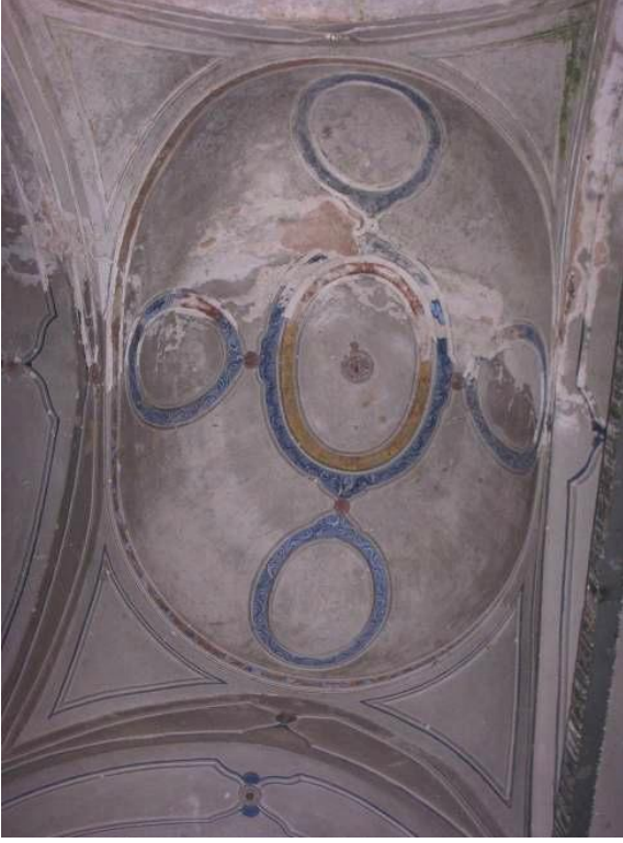
Şekil 9.42 Doğu batı yönünde uzanan eliptik kubbeden sonra yer alan eliptik kubbe ve eliptik kubbeden sonra yer alan beşik tonoz
