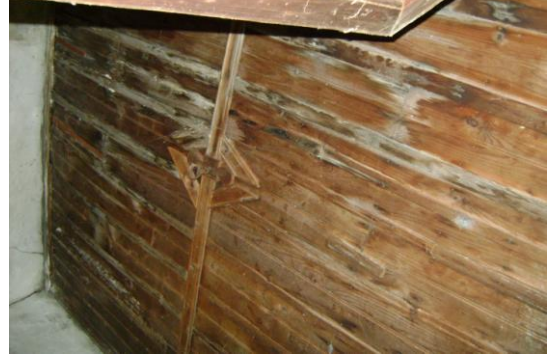
Şekil 5.41 Sehimi yapmış ve malzeme kaybına uğramış bağdadi sıvalı tavan kaplaması ve aşınmış ve sehimi yapmış pasalı ahşap tavan kaplaması
