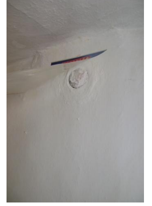
Şekil 5.42 Kısmen mevcut konutların yıkılmış ocakları ve ayaktaki konutun kapatılmış ocağı
