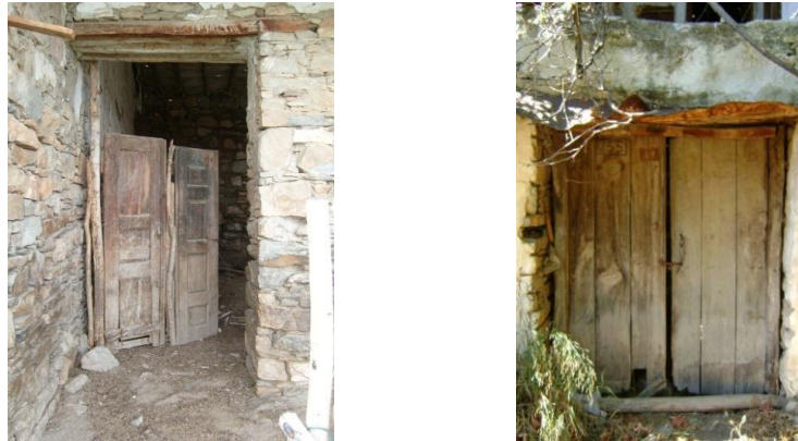
Şekil 5.24 Çift kanatlı aynalı tablalı ahşap kapı ve çift kanatlı tahta kapı
