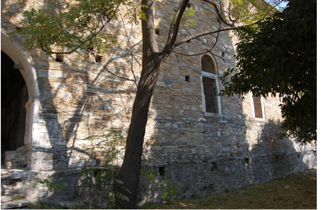
Şekil 9.22 Güney cephesinde yer alan pencere açıklıklarının görünüşü
