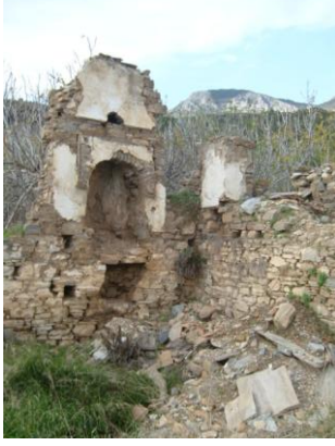
Şekil 5.42 Kısmen mevcut konutların yıkılmış ocakları ve ayaktaki konutun kapatılmış ocağı
