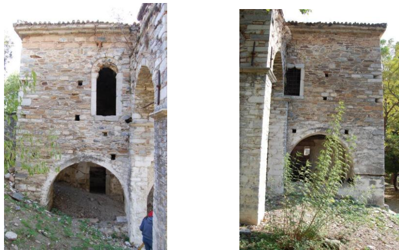
Şekil 9.26 Narteksin batı cephesinin kuzey ve güney yanları
