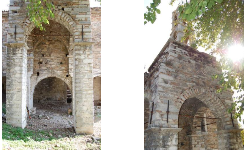
Şekil 9.25 Taş payelerin ve çan kulesinin batı cephesi
