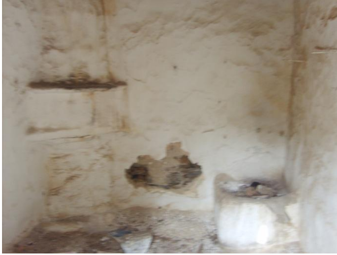
Şekil 5.36 Müştemilatlardaki üzeri sıvalı ocaklar
