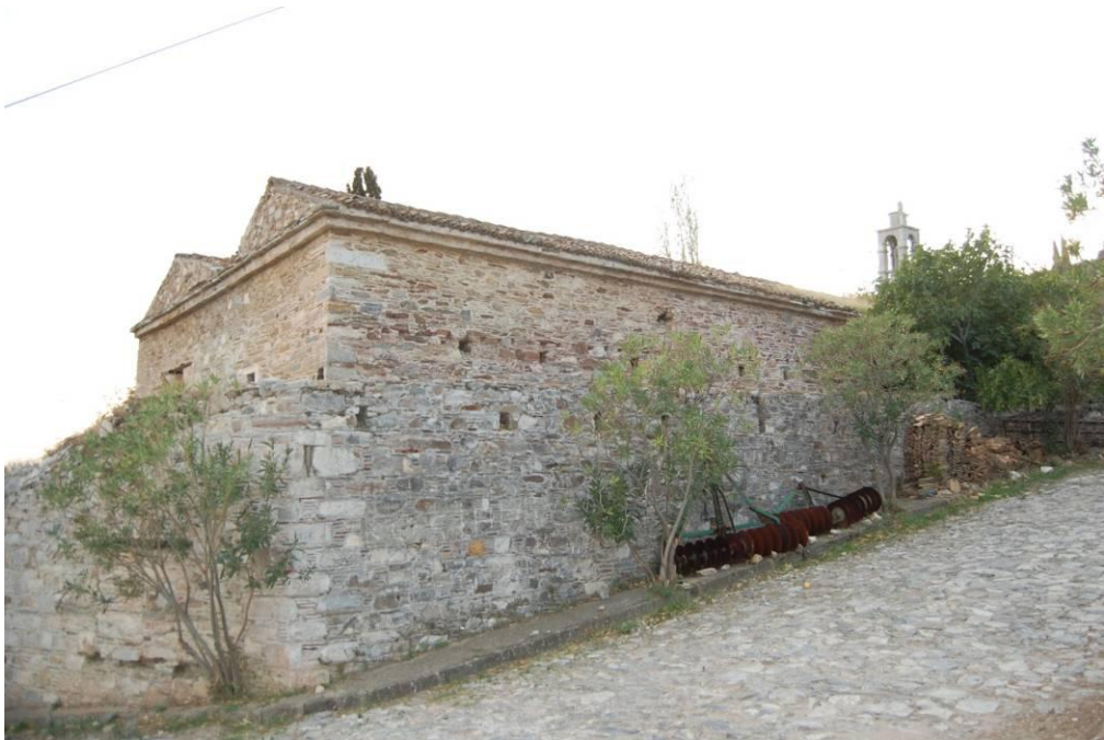
Şekil 9.2 Bahçe duvarları ile çevrilmiş yapının kuzeydoğu cephesi
