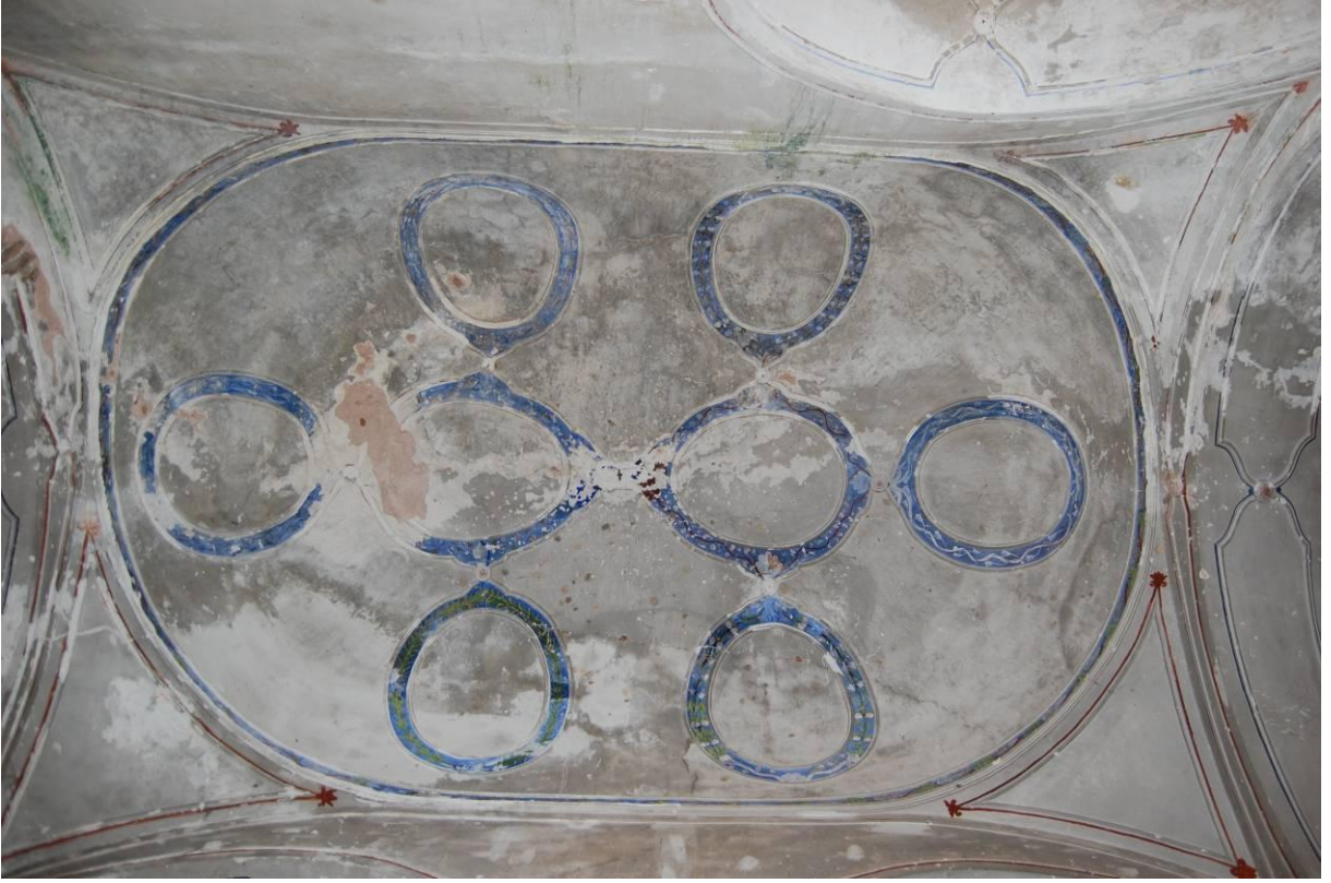
Şekil 9.41 Yan nefte, narteskten uzanan yarım tonozdan sonra, yer alan eliptik kubbe
