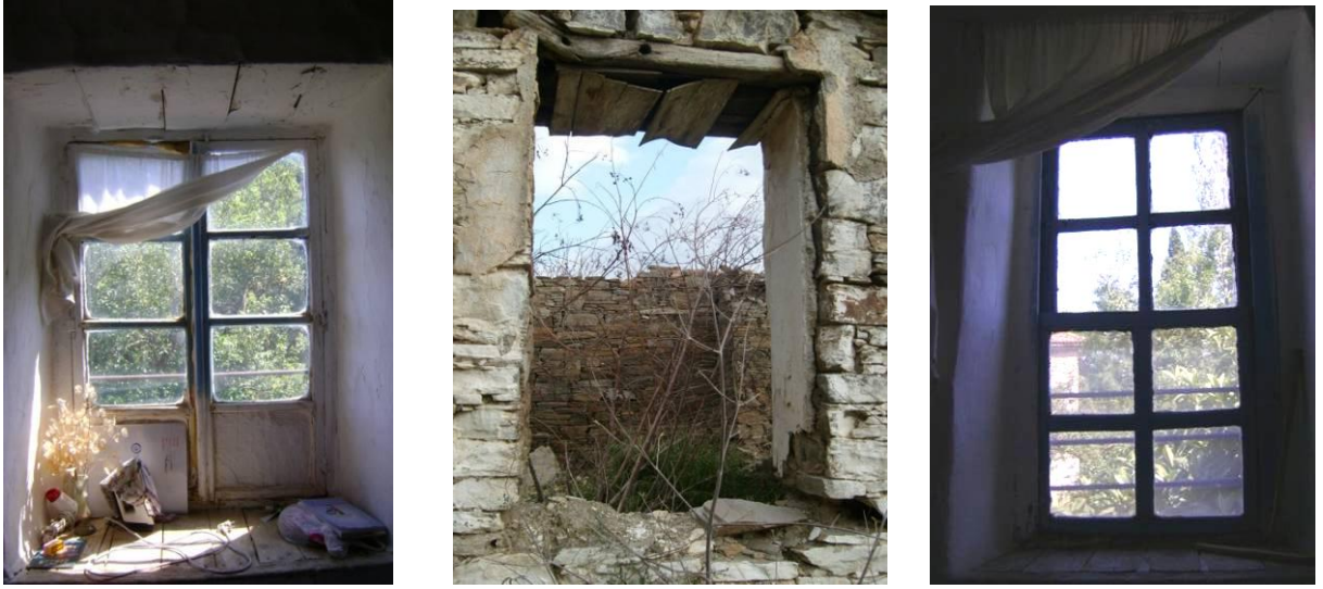
Şekil 5.26 Çift kanatlı ahşap pencere, pencere açıklığı ve giyotin ahşap pencere
