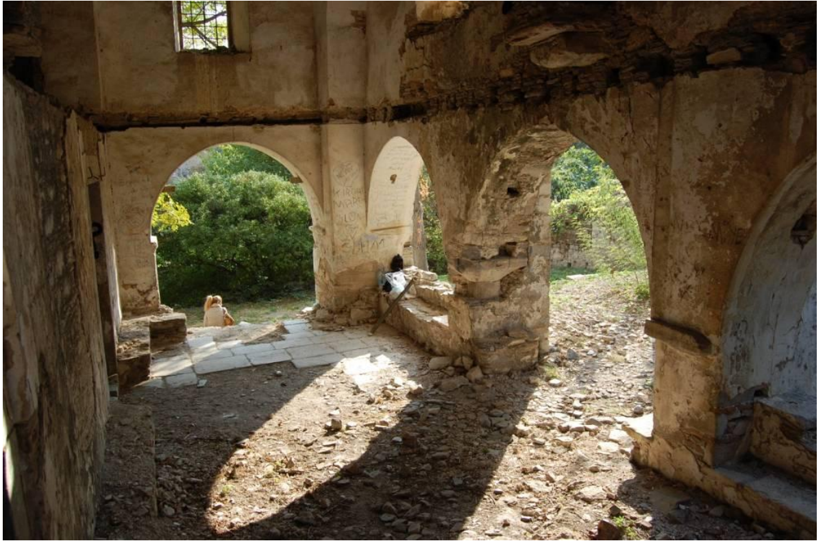
Şekil 9.9 Narteksin güney ve batı yönündeki duvarları
