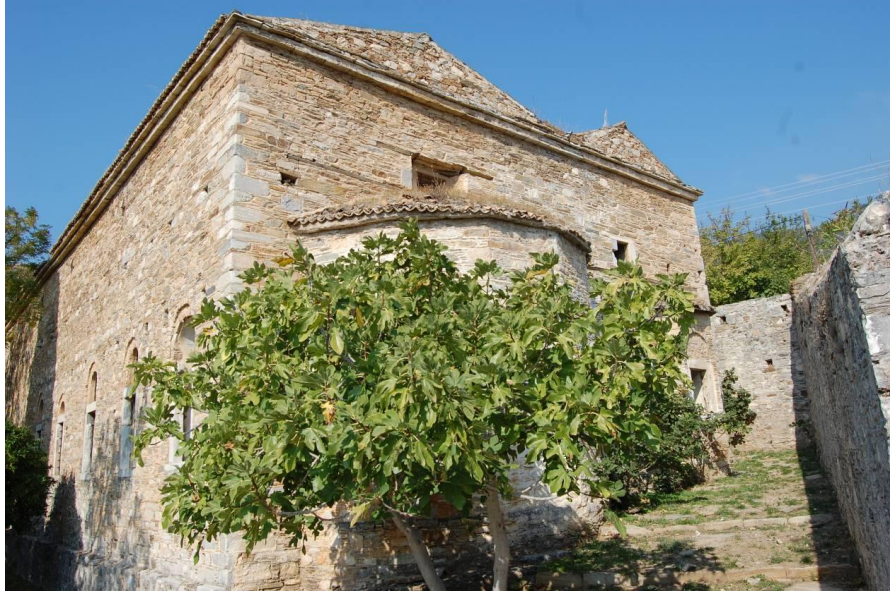
Şekil 9.31 Kilisenin güneydoğu cephesi
