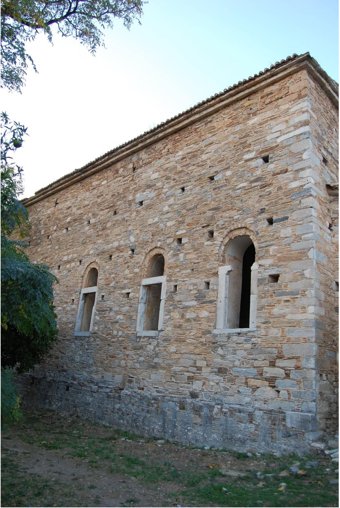
Şekil 9.23 Güney cephesinde yer alan pencere açıklıklarının görünüşü
