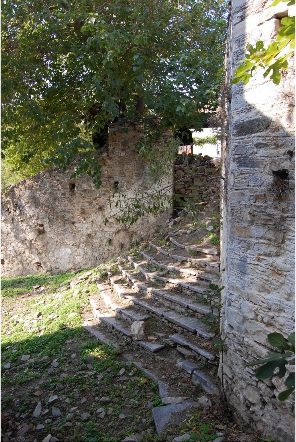
Şekil 9.6 Yapının örülerek kapatılmış özgün bahçe girişi
