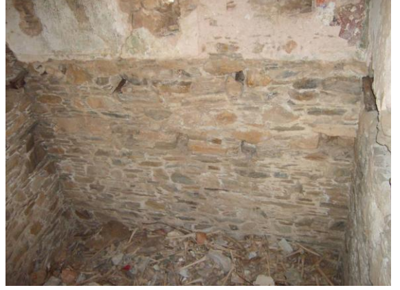
Şekil 9.56 Kemikliğın zeminindeki kemikler ve duvarlarındaki ahşap hatıl boşlukları
