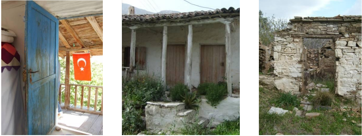
Şekil 5.23 Tek kanatlı ahşap kapılar ve kapı açıklığı
