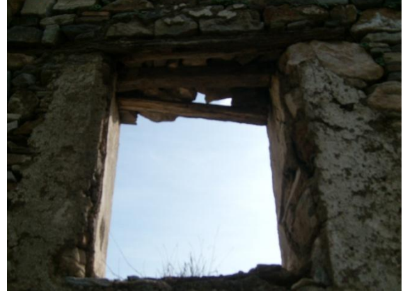
Şekil 5.40 Aşınmış ahşap pencere doğramaları, paslanmış metal parmaklıklar ve doğraması yok olmuş pencere açıklığı
