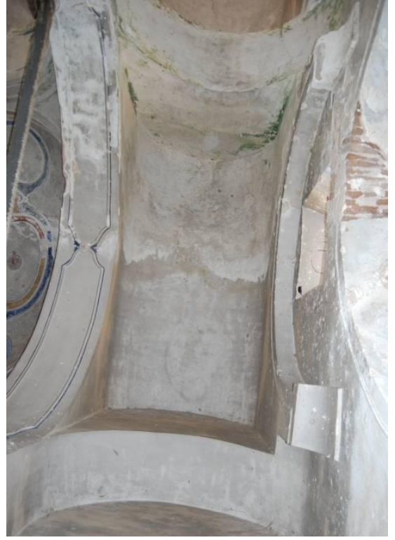
Şekil 9.42 Doğu batı yönünde uzanan eliptik kubbeden sonra yer alan eliptik kubbe ve eliptik kubbeden sonra yer alan beşik tonoz
