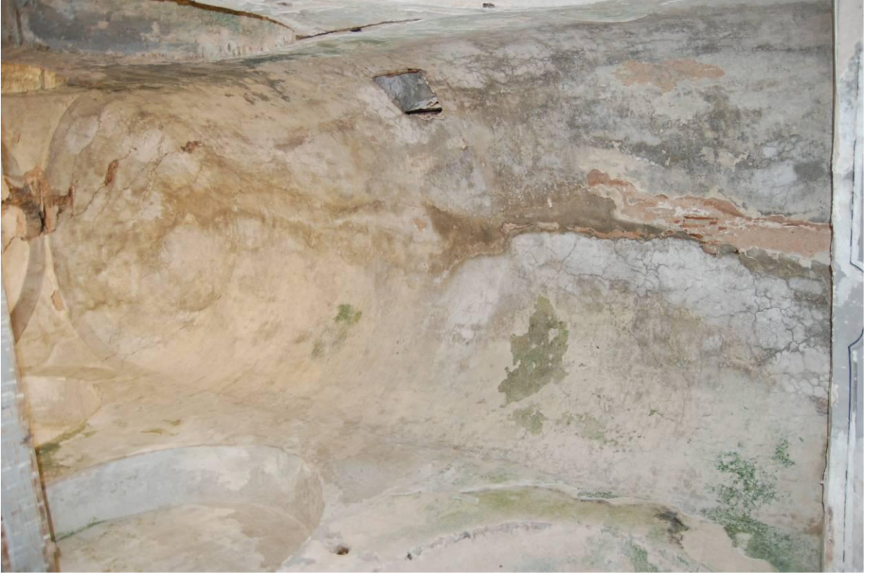
Şekil 9.77 Narteks kısmı ile yan nef arasında bulunan tonozu bakış
