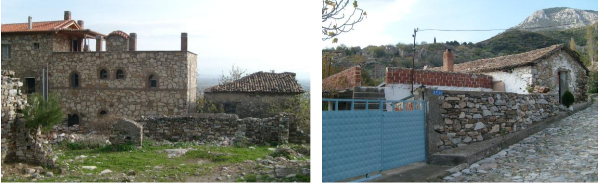
Şekil 4.23 Yeni, özgün ve onarım görmüş özgün yapılar
