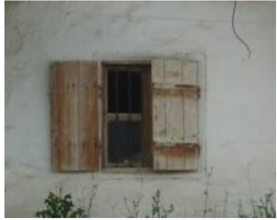
Şekil 5.25 Ahşap kepenkli, metal parmaklıklı, çift kanatlı ahşap pencereler
