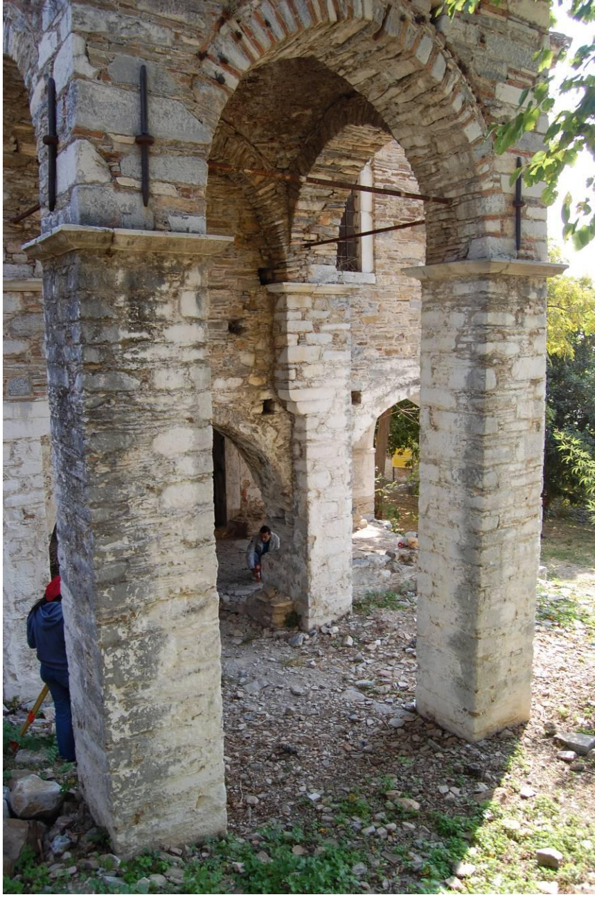
Şekil 9.52 Çan kulesini taşıyan taş payeler
