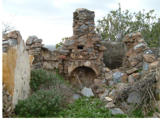
Şekil 5.42 Kısmen mevcut konutların yıkılmış ocakları ve ayaktaki konutun kapatılmış ocağı
