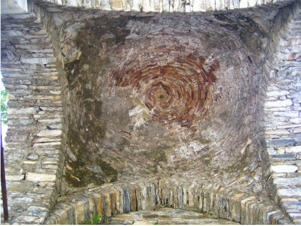
Şekil 9.53 Çan kulesinin çapraz tonoz olan tavanı
