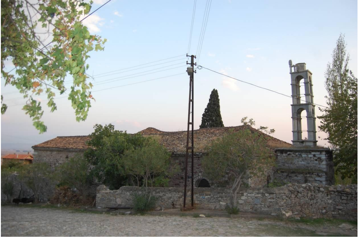
Şekil 9.27 Kuzey cephesine meydandan bakış
