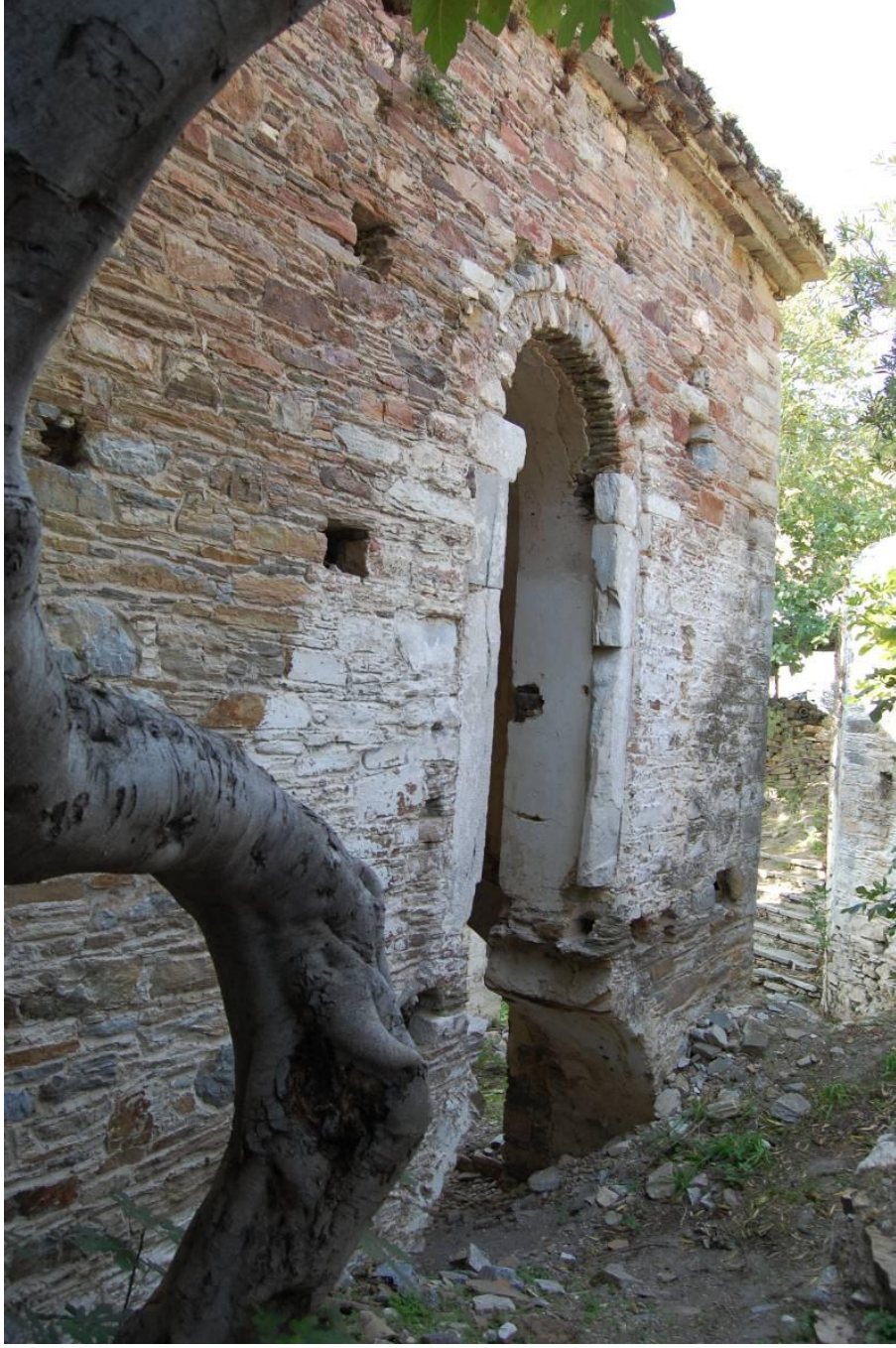
Şekil 9.29 Narteksin kuzey cephesinde bulunan giriş açıklıklarına bakış
