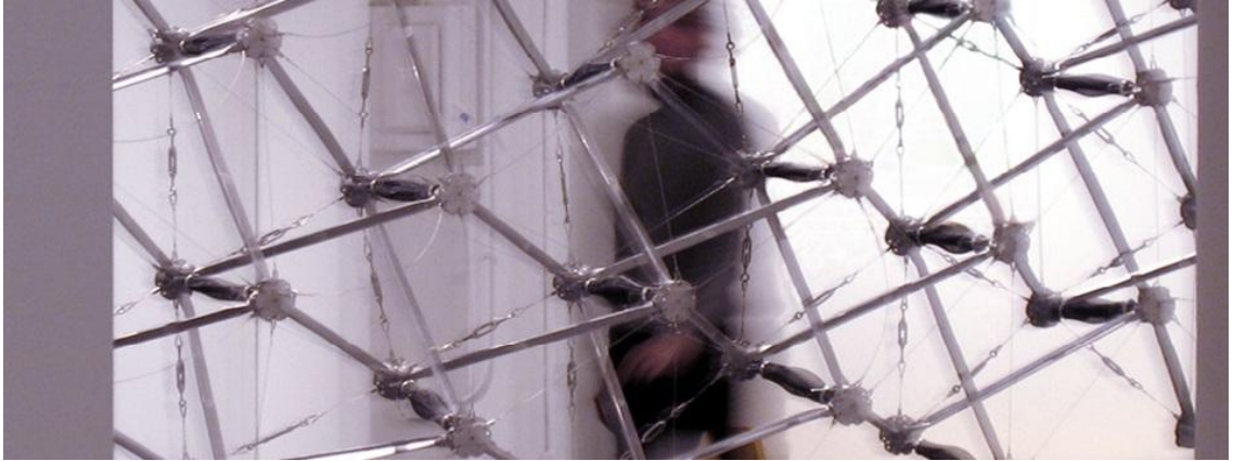
Şekil 2.10 Hareketli tensegrity strüktür. [5]
