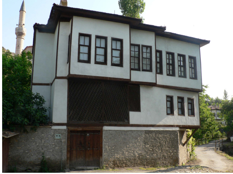
Şekil 3.5 Şehir Evi güney cephesi
