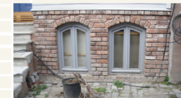
tuğla kaplama zemin kat örneği (13. parsel)
