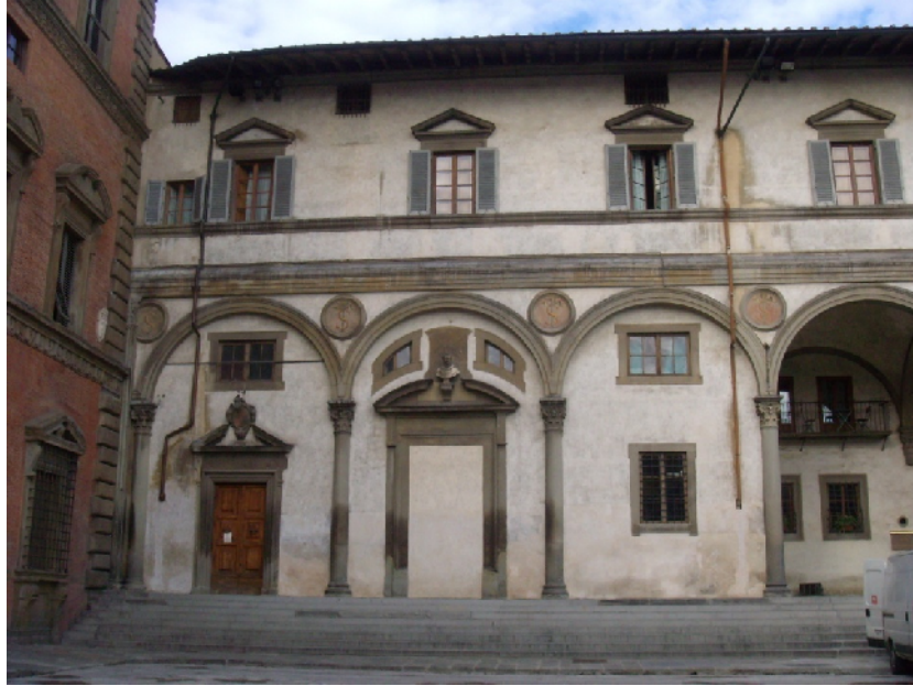
Şekil 4.12 Floransa'daki 13 numaralı yapının cephesinde bulunan gömme sütunlar
