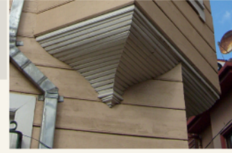
ahşap konsol konsol altı süsleme örneği (10. parsel)
