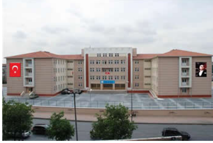
Şekil 5.88 Kağıthane Cevdet Şamikoğlu İlköğretim Okulu Genel Görünüş
