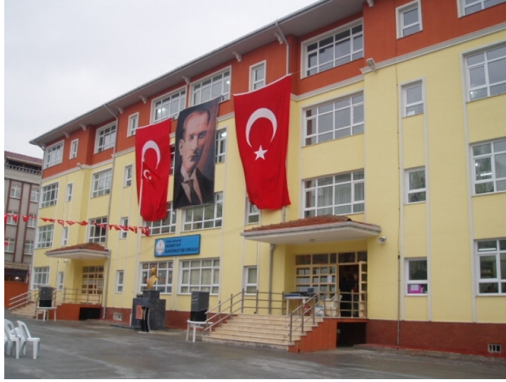
Şekil 5.141 Bayrampaşa Hürriyet İlköğretim Okulu Genel Görünüş
