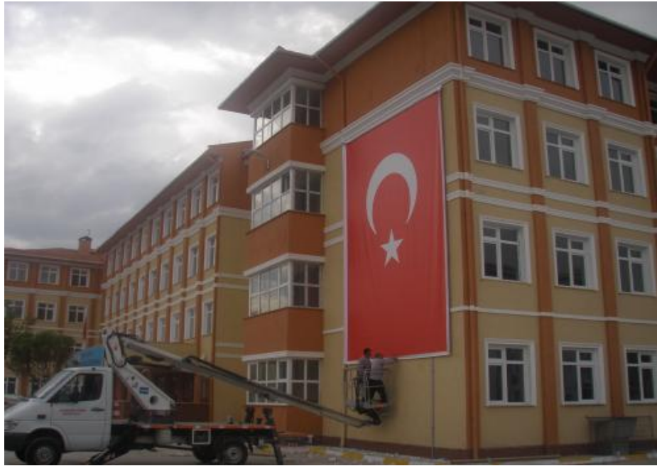
Şekil 5.77 Kartal İbn-i Sina İlköğretim Okulu Cephesi
