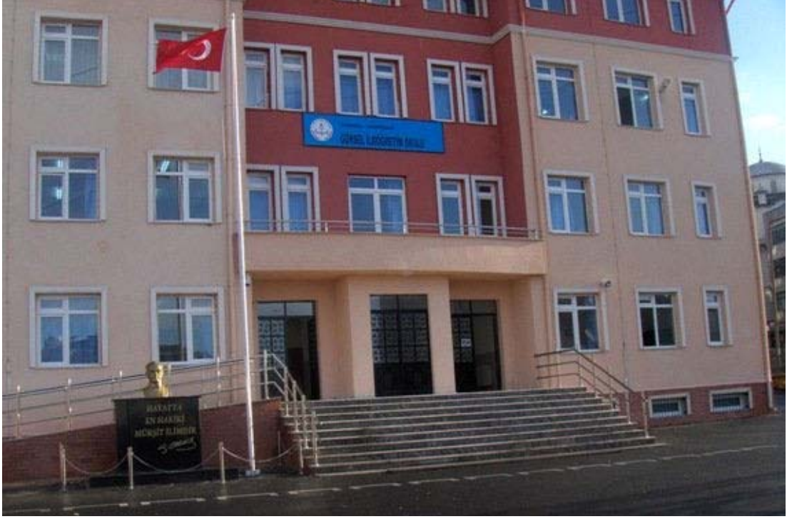
Şekil 5.67 Yeni Yapılan Kağıthane Gürsel İlköğretim Okulu Cephesi
