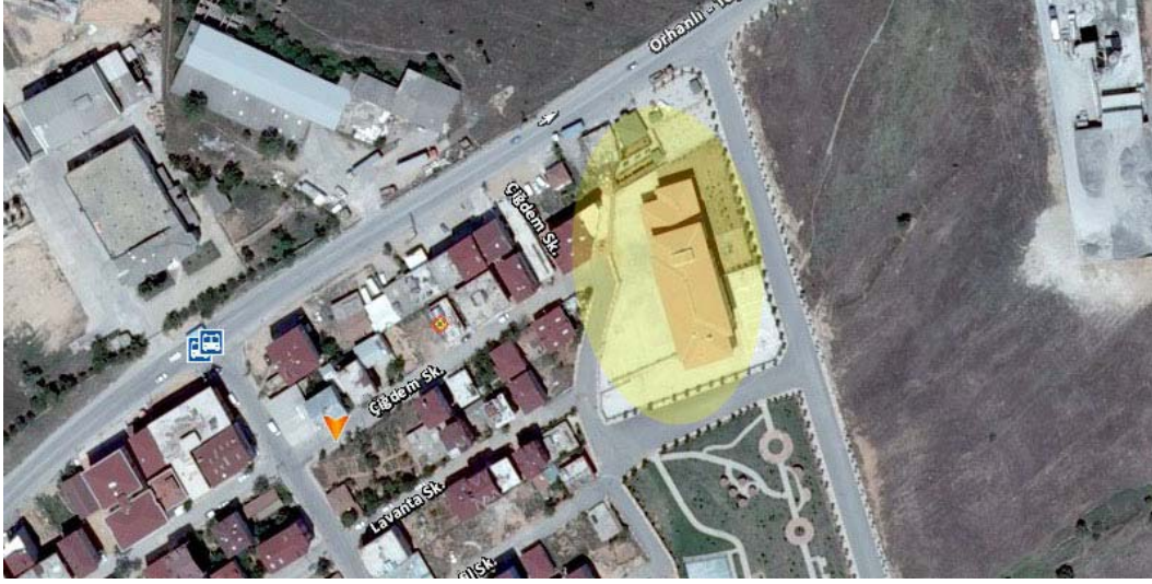
Şekil 5.110 Tuzla Orhanlı İlköğretim Okulu Hava Fotoğrafı (sehirrehberi.ibb.gov.tr)
