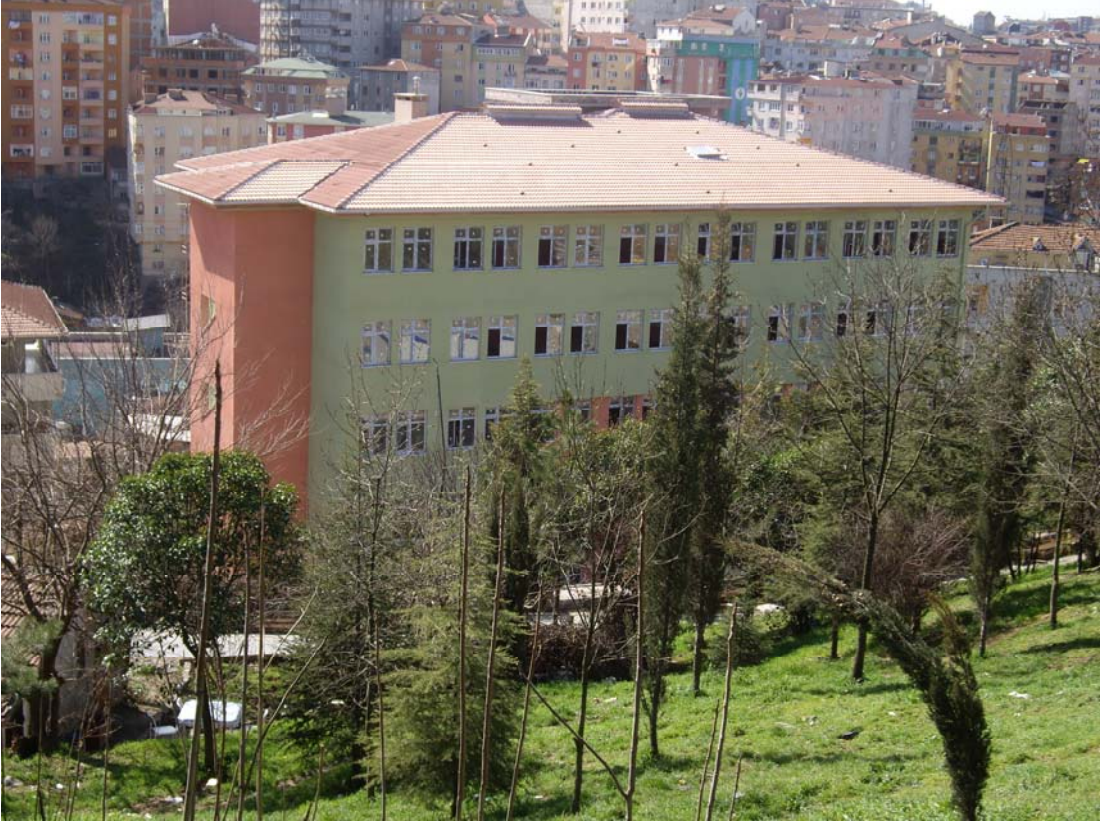
Şekil 5.135 Kağıthane Kocatepe İlköğretim Okulu Genel Görünüş
