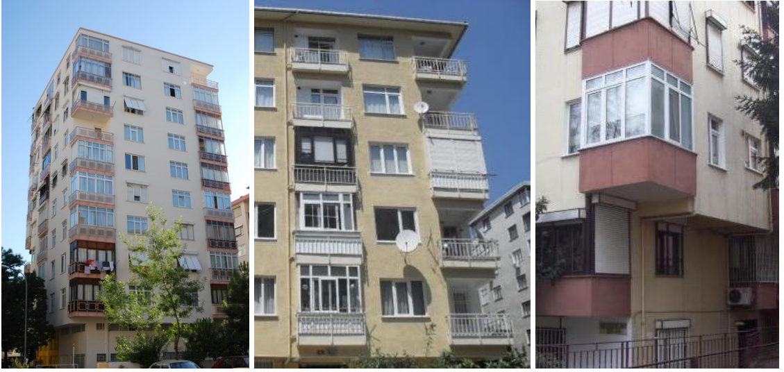
Şekil 3.1 Bilinçsizce kapatılan balkonlar [6]
