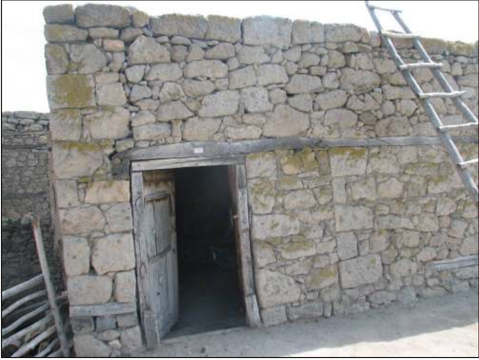
Resim 4.67. KL104 Kuzey cephesi üst kat giriş kapısı, 2008.
