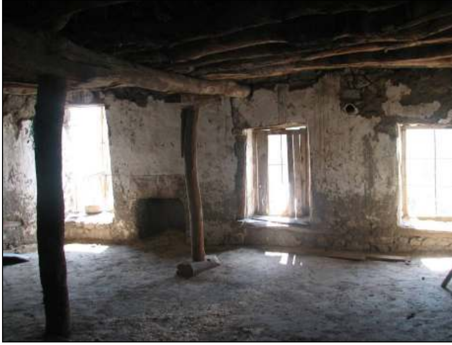
Resim 4.27. Özgün üst kat zemin döşeme malzemesi (KL104), 2008.
