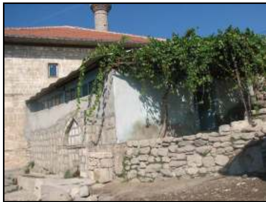
Resim 4.17. Cuma Camisi doğu cephesi, 2007.
