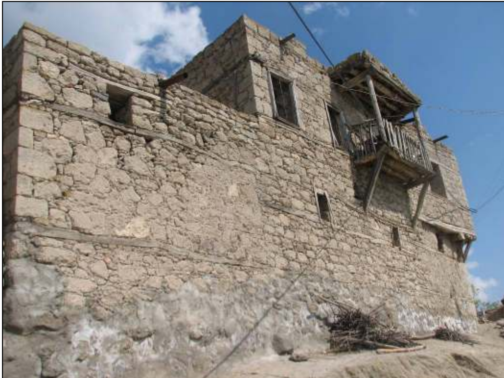
Resim 4.66. KL104 Batı cephesi, 2008.
