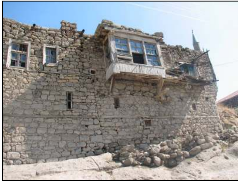
Resim 4.36. Cephe çıkma yaparak sonlanan “ tahtaboş ” mekânı, 2007.
