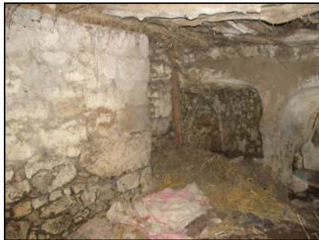
Resim 4.42. Mağaranın yapı içinde kullanılması (KL019), 2008.
