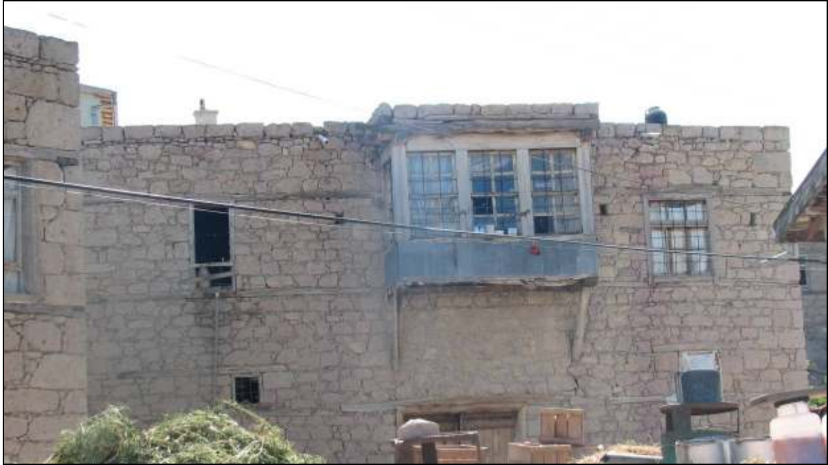
Resim 4.63. KL018 Batı cephesi, 2007.
