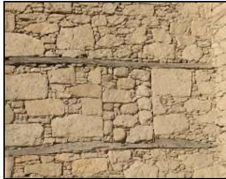
Resim 4.38. Örgü sistemi ve hatıllar, 2007.
