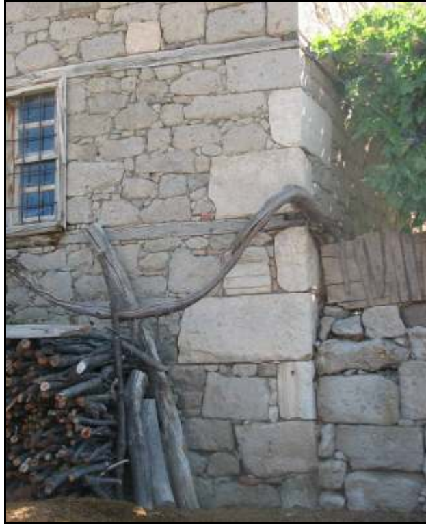
Resim 4.41. Yapının köşe taşları olarak kullanılan ve antik yapılara ait olan devşirme malzeme (KL132), 2007.
