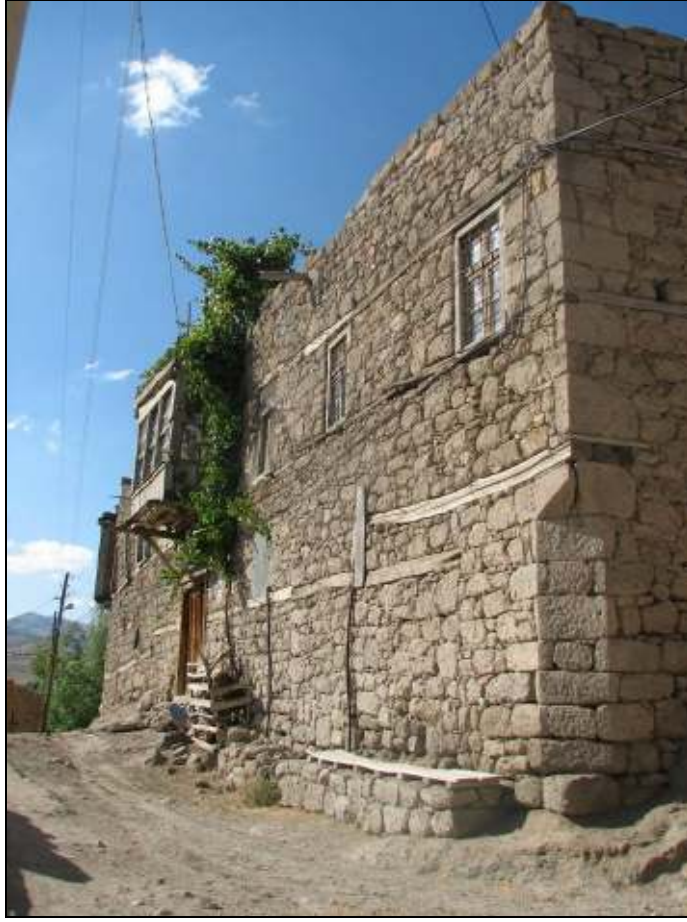
Resim 4.73. KL092 Güneybatı cephesi, 2007.
