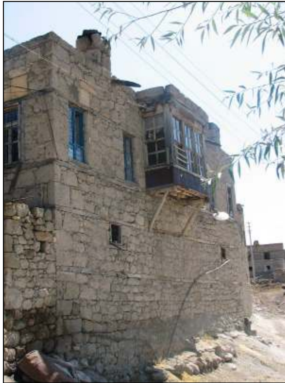
Resim 4.69. KL081 Güneybatı cephesi, 2007.
