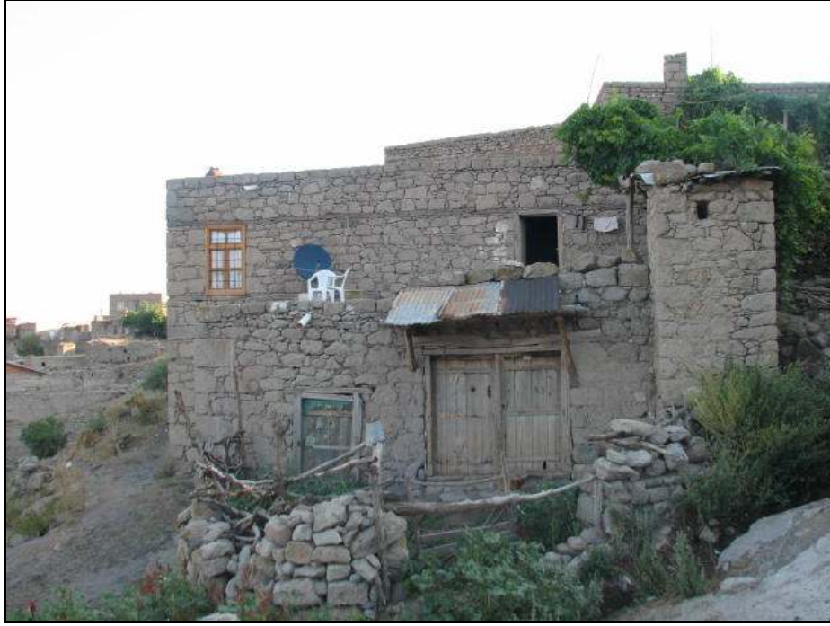
Resim 4.58. KL030 Güney cephesi giriş, 2008.
