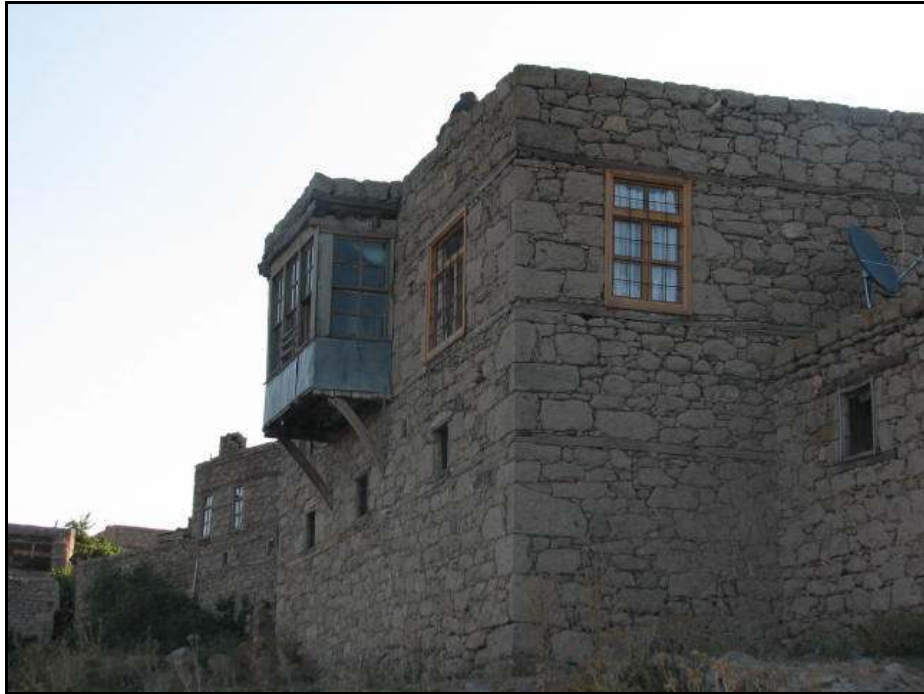
Resim 4.59. KL030 Batı cephesi, 2008.
