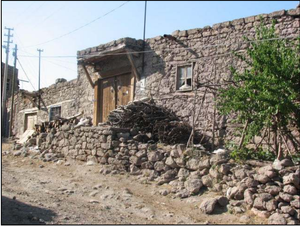
Resim 4.46. KL008 Kuzeydoğu girişi, 2007.
