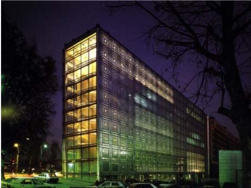
Şekil 4.27 Arap Enstitüsü, gece [74]
