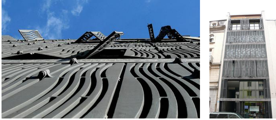
Şekil 3.5 Bir apartmanın ön cephe dokusu, Basel, İsviçre (Herzog & De Meuron) [17]
