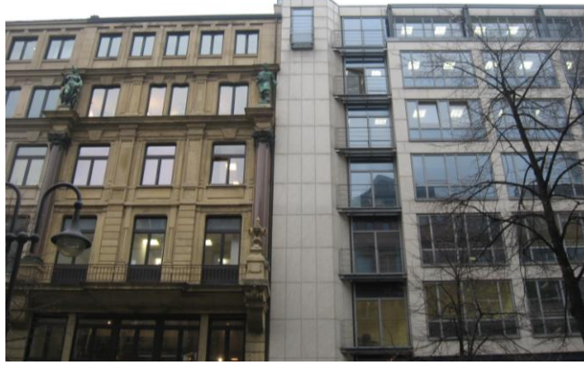
Şekil 3.6 Tarihi ve yeni binanın malzemeleri ile doku farklılığı oluşturması (fotoğraf: Hande Düzgün, 2008, Frankfurt)
