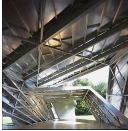
Şekil 4.70 Onsekiz Dönüş Pavyonu'nun iç mekânı ( http://www.cork2005.ie/programme/strands/architecture/eighteturns.shtml )
