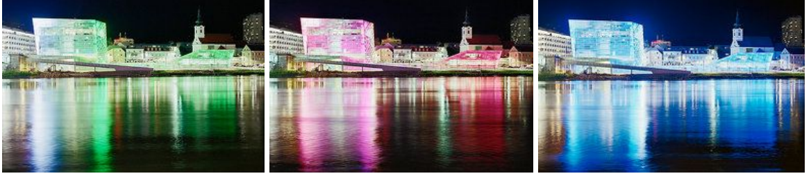
Şekil 4.104 Ars Elektronika Center farklı cephe oluşumları ( http://www.nextroom.at/building.php?id=32146 )
