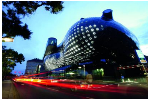
Şekil 4.47 Kunsthaus'un elektronik cephesi (Yapı Dergisi, 2004, 270: 69)
