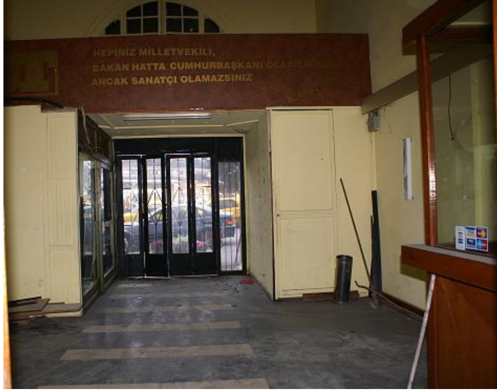
Şekil 7-15 Tiyatro giriş kapısı
