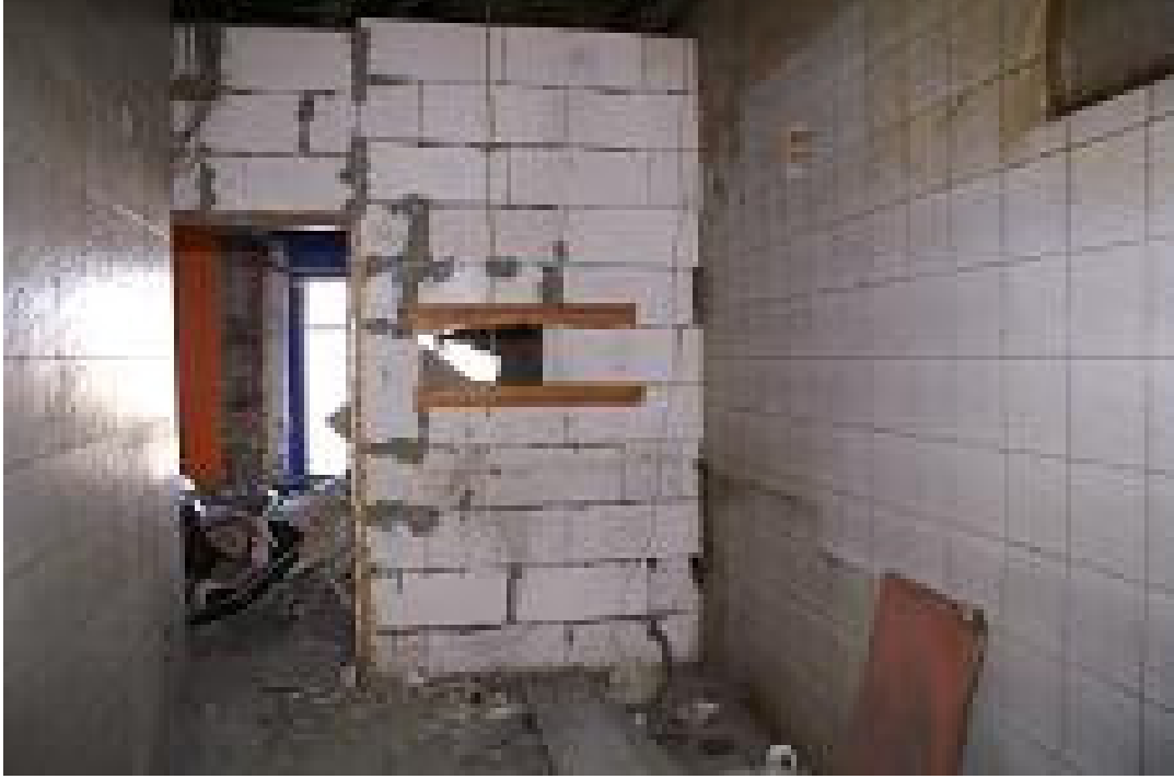
Şekil 7-47 2B19 bar servis mekanı
