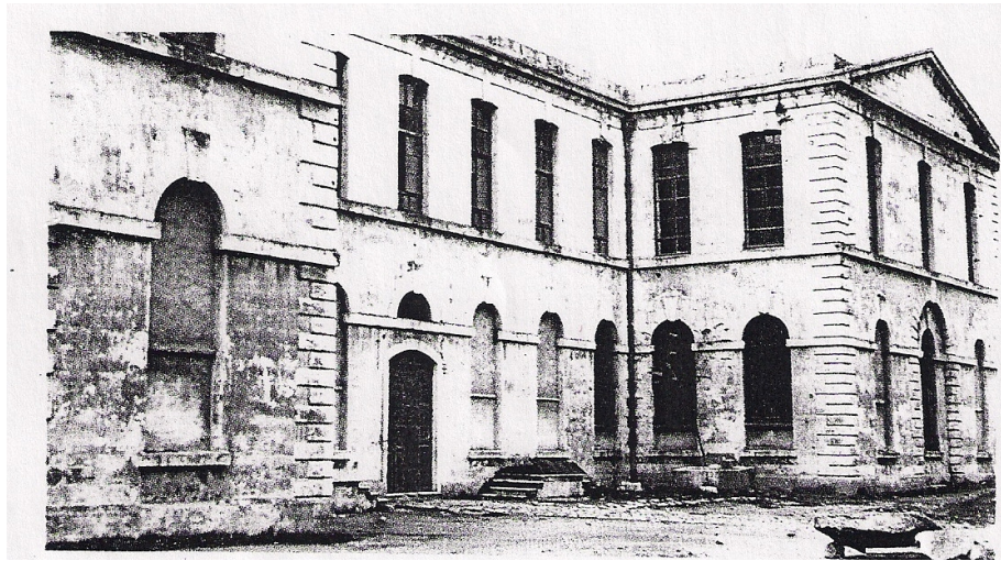
Şekil 4-22 Saray Tiyatrosu'nun yıkılmadan önceki durumu
