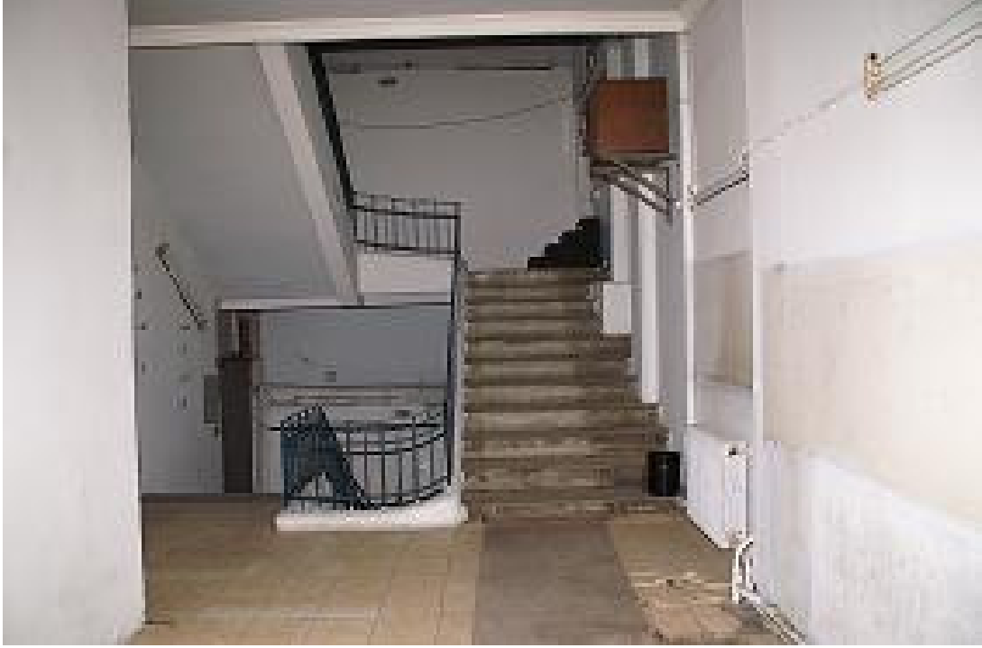
Şekil 7-33 1B02 sahne arkası servis merdivenleri
