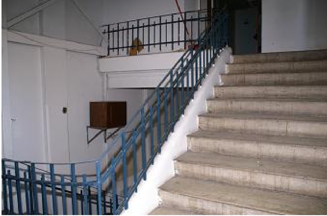
Şekil 7-41 2B03 sahne arkası servis merdivenleri
