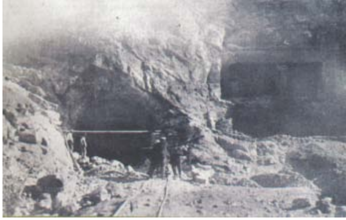
Şekil 4.19 1926’da Amasya’da devam eden Devlet Demir Yolları inşaatı (Menç, 2007)
