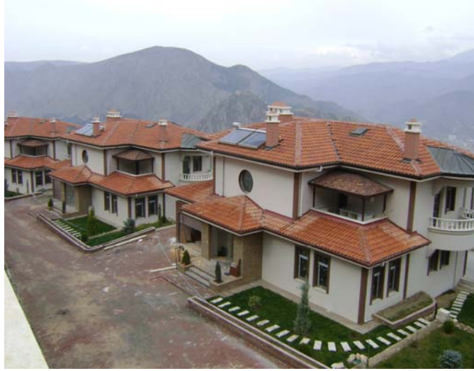
Şekil 5.28 Çakallar Mahallesi Villa Sitesi, 2010
