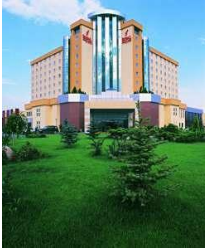
Şekil 6.14 İkbal Termal Otel. Genel Görünüm ( http://www.ikbal.com.tr )
