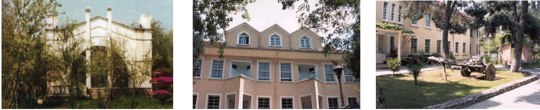
Şekil 5.1, 5.2, 5.3 Tuzla Kaplıcaları Tesisleri. Otel binası ( www.tuzlakapliclari.com )
