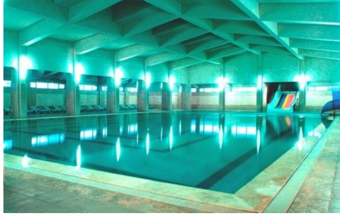
Şekil 6.20 Ömer Termal Tatil köyü. Kapalı yüzme havuzu.( http://www.omerthermal.com.tr/ )
