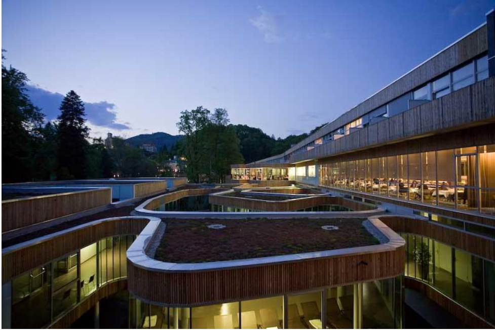
Şekil 5.37 Bath Gleichenberg. Yeşillendirilmiş teras çatı ve binanın genel görünüşü. ( http://www.archdaily.com/9803/gleichenberg-thermal-bath-jsa )
