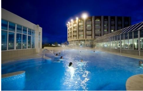
Şekil 6.10 Oruçoğlu Termal Otel. Açık yüzme havuzu. Kapalı ve açık yüzme havuzu arasında bağlantı bulunmaktadır. ( http://www.orucoglu.com.tr/ )
