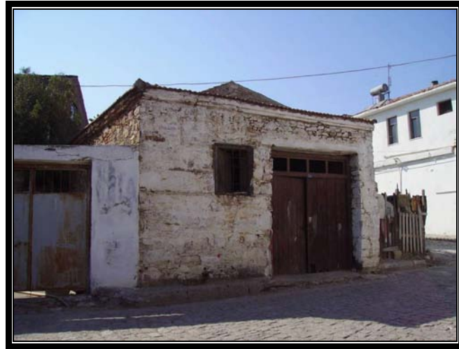
Şekil 4. 7 Metruk durumda olan bir 'mağaza' yapısı.
