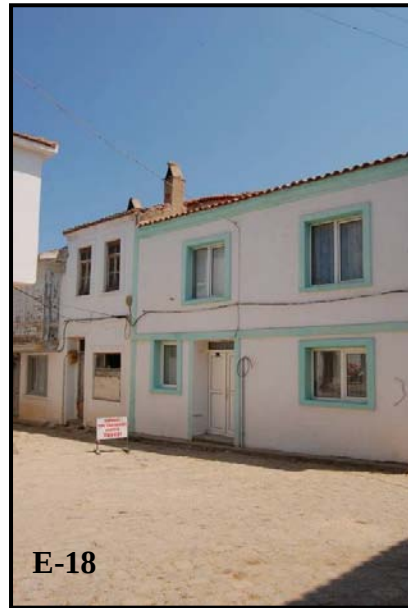
Şekil 5 20 PVC doğramalı cephe örneği (Envanter no:E-18, Ek IV, s.552)
