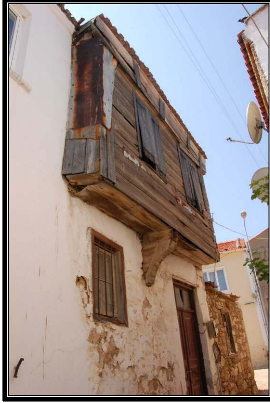
Şekil 4. 21 Alaybey Mahallesi'nden alt katı kargir üst katı ahşap olarak yapılmış konut örneği
