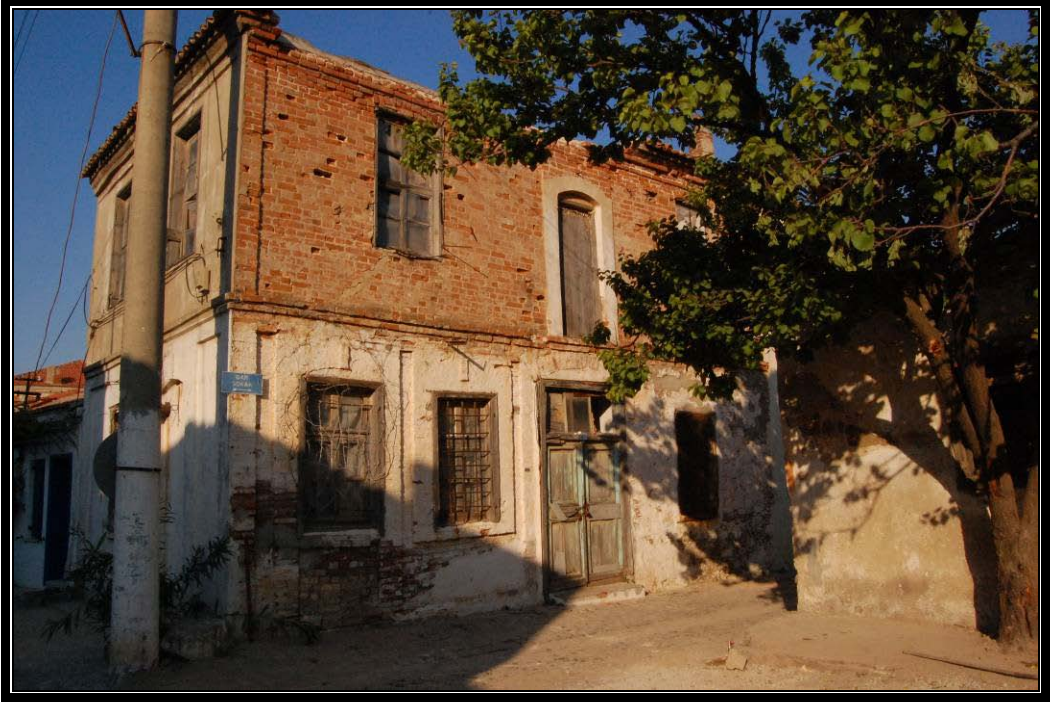
Şekil 4. 19 Alaybey Mahallesi'nden kargir konut örneği
