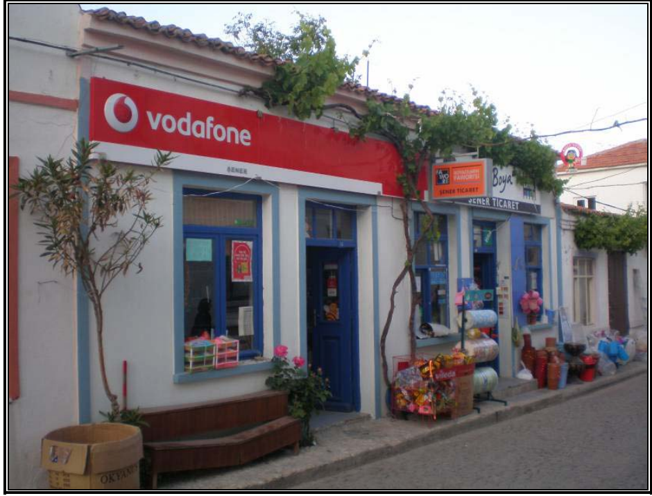
Şekil 5. 12 Ticaret fonksiyonlu yapıların cephelerinde yapılan müdahaleler. (Envanter no:B-D-3, Ek IV, s.338)
