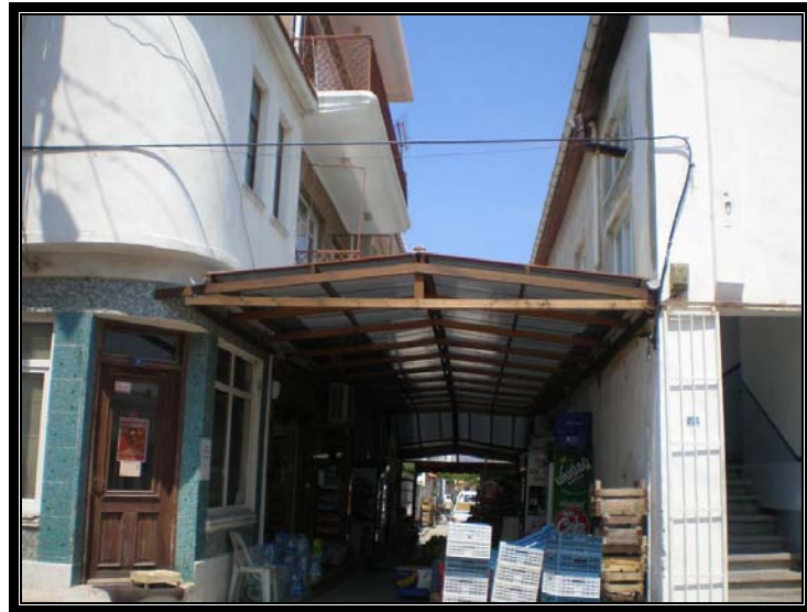
Şekil 4. 9 Cumhuriyet Mahallesi'ndeki ticari yapılardan görünüm.
