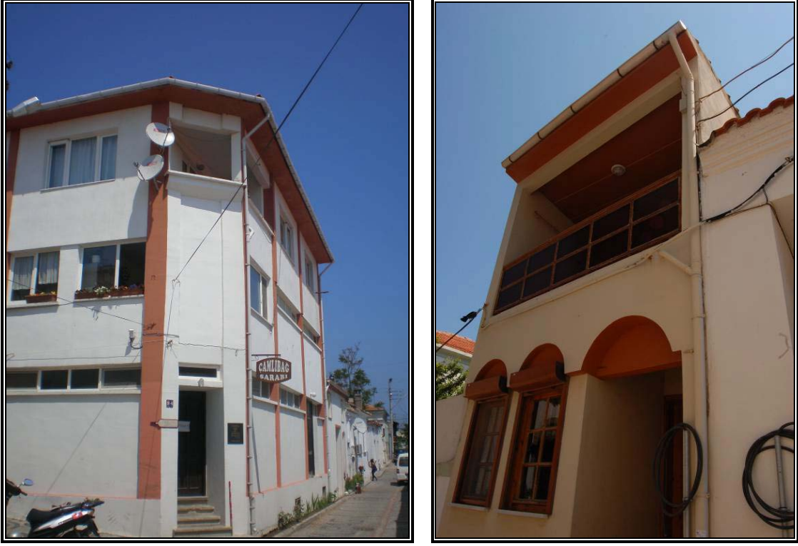
Şekil 5. 34 Dokuya aykırı yeni yapılar
