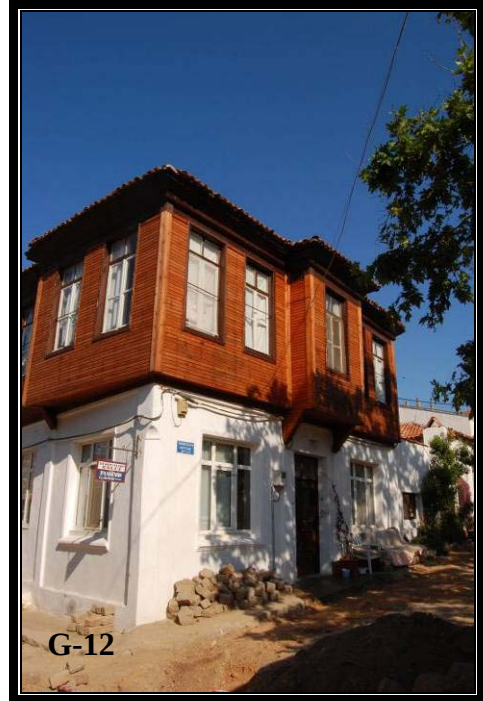
Şekil 4. 67 Çıkmanın giriş ile aynı aksta yer aldığı cephe örneği (Envanter no:B-I-1, Ek IV, s.368)
