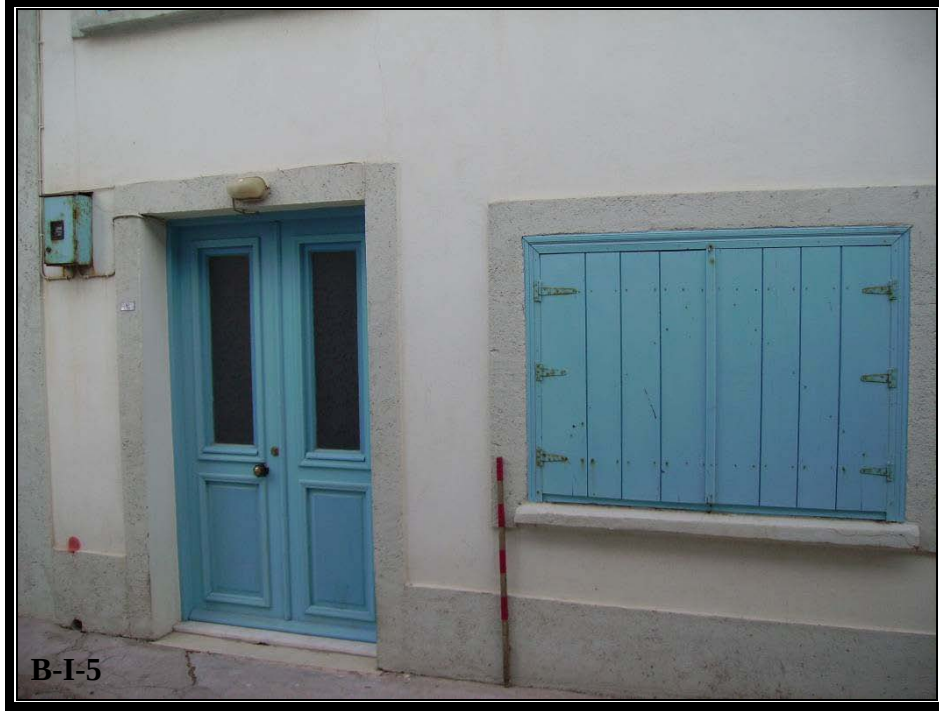
Şekil 4. 95 Düz atkılı ahşap kapı ve ahşap kepenk örneği (Envanter no:B-I-5, Ek IV, s.372)
