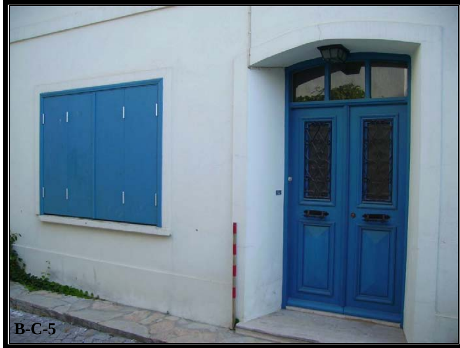
Şekil 4. 96 Kemerli ahşap kapı ve ahşap kepenk örneği (Envanter no:B-C-5, Ek IV, s.335)
