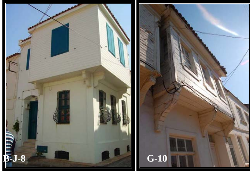
Şekil 4. 98 Ahşap kapalı çıkma örneği (Envanter no:B-J-8, Ek IV, s.382)
