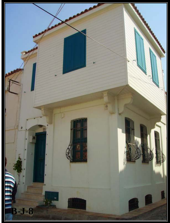
Şekil 4. 70 Çıkmanın girişe göre yanda olduğu cephe tipi (Envanter no:B-I-7, Ek IV, s.374)
