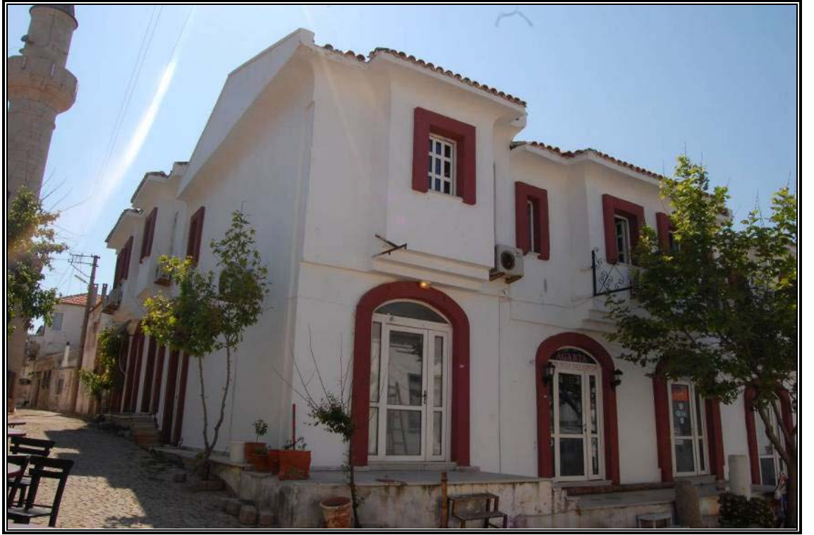
Şekil 5. 31 Geleneksel dokuya aykırı yeni yapı
