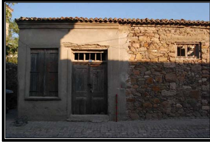
Şekil 4. 6 Metruk durumda olan bir 'mağaza' yapısı*.
