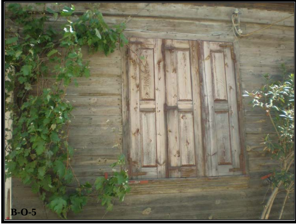
Şekil 4. 84 Ahşap kepenk örneği (Envanter no:B-O-5, Ek IV, s.429)
