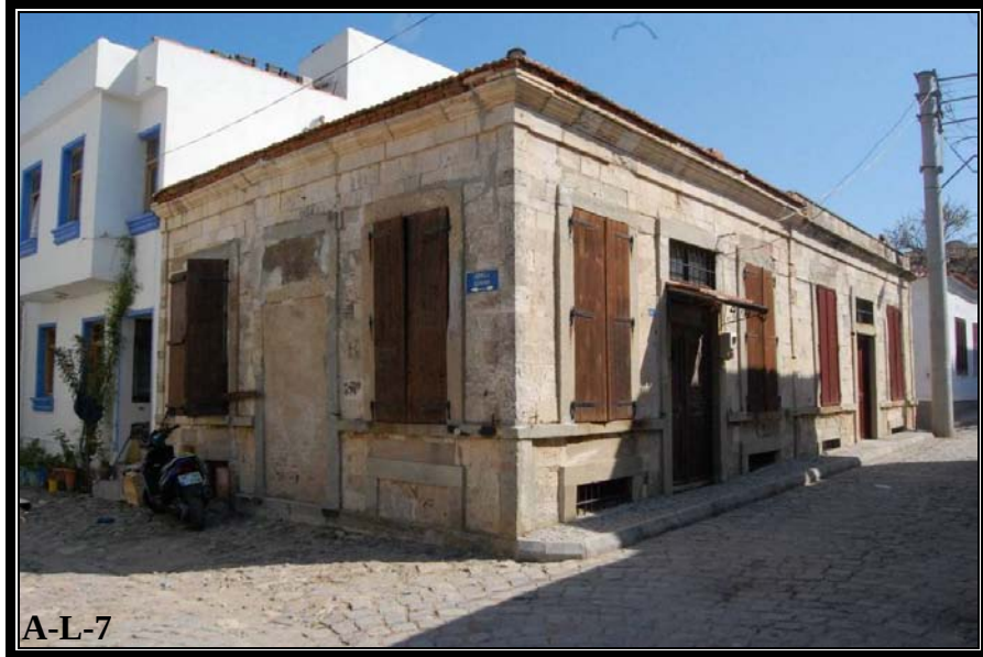
Şekil 4. 85 Ahşap kepenk örneği (Envanter no:A-L-7, Ek IV, s.271)
