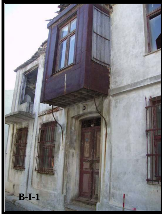
Şekil 4. 67 Çıkmanın giriş ile aynı aksta yer aldığı cephe örneği (Envanter no:B-I-1, Ek IV, s.368)
