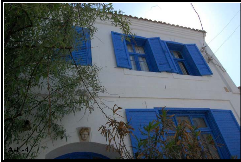
Şekil 4. 80 Ahşap kanatlı pencere örneği (Envanter no:A-L-4, Ek II, s.268)
