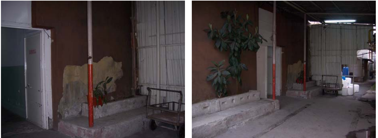
Resim 4.141 Doğu cephesi yemekhane depo girişi
