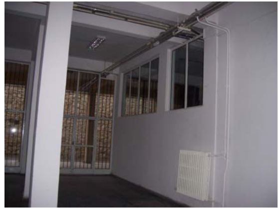
Resim 4.76 Bodrum güney ek yapı
