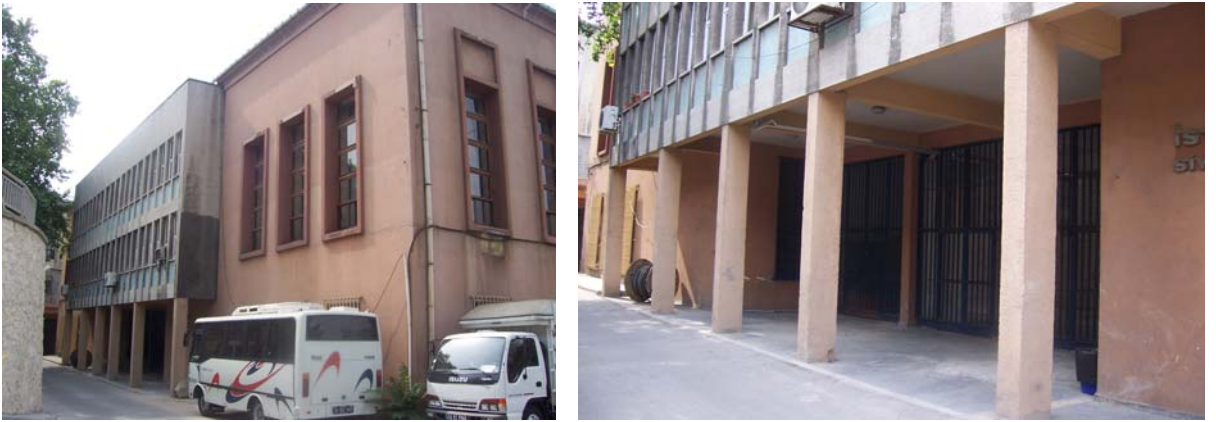
Resim 4.137 Güney cephesi ek yapı kolonlu çıkma
