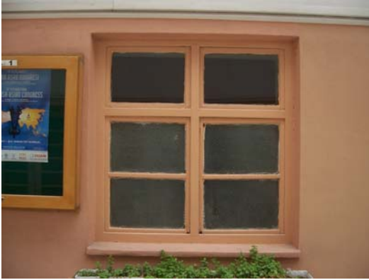
Resim 4.150 Zemin kat ahşap pencere
