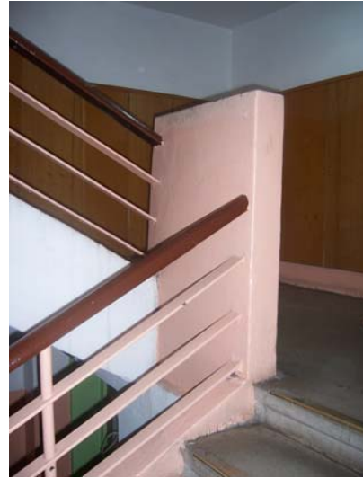
Resim 4.61 Sağ yan merdiven holü küpeştesi
