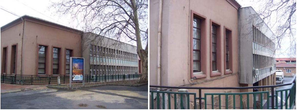
Resim 4.136 Güney cephesi ek yapı
