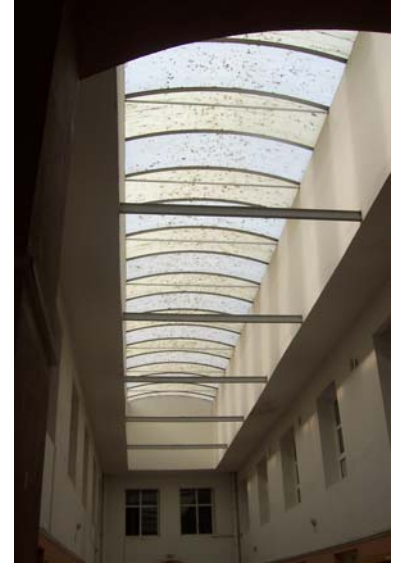
Resim 4.41 Cam çatı örtüsü
