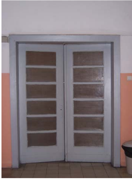
Resim 4.160 Ahşap doğramalı camlı kapı
