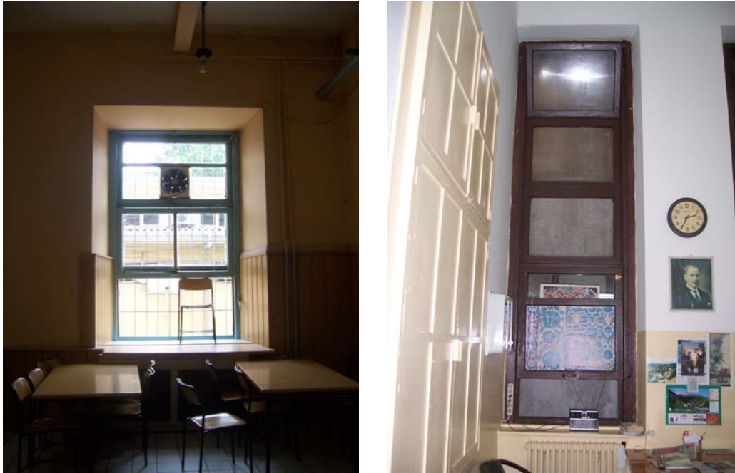
Resim 4.148 Zemin kat / vasistas ahşap pencere
