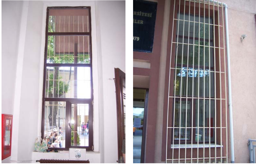
Resim 4.144 Zemin kat giriş holü pvc pencere
