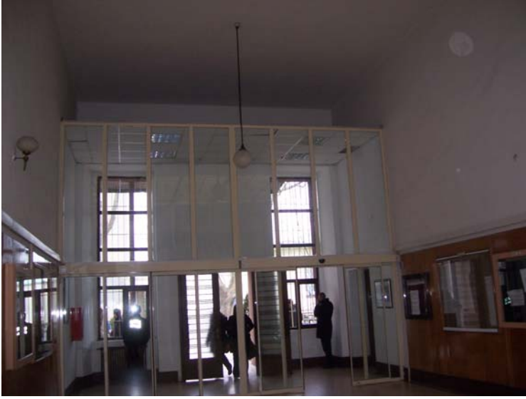
Resim 4.23 Zemin kat giriş holü rüzgarlık
