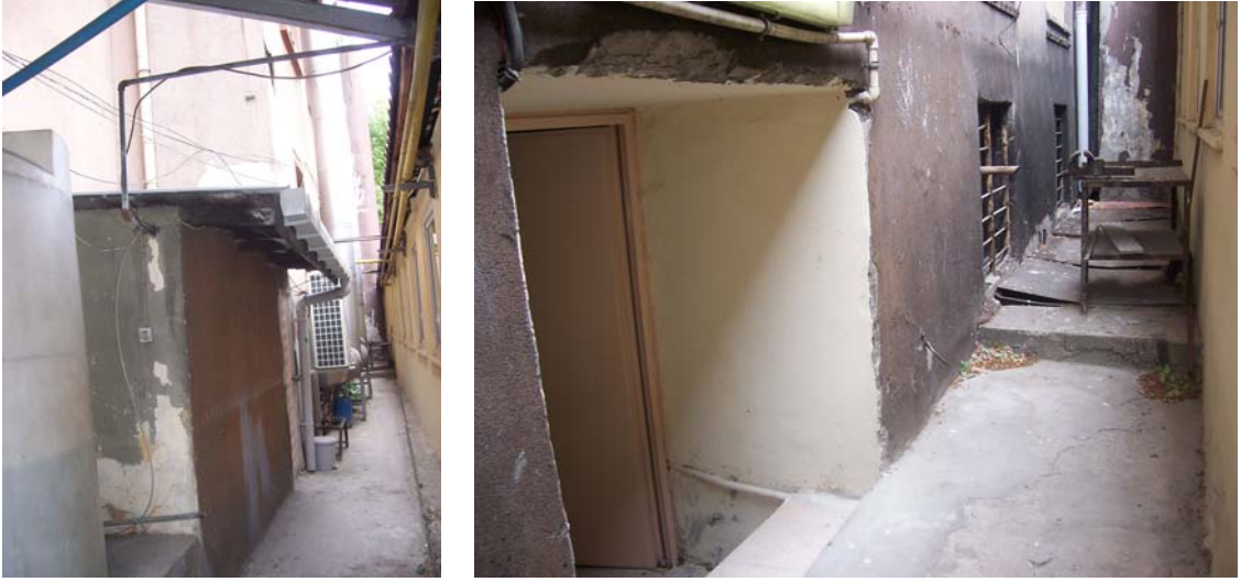
Resim 4.142 Doğu cephesi tesisat odası girişi
