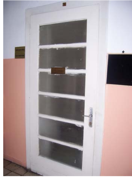
Resim 4.160 Ahşap doğramalı camlı kapı
