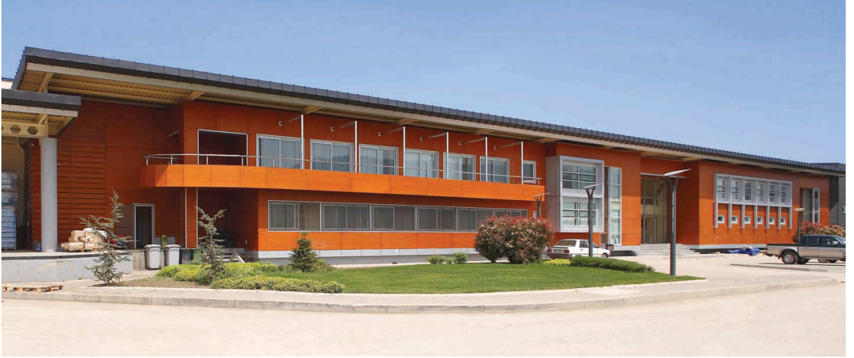
Şekil 8 Gıdasa Hendek İçecek Tesisleri, Sakarya Mimar: Hakan Adaş
