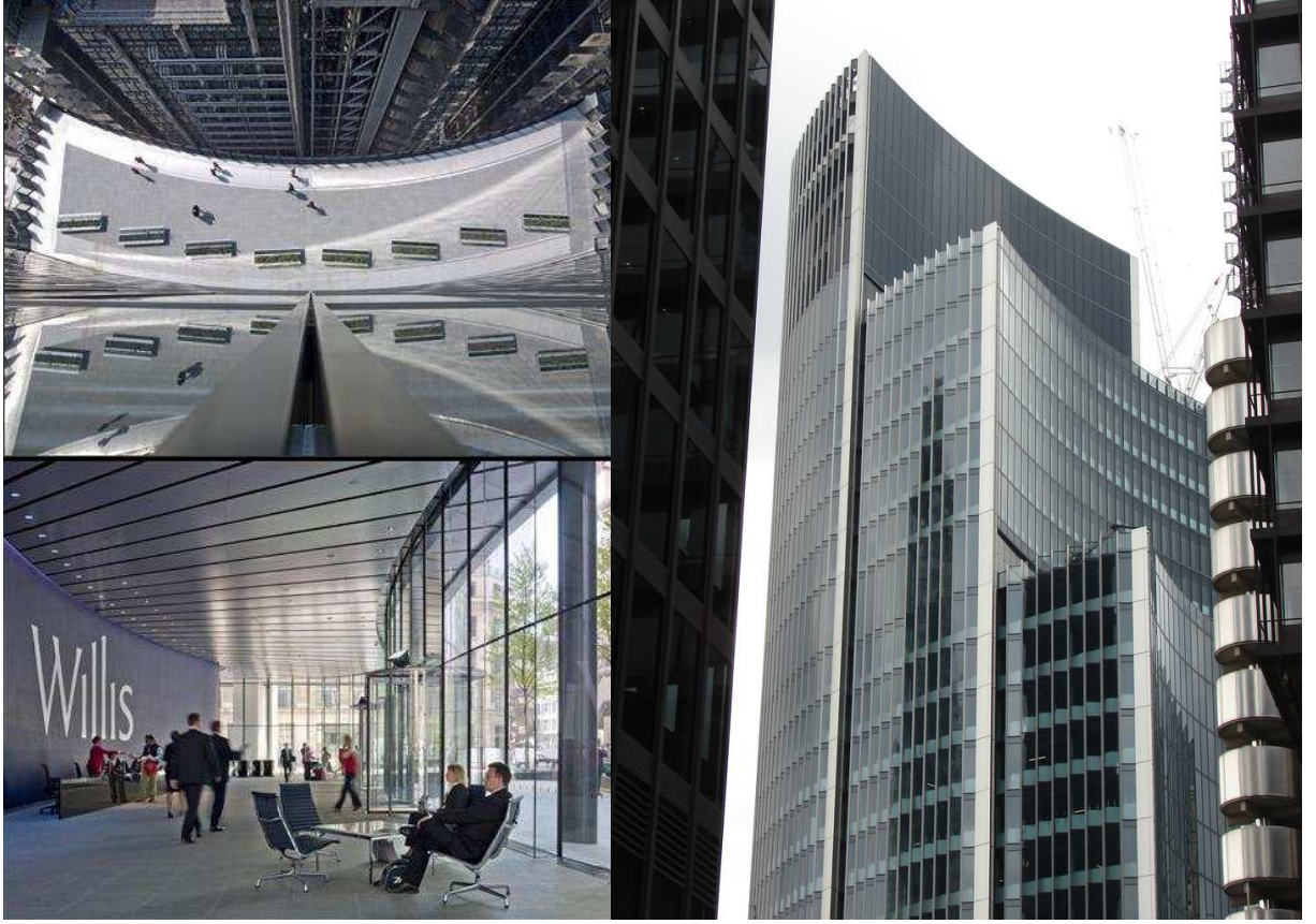
Şekil 4.11 Willis Group Holding'in Londra Genel Merkezinden Görünüşler.
