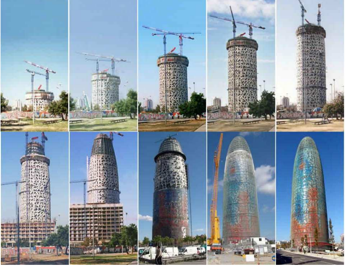
Şekil 4.25 Torre Agbar İnşaat Süreci.
