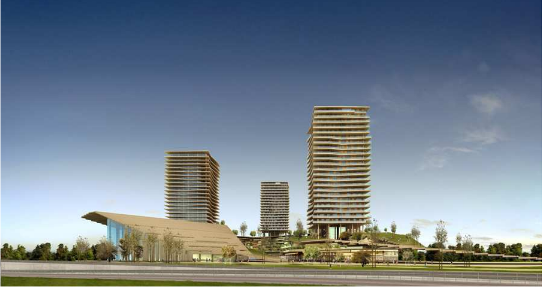
Şekil 4.38 Zorlu Center Projesi Genel Görünüşü.
