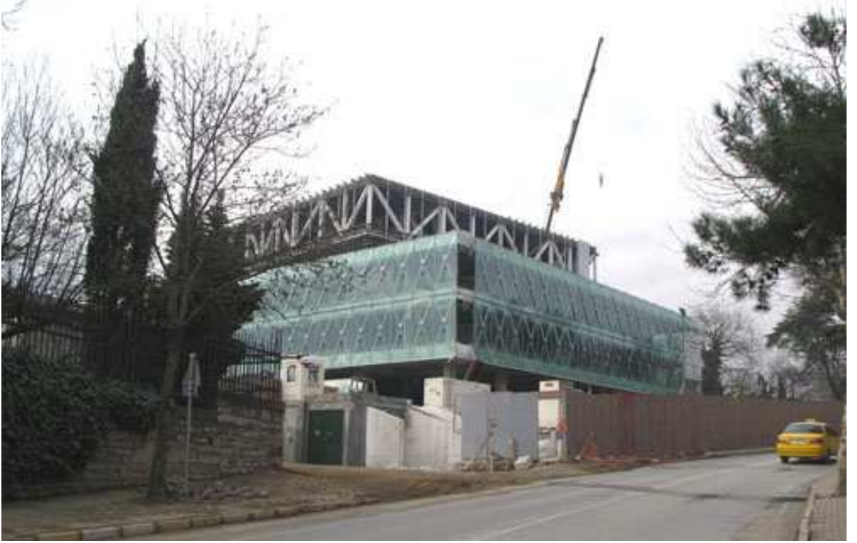
Şekil 4.7 Vakko Genel Merkezi ve Power Medya Merkezi'nin Caddeden Görünüşü.
