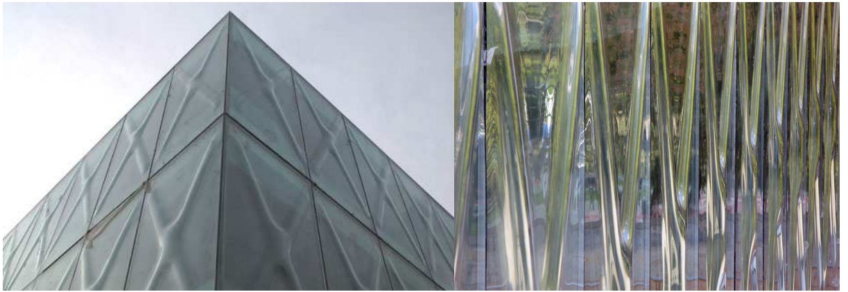
Şekil 4.9 Cam Cephe Uygulaması.
