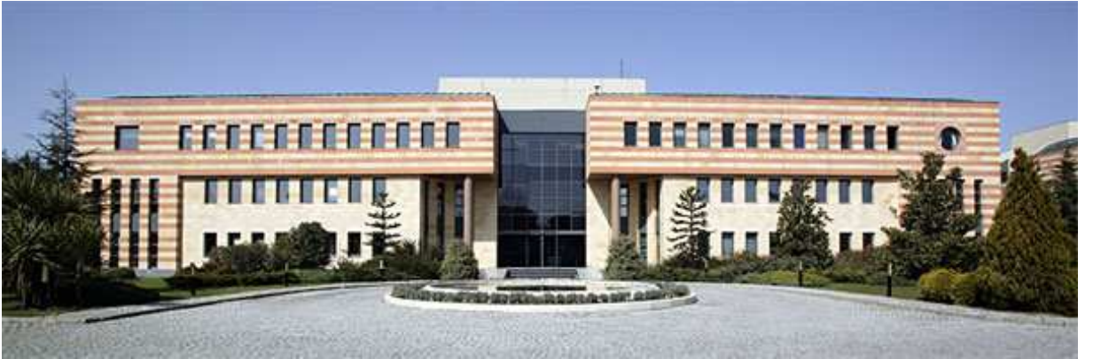
Şekil 4.44 Shell Company Genel Merkezi Ön Görünüşü.
