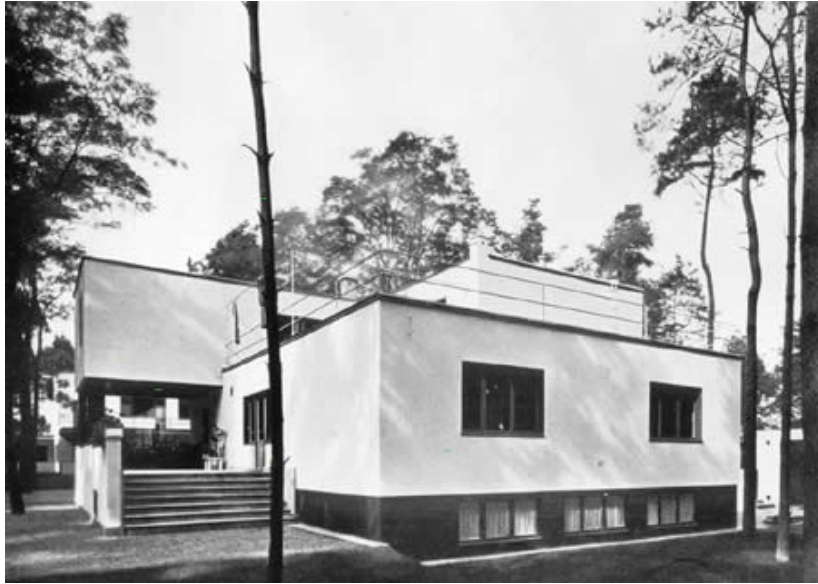
Şekil 2.68 Gropius Evi Güney-Doğu Cephesi
