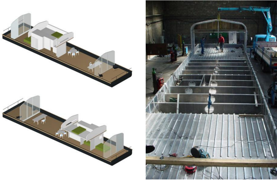
Şekil 3.83 Yüzen ev iç görüntüsü ve yapım aşaması [58]
