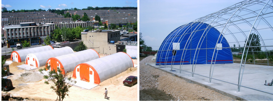
Şekil 3.17 Şantiye çadırı genel görünüm [30]
