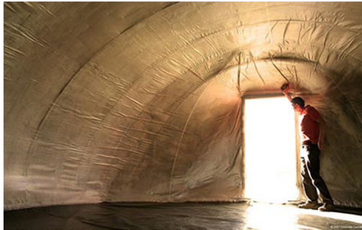
Şekil 2.35 Beton çerçevesiz barınak iç görünüş [3]
