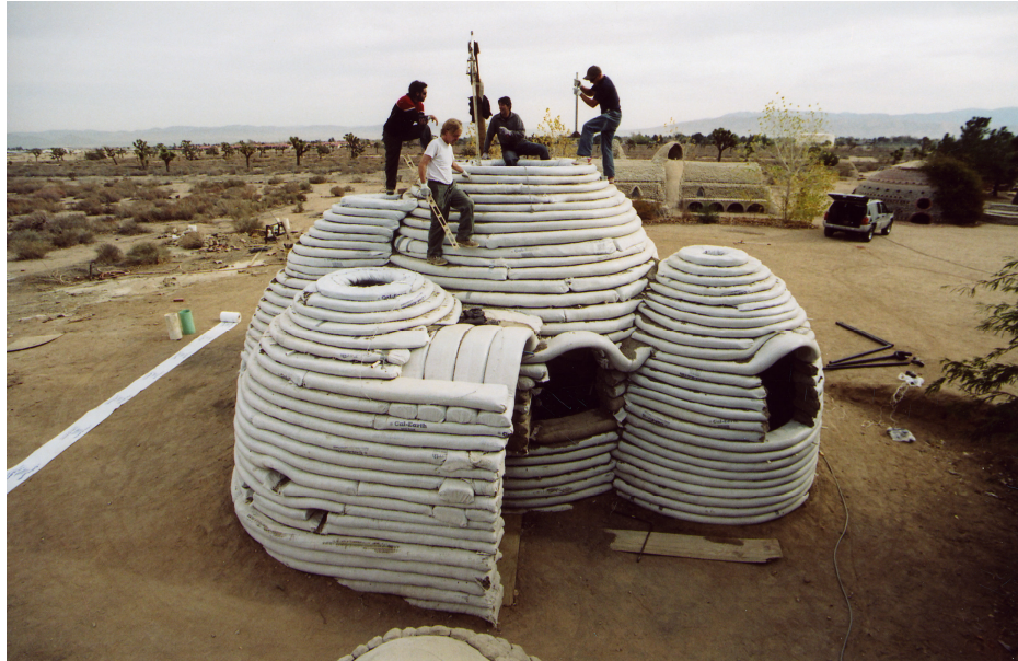
Şekil 2.43 Kum torbası barınağı yapım aşaması [3]
