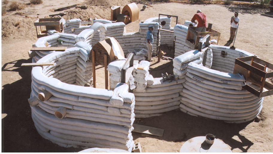
Şekil 2.42 Kum torbası barınağı yapım aşaması [3]
