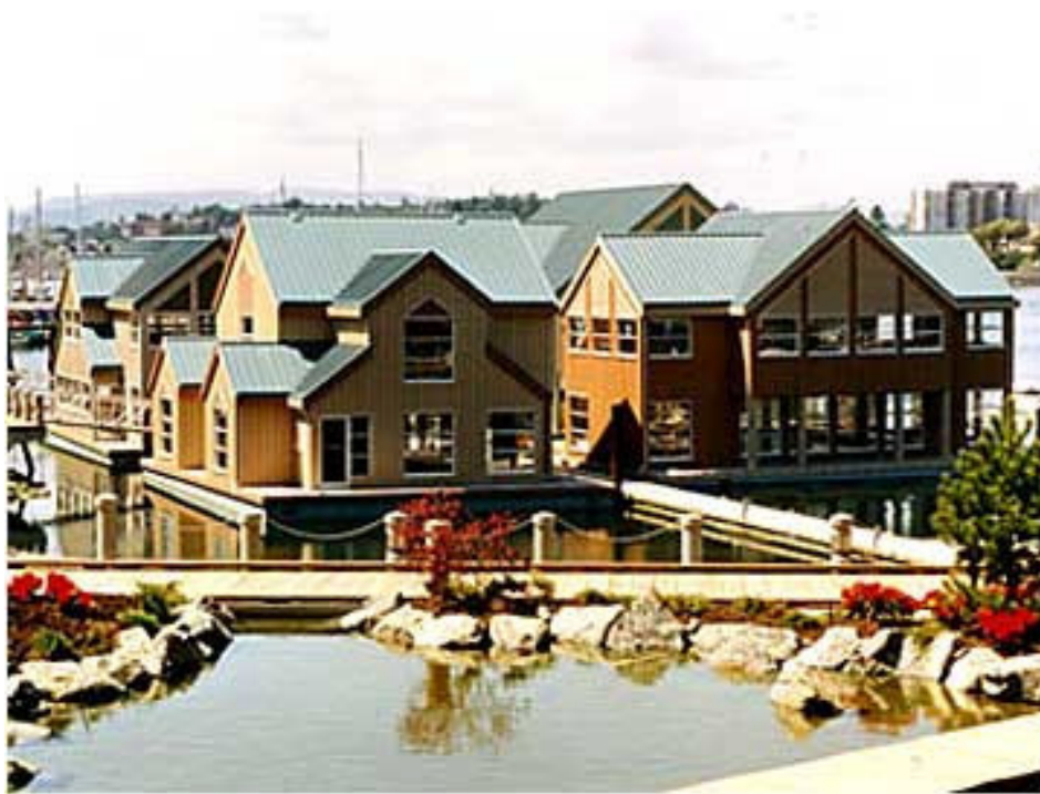
Şekil 3.74 Kanada’da dört ve iki katlı ticari binalardan oluşan bir grup. İlk önce Victoria Harbour’daki Coast Otel’e bitişik yerleştirildi, daha sonra Campbell nehrine taşındı. İçerisinde ticari ofisler, restoranlar, tekne kiralama vb. imkânlara sahip. [54]
