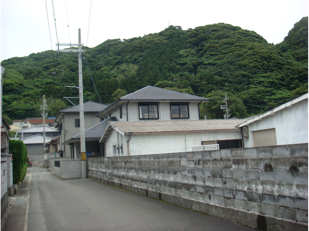
Şekil 3.17 Bölgenin elektrik sistemi yer altında olması gerekirken yüzeyde
