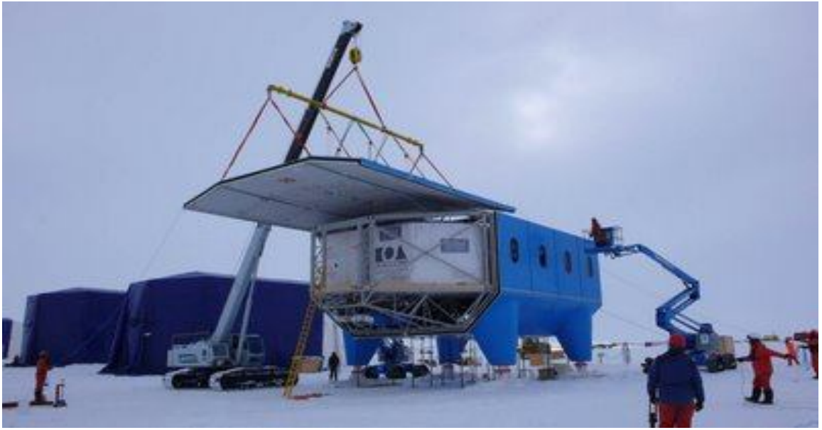
Şekil 3.4 Halley VI inşaatı [8]
