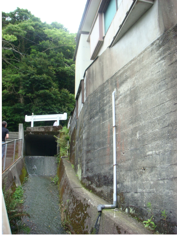
Şekil 3.20 Denize dökülen kanala karışan ve evlerden direkt çıkan kirli su boruları
