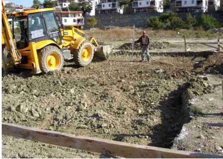
Şekil 3.10 Temel zemini düzeltme işlemi (.www.ioanialtd.com)
