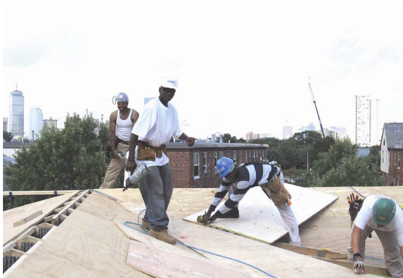
Şekil 3.198 OSB levhanın çerçeve üzerine sabitlenmesi ( www.ybboston.org )
