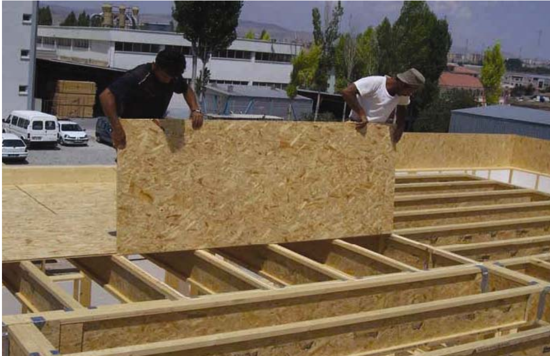
Şekil 3.80 Döşeme levhalarının uygulanması (www.nascor-tr.com)
