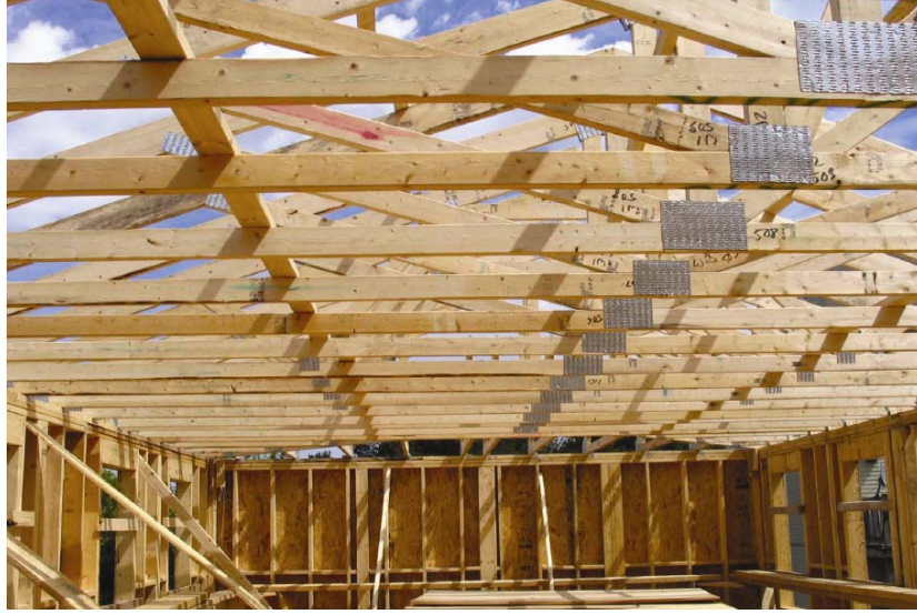
Şekil 3.197 Makaslar ile oluşturulan çatı sistemi ( www.ybboston.org )
