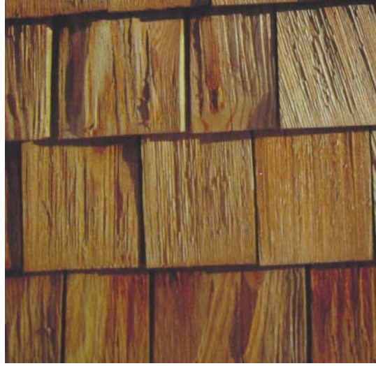
Şekil 3.166 Shingle kaplama uygulaması (Slavid, 2005)
