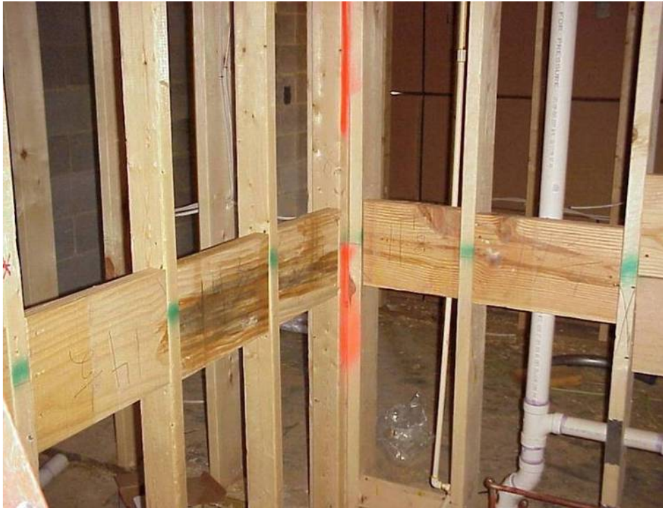
Şekil 4.7 Duvarda küçük boşluklar oluşturan çerçeveler (www.ybboston.org)
