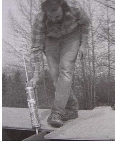
Şekil 3.82 Levhaları yapıştırma işlemi (Allen, 1999)
