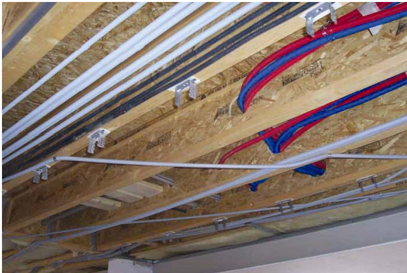
Şekil 3.53 I kiriş içerisinden geçirilen elektrik tesisatı (www.nascor-tr.com)
