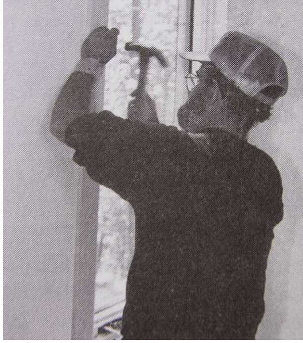
Şekil 3.147 Pervazın çivilenmesi (Allen, 1999)
