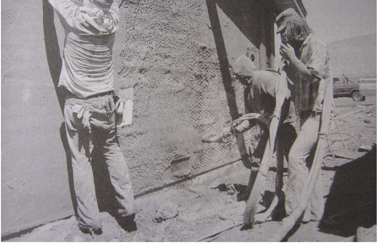
Şekil 3.172 Rabbitz teli üzerine sıva püskürtülme işlemi (Allen, 1999)
