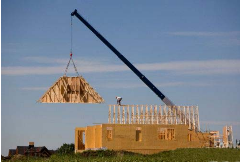
Şekil 3.110 Duvar ve çatı çerçevesinin vinç yardımıyla kaldırılması (www.gettyimages.com)
