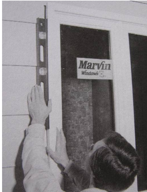
Şekil 3.140 Kasasının terazisi üste yakın yerden kontrol edilmesi (Allen, 1999)
