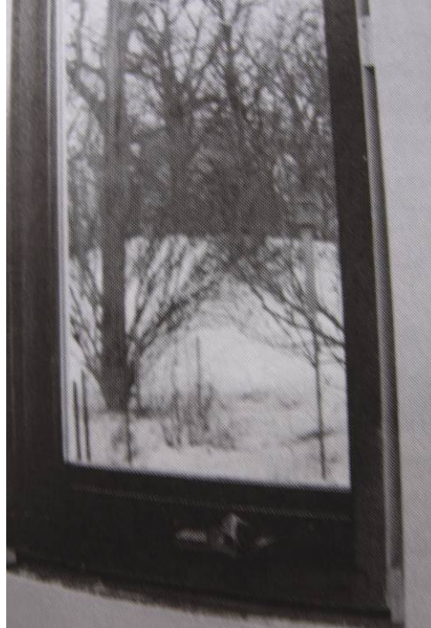
Şekil 3.142 Kasanın dik kalması için takozlarla desteklenmesi (Allen, 1999)
