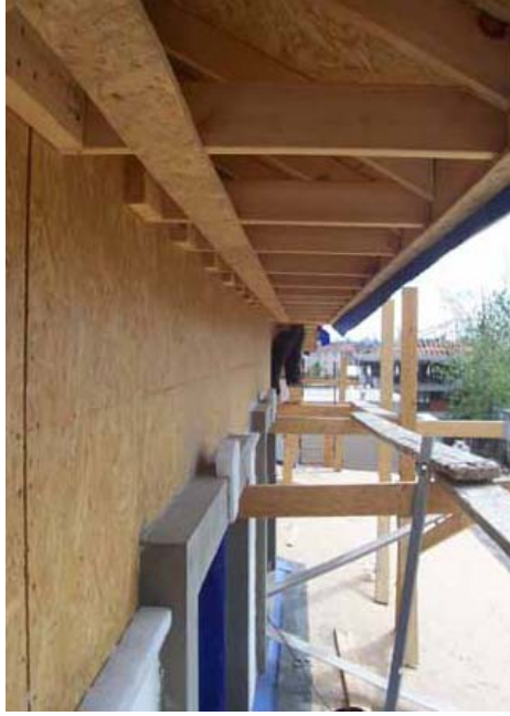
Şekil 3.209 Uygulanmış saçak örneği (www.nascor-tr.com)
