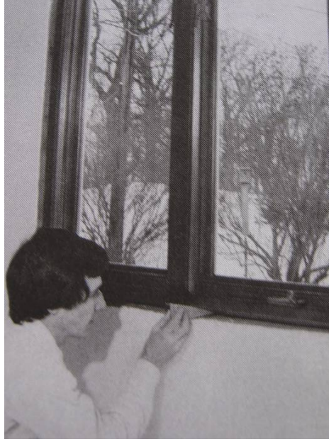
Şekil 3.141 Pencere denizliğinin desteklemesi için takozların kullanılması (Allen, 1999)
