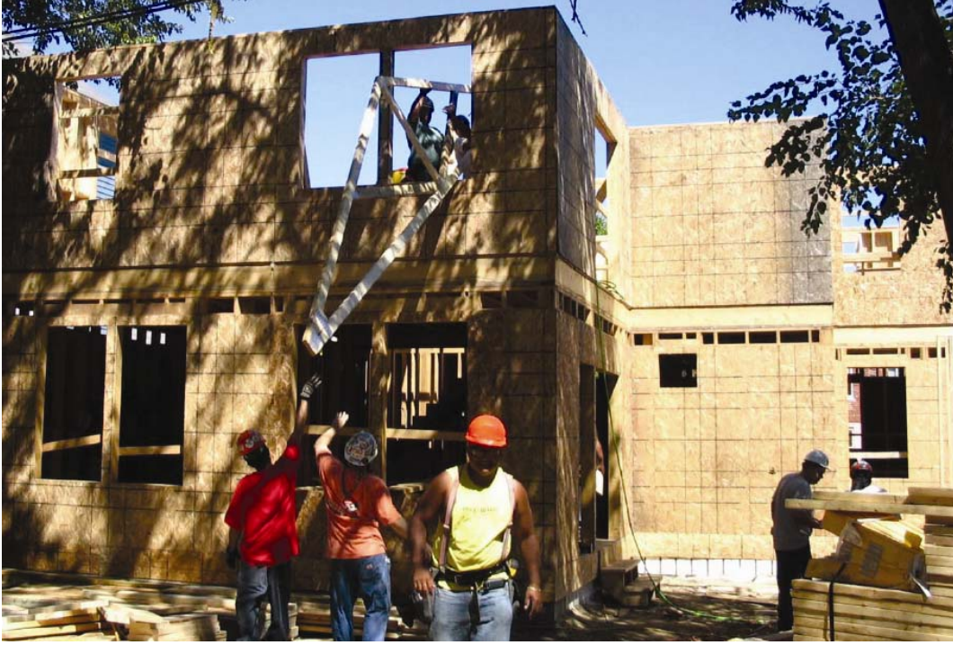
Şekil 3.193 Çatıya insan gücü ile çıkartılan çatı makas (www.ybboston.org) Hazır makaslara ait uygulama süreci Şekil 3.194’de verilmektedir.
