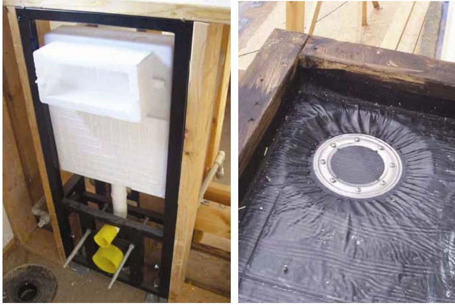
Şekil 4.3 Sihhi tesisat uygulaması (www.nascor-tr.com)
