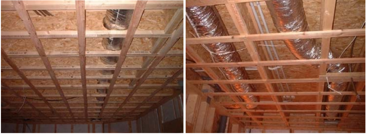
Şekil 3.67 Döşeme kirişlerinden geçirilen servis elemanları (Batur, 2004)
