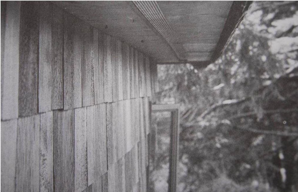
Şekil 5.18 Böcek girişini engelleyen metal profilin kullanılması (Allen, 1999)
