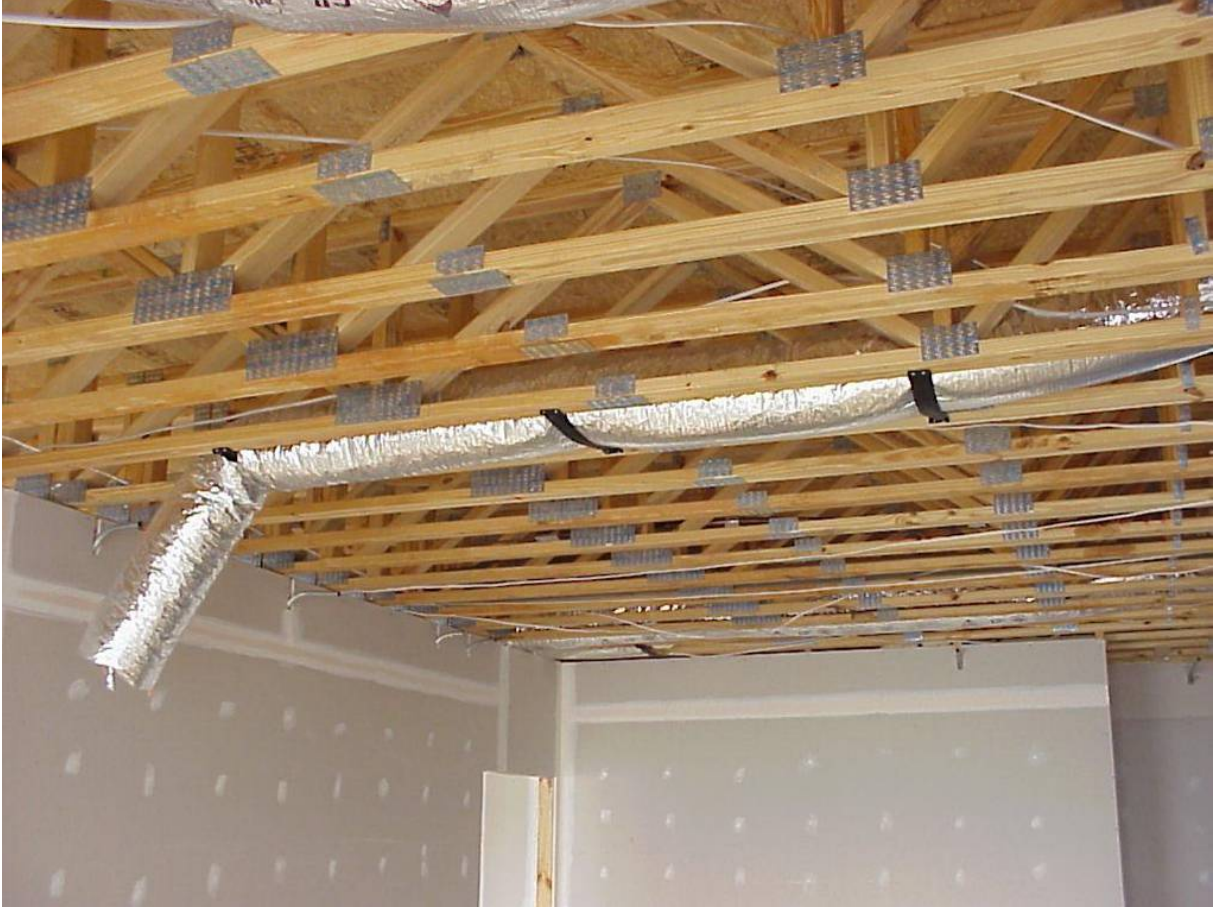
Şekil 4.14 Elektrik ve mekanik tesisatın makaslardan geçirilmesi (Swamidas, 2005b)
