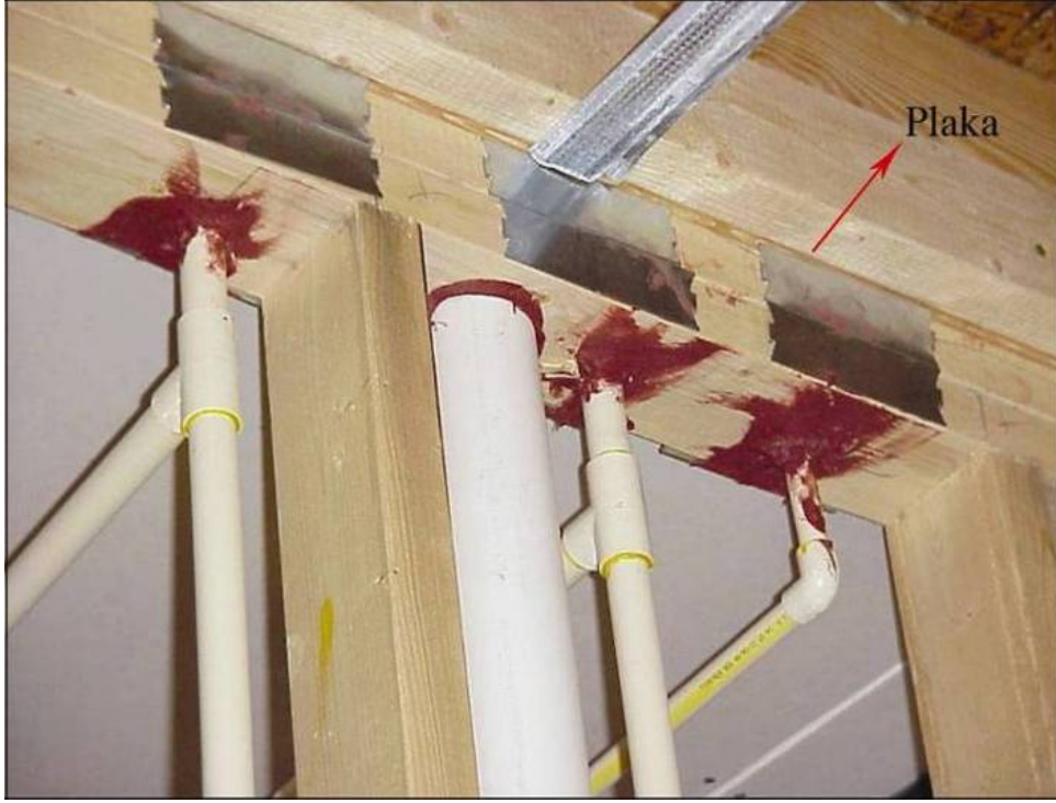
Şekil 4.6 Servis elemanlarını çividen koruyan plaka (Swamidas, 2005b)
