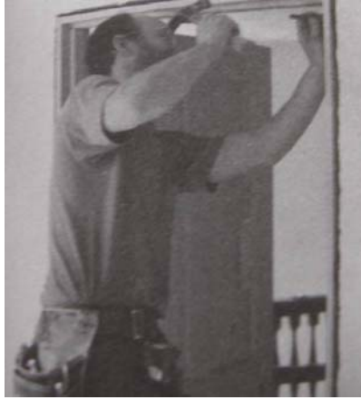
Şekil 3.128 Kasanın montajı (Allen, 1999)
