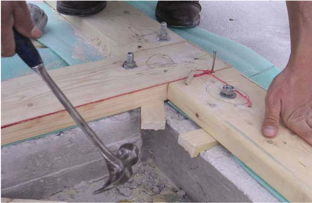
Şekil 3.28 Yastığın temel duvarına bağlanması (Miller, 2003, www.nascor-tr.com )
