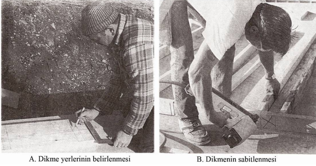
Şekil 3.111 Dikme yerlerinin belirlenmesi ve dikmenin sabitlenmesi (Allen, 1999)
