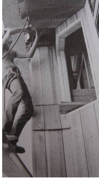
Şekil 3.164 Cephe kaplamasının dikey yönde uygulanması (Allen, 1999)
