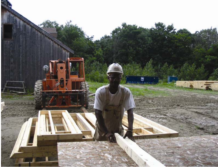
Şekil 3.103 Dikmelerin belirlenen aralıklara göre yan yana getirilmesi (www.ybboston.org)
