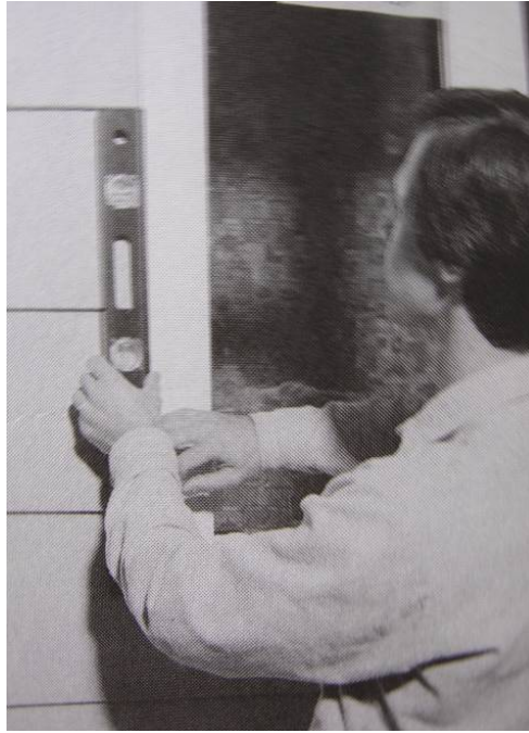
Şekil 3.138 Kasa dikmesinin terazide olup olmadığının kontrol edilmesi (Allen, 1999)
