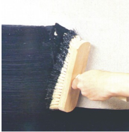
Şekil 5.20 Asfalt tipi yalıtım uygulaması ( www.efeizolasyon.com )
