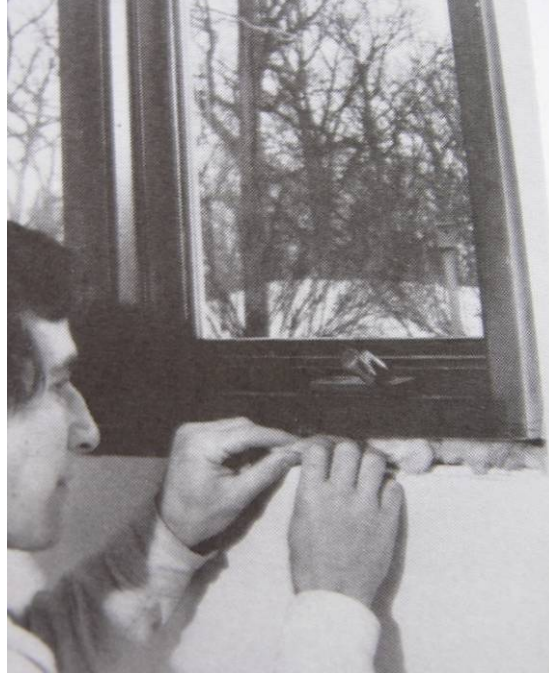
Şekil 3.143 Yalıtımın sağlanması için boşluğun silikonlanması (Allen, 1999)
