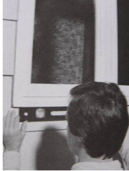
Şekil 3.136 Denizliğin terazide olup olmadığının kontrol edilmesi (Allen, 1999)
