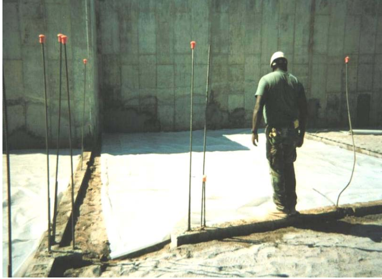
Şekil 3.43 Ahşap platform yapı için betonarme zemin hazırlığı (Swamidas, 2005a)
