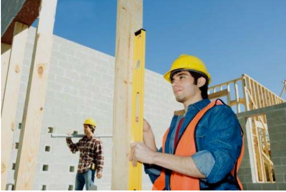
Şekil 3.116 Duvar çerçevesinin teraziye alınması (www.gettyimages.com)
