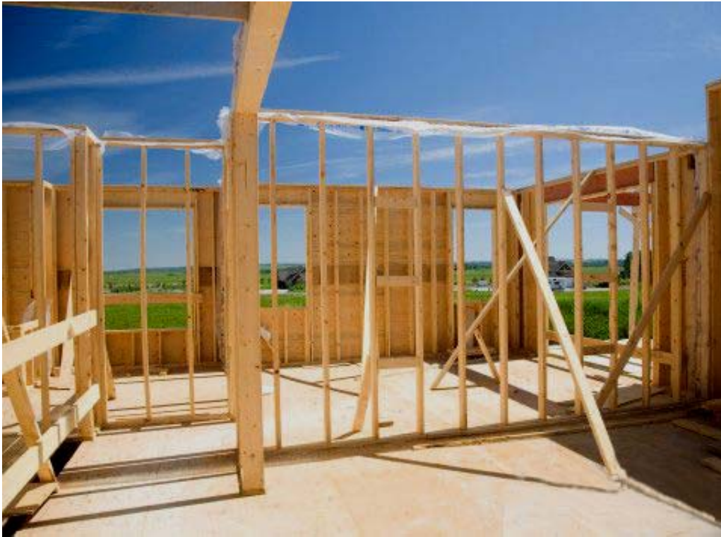
Şekil 5.114 Duvar çerçevesinin geçici diyagonallerle desteklenmesi ( www.gettyimages.com )
