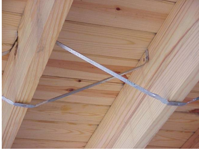
Şekil 3.72 Döşeme kirişleri arasında çelik kuşaklamanın kullanılışı (Swamidas, 2005a)
