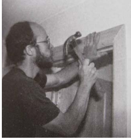
Şekil 3.130 Pervazın kapı çerçevesine çivilenmesi (Allen, 1999)
