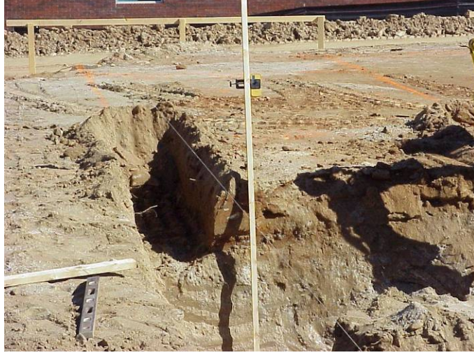
Şekil 3.12 Temel çukurunun kazılması (Swamidas, 2005)
