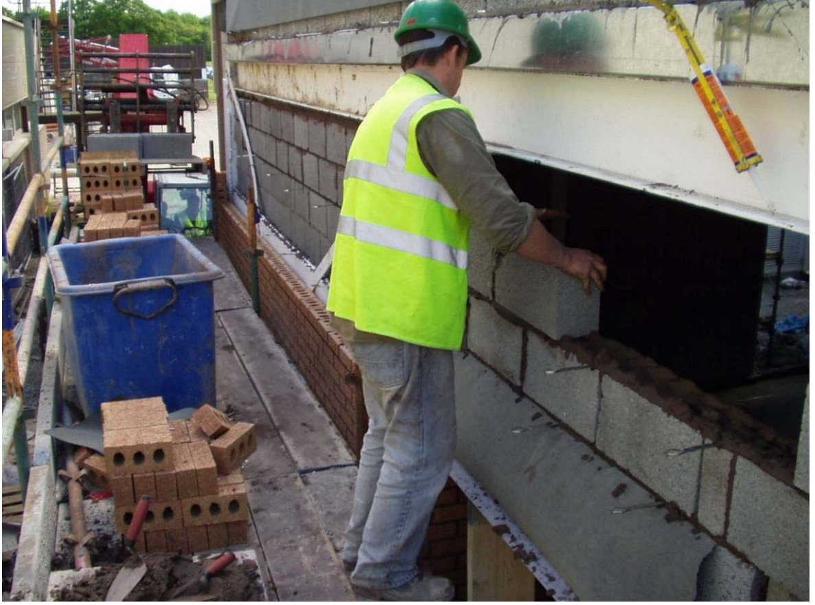
Şekil 3.3 Hazır beton blok üzerine harç uygulama işlemi ( www.northstone-ni.co.uk )
