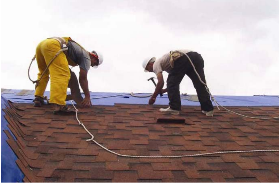
Şekil 3.222 Shingle uygulanma süreci (www.nascor-tr.com www, topcularyapi.com.tr)
