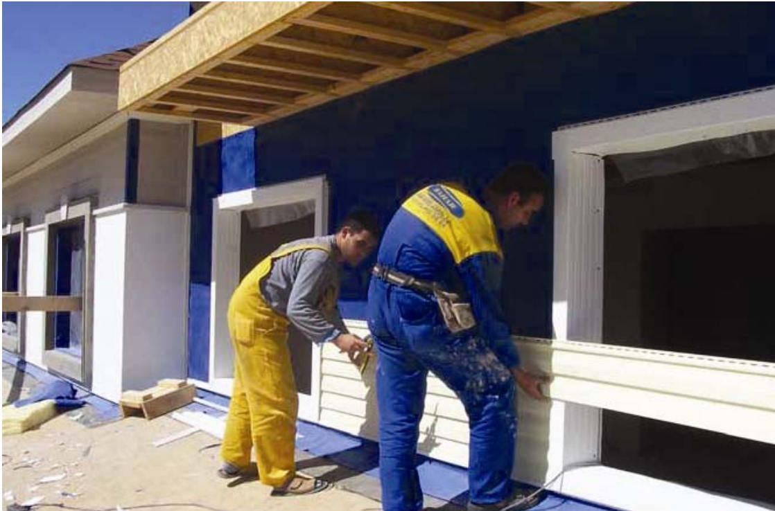
Şekil 3.170 Isı yalıtım üzerine Al cephe kaplamasının uygulanması (www.nascor-tr.com)
