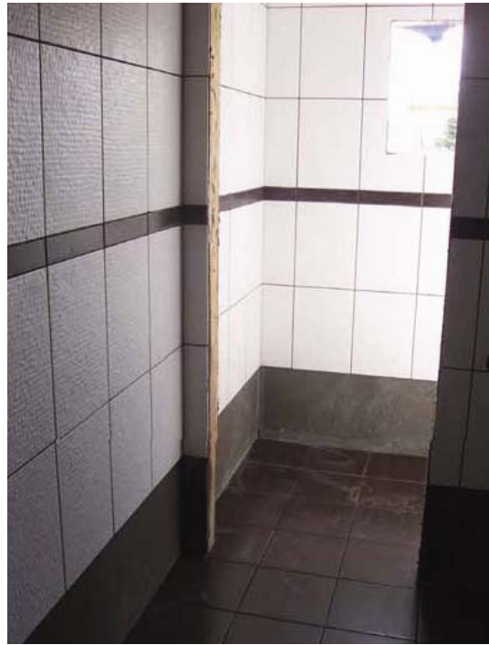
Şekil 3.176 İç duvarda seramik uygulaması ( www.nascor-tr.com )
