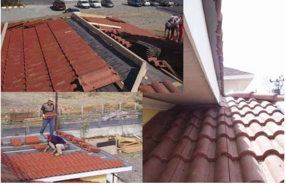
Şekil 3.219 Çatıda kiremit kaplaması ( www.nascor-tr.com )
