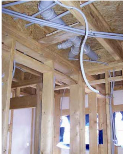
Şekil 4.1 Bodrum kat duvarında tesisat borularının uygulanması (www.nascor-tr.com)
