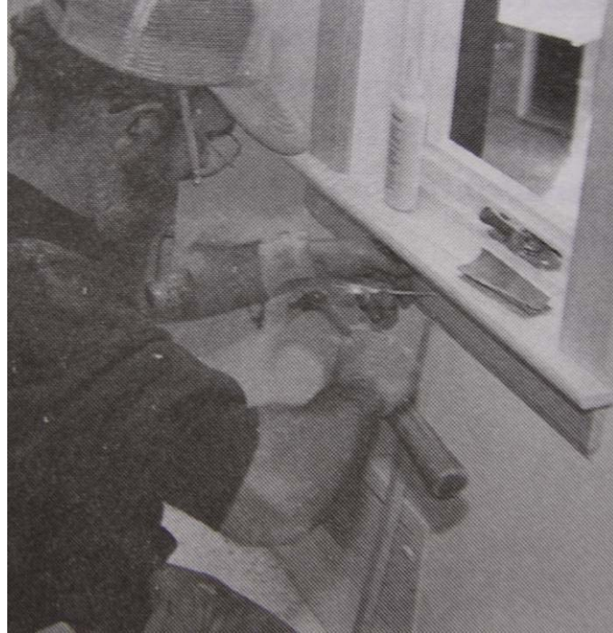
Şekil 3.150 Çivilenen tabliyenin geçici olarak çubukla desteklenmesi (Allen, 1999)
