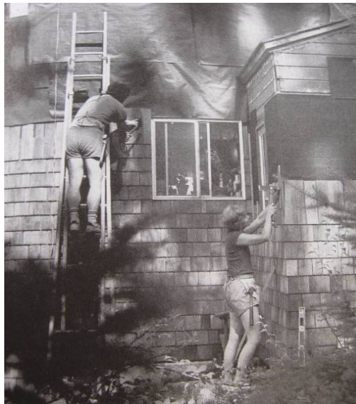
Şekil 3.165 Shingle kaplamanın uygulanması (Allen, 1999)
