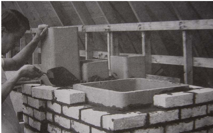
Şekil 4.26 Metal baca uygulaması ve tuğla kaplanması (Allen, 1999)
