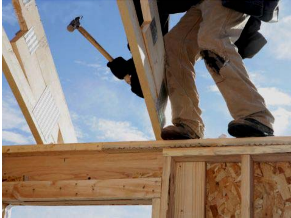
Şekil 3.117 Duvar çerçevesi ile çatı makaslarının bağlanması (www.gettyimages.com)
