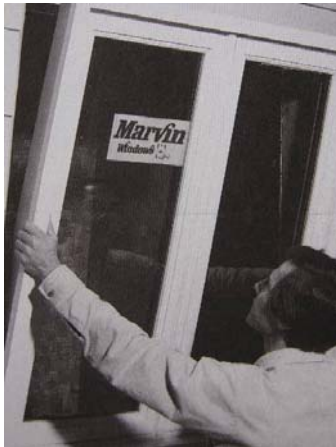
Şekil 3.134 Pencere açılan boşluğa yerleştirilmesi ve sabitlenmesi (Allen, 1999)
