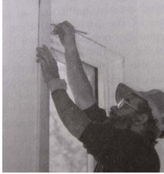
Şekil 3.145 Pervaz genişliği işaretlenmesi (Allen, 1999)
