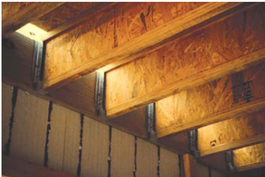
Şekil 3.50 Hazır olarak üretilen I formulu ahşap kiriş (Swamidass, 2005)
