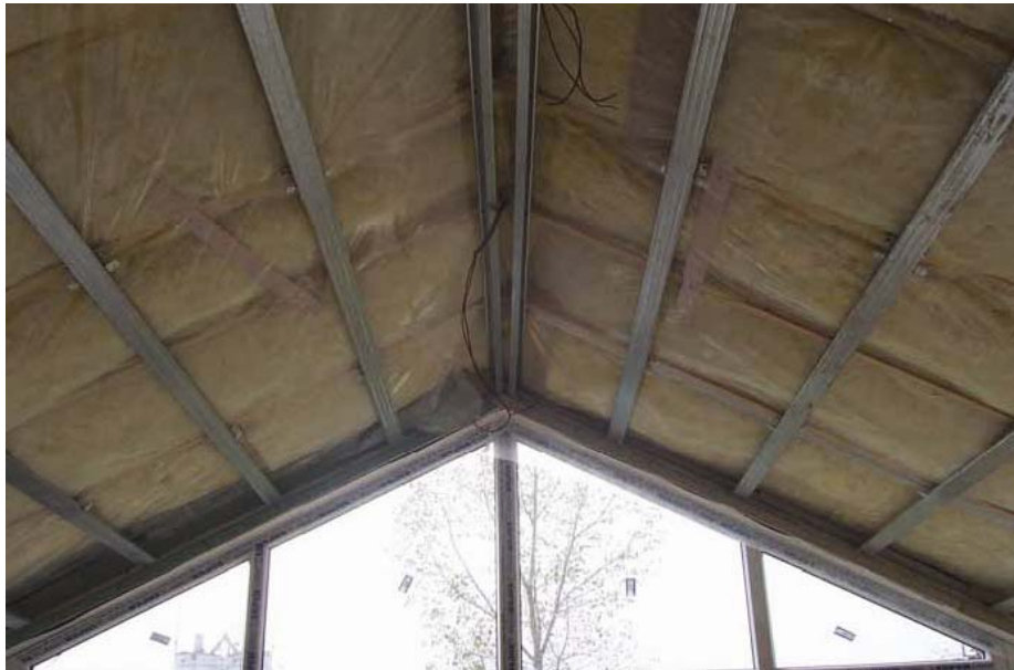
Şekil 5.10 Isı yalıtımının mertek aralarında uygulanması (www.nascor-tr.com)
