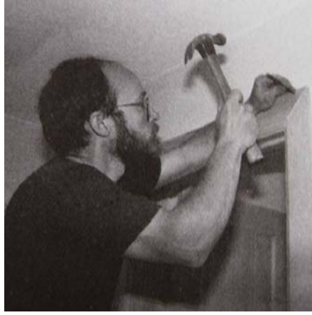
Şekil 3.131 Sövenin üst kısmı duvara çivilenmesi (Allen, 1999)
