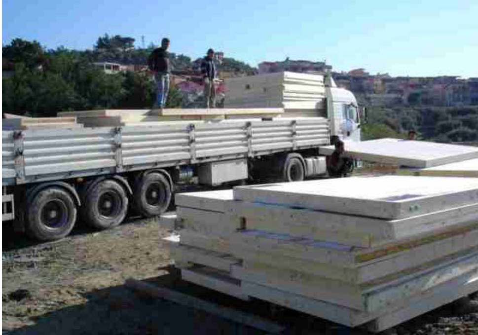
Şekil 2.13 Duvar bileşenlerinin uygulama alanına getirilmesi (www.ionialtd.com.tr)
