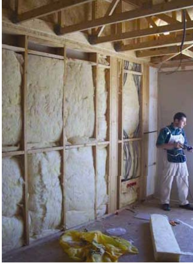
Şekil 5.6 Duvarda ısı yalıtımı uygulaması (www.nascor-tr.com)
