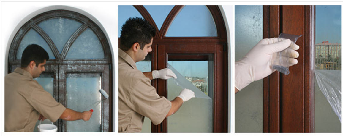
Şekil 3.154 Pencere kenarlarında geçici koruma kaplaması uygulaması (www.arbor.com.tr)
