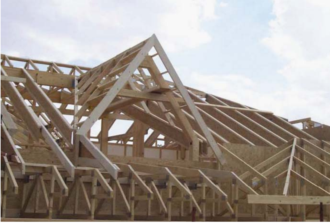
Şekil 3.187 Çatı çerçevesinde I kirişlerin kullanılması (www.nascor-tr.com)
