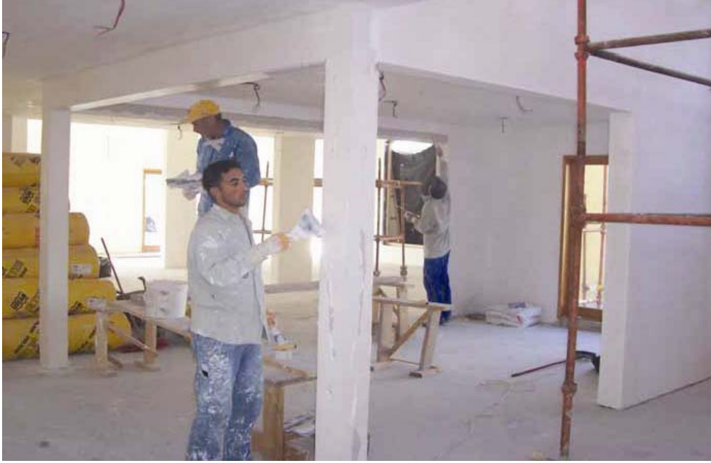
Şekil 3.175 İç duvarda saten alçı uygulaması ( www.nascor-tr.com )
