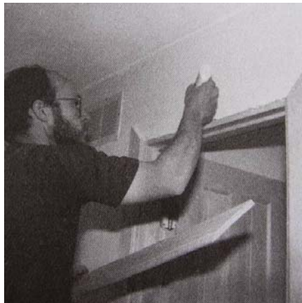
Şekil 3.129 Pervazın tutkallanması (Allen, 1999)
