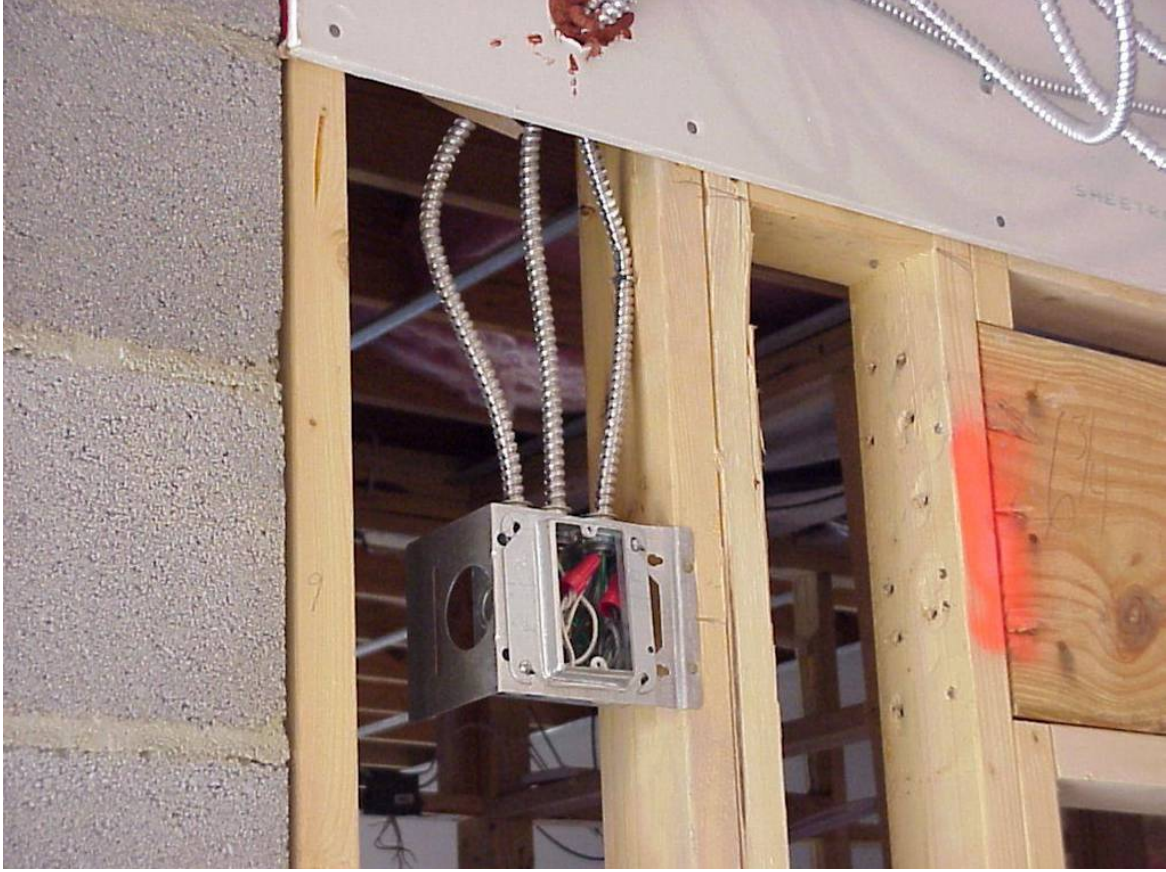
Şekil 4.13 Ahşap yapılarda buatsız elektrik panosunun uygulanması (Swamidas, 2005b)
