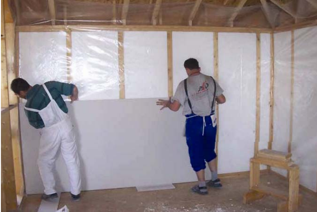
Şekil 3.174 İç duvarda alçıpan uygulaması ( www.nascor-tr.com )
