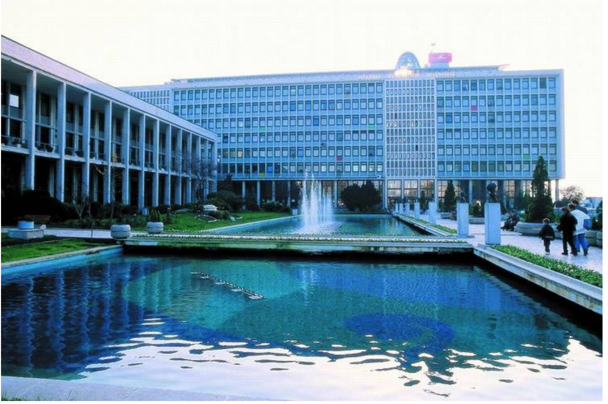
Resim 4.17 İBB Binası, Fatih
