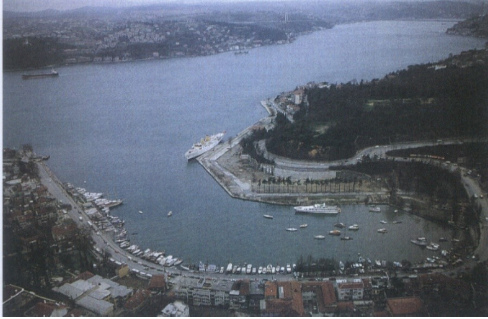
Resim 2.19 1985 turizm bölgesi ilan edilen, 1991’de kaldırılan İstinye Tersanesi, henüz kullanım belirsizliği nedeniyle boş durmaktadır (Çelebi, B.1993).
