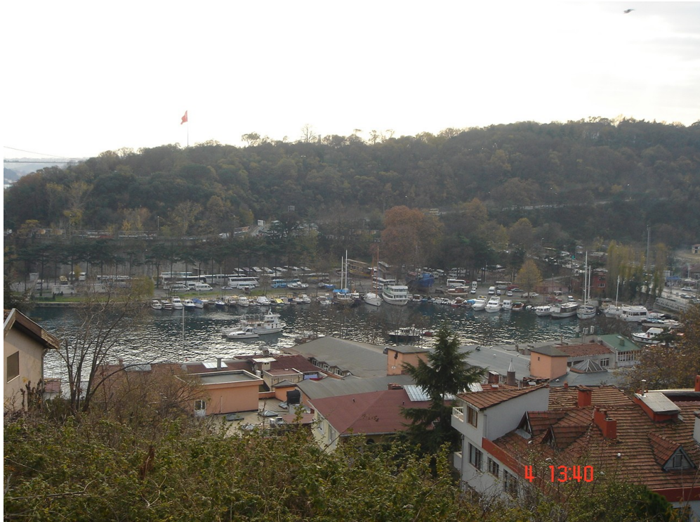
Resim 3.10 Turizm alanı ilan edilen eski Tersane Bölgesi'nin otopark olarak kullanımı / İstinye (04-12-2007 Foto: Z.Turunç).
