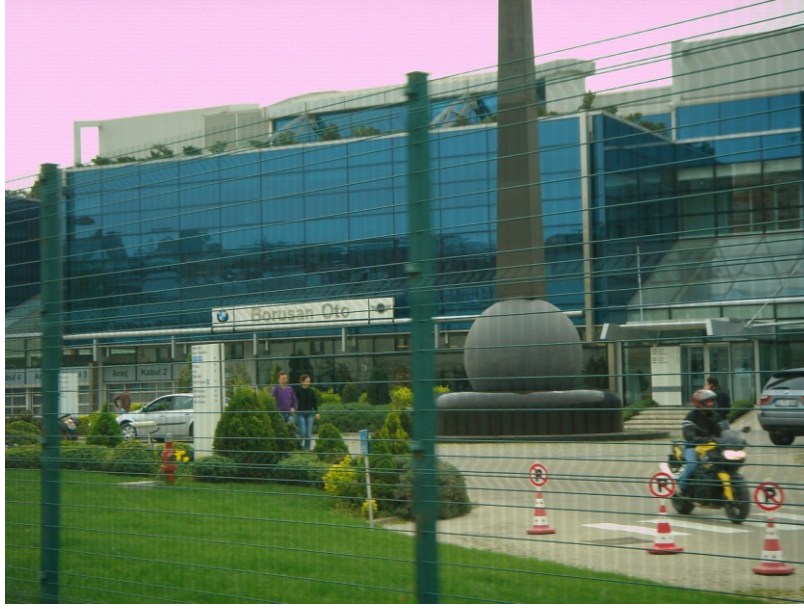
Resim 3.17 Borusan Oto- Dereiçi Caddesi'nden sahile inerken görünümü / İstinye (13-04-2008 Foto: Z.Turunç).
