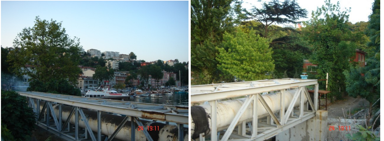
Resim 3.33 İstinye Deresi'nin ve atıksuların Baltalimanı Atık Su Tesisi'ne gitmesi için düzenlenen borular kıyıda kot farkı yüzünden kendini göstermektedir/ İstinye (24-06-2007 Foto: Z.Turunç).
