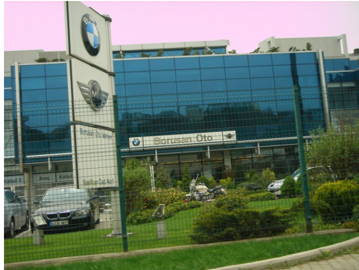
Resim 3.18 Borusan Oto- Dereiçi Caddesi'nden sahile inerken görünümü / İstinye (13-04-2008 Foto: Z.Turunç).
