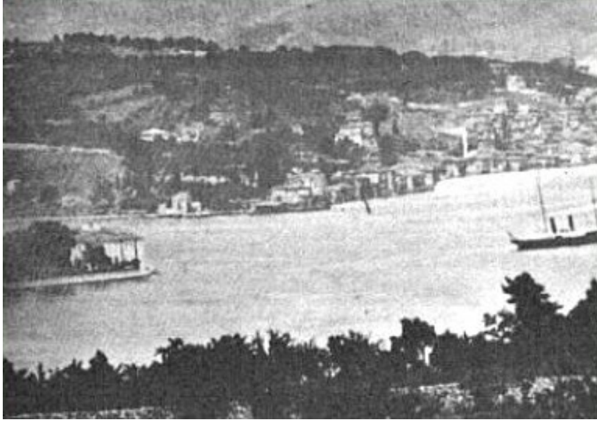
Resim 3.3 İstinye Koyu –Osmanlı zamanından görünüşü.
