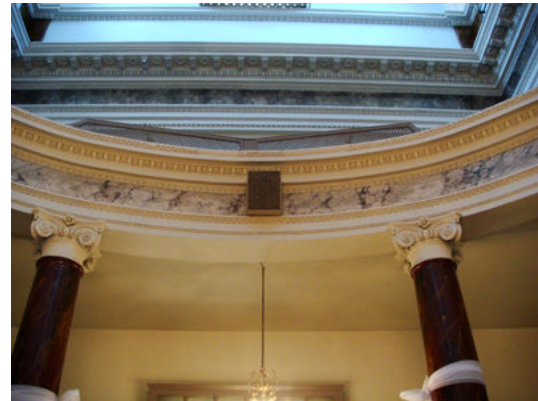
Şekil 3.1.66. Sakızağacı Sırp Asdvadzadz'n Patrikhane Kilisesi'nin narteksinin üstündeki saçak korniş
