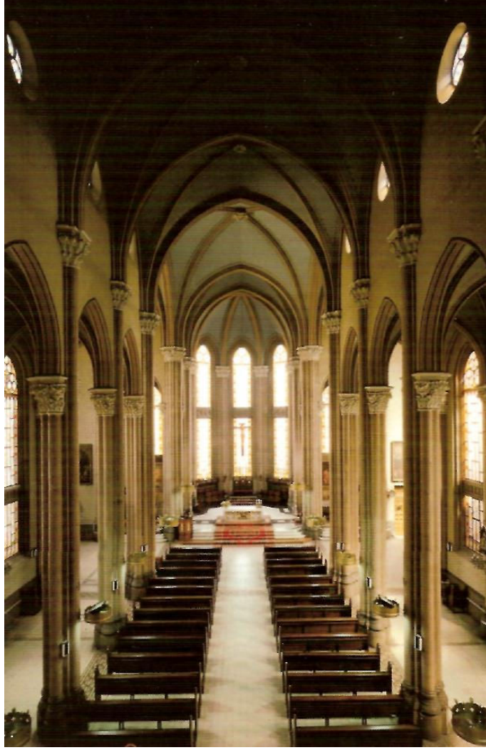
Şekil 4.3.12. Saint Antoine Kilisesi, İç Mekan batıdan [3]
