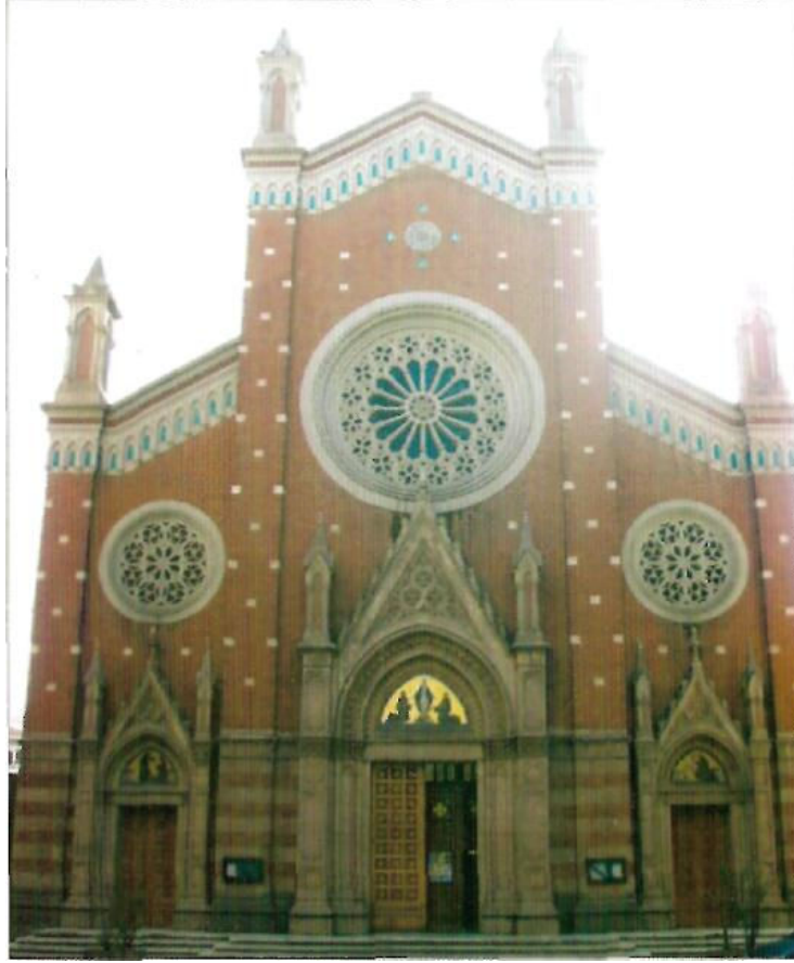
Şekil 4.3.1. Saint Antoine Kilisesi'nin Batı cephesi (Griş Ccephesi)
