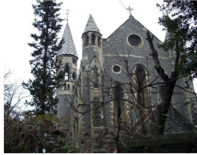
Şekil 3.1.122. Kırım Kilisesi, batı cephesi ,avlunun dışından
