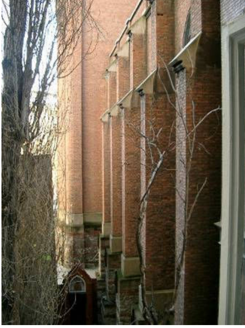
Şekil 4.3.2. Saint Antoine Kilisesi'nin Güney Cephesi
