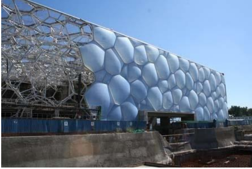
Şekil 3.6 Water Cube projesinin uygulama süreci.
