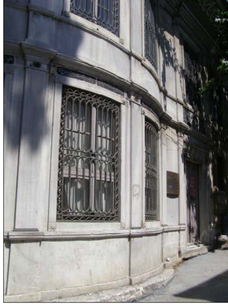
Resim 4.10.5 Muvakkithanenin giriş cephesi
