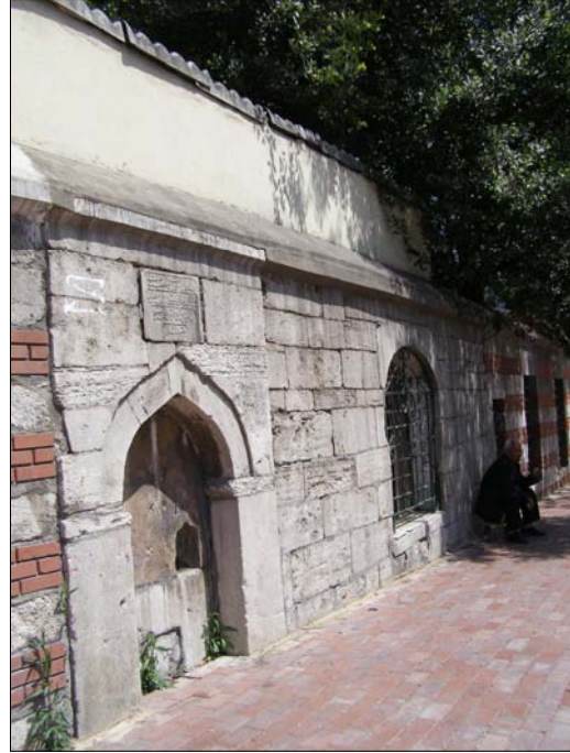
Resim 4.4.4 Muvakkithanenin yoldan çeşmeyle beraber görünümü
