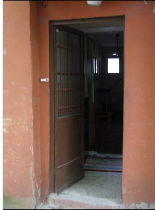
Resim 3.1.3 Muvakkithanenin iç mekan görünümü
