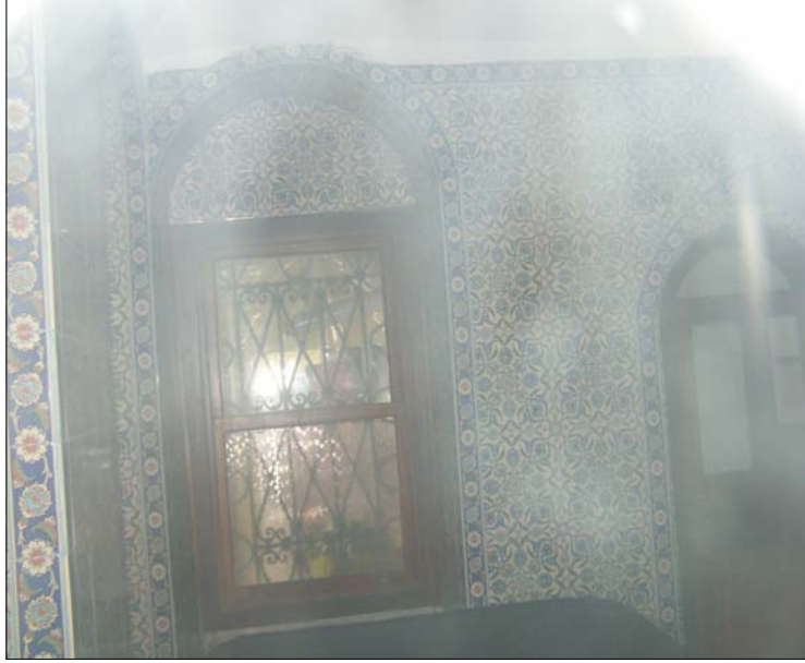
Resim 4.15.3 Muvakkithanenin iç mekan görünümü
