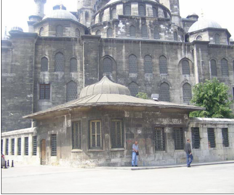
Resim 4.11.3. Muvakkıthanenin yoldan görünümü
