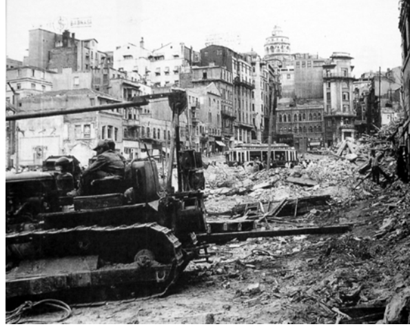
Şekil 4.4 Karaköy Meydanı düzenlemesi sırasında yıkım faaliyetinden bir görüntü, 1958 (Kuban, 1994)
