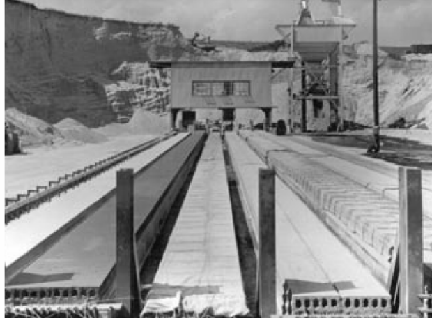
Şekil 2.3 Ön üretilmiş ön-germe uygulanmış boşluklu döşeme elemanları (PCI, 2005)
