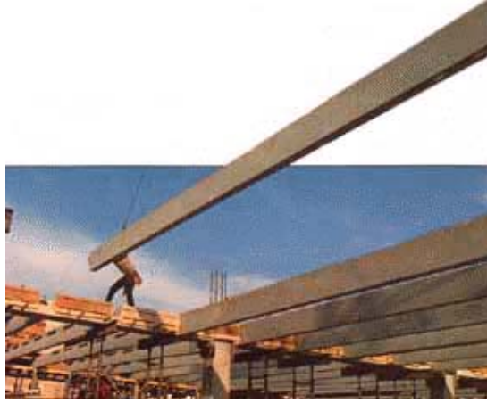
Şekil 2.13 Ön üretimli iskelet sistem elemanlarının montaj aşaması [9]
