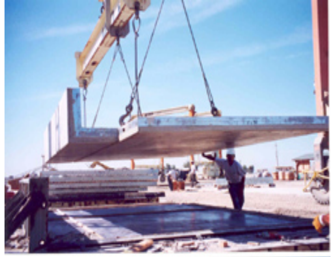
Şekil 2.17 Panellerin taşınması [11]
