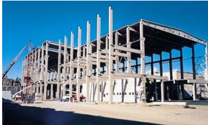
Şekil 2.24 Taşıyıcı sistemi çelik olup duvarlar ön üretimli büyük boy panel sistem elemanlardan üretilen yapı, İtalya [13]
