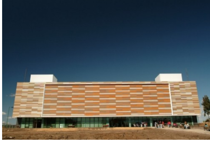
Şekil 2.34 Ön üretilmiş panel sistem ile üretilmiş yapı, Şili [15]
