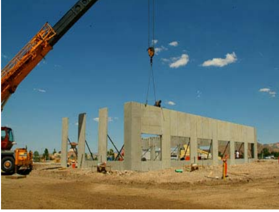
Şekil 2.18 Panellerin montajı [11]
