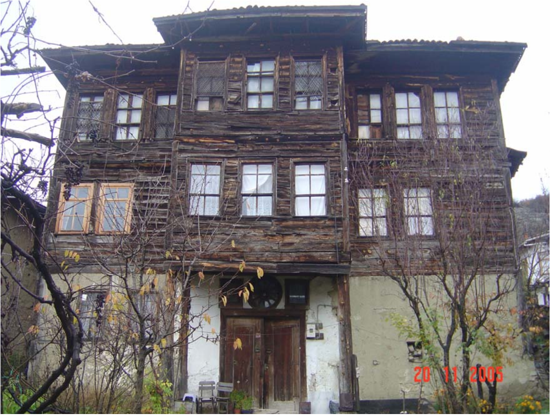
Şekil 5.21 Giriş (batı) cephesi.
