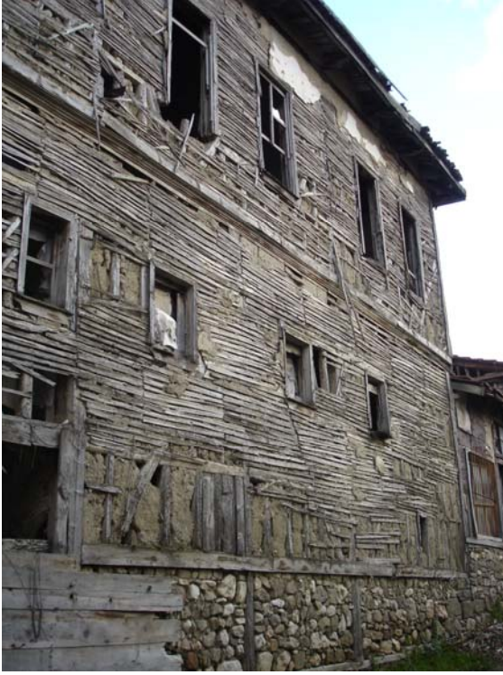
Şekil 4.6 Bağdadi sıva için çakılmış çıtalar, Büyük Han, 2007.
