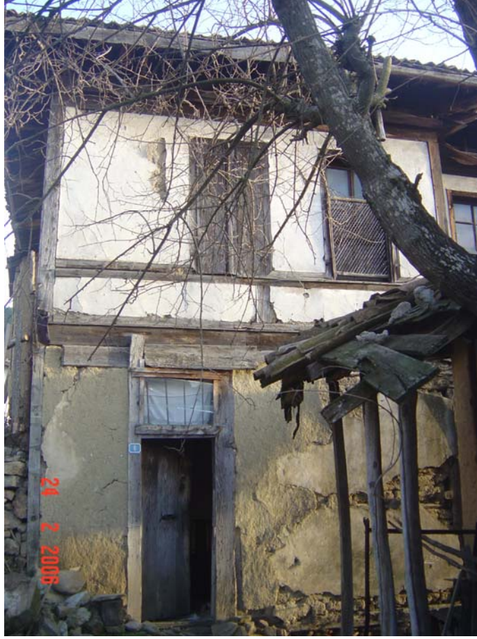
Şekil 5.25 Kuzey cephesi, giriş kapısı.
