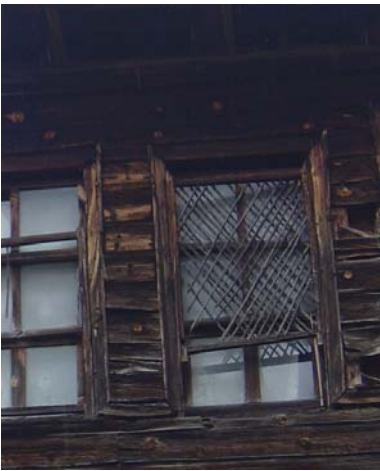
Şekil 4.21 Ahşap kafesli pencere, 2007
