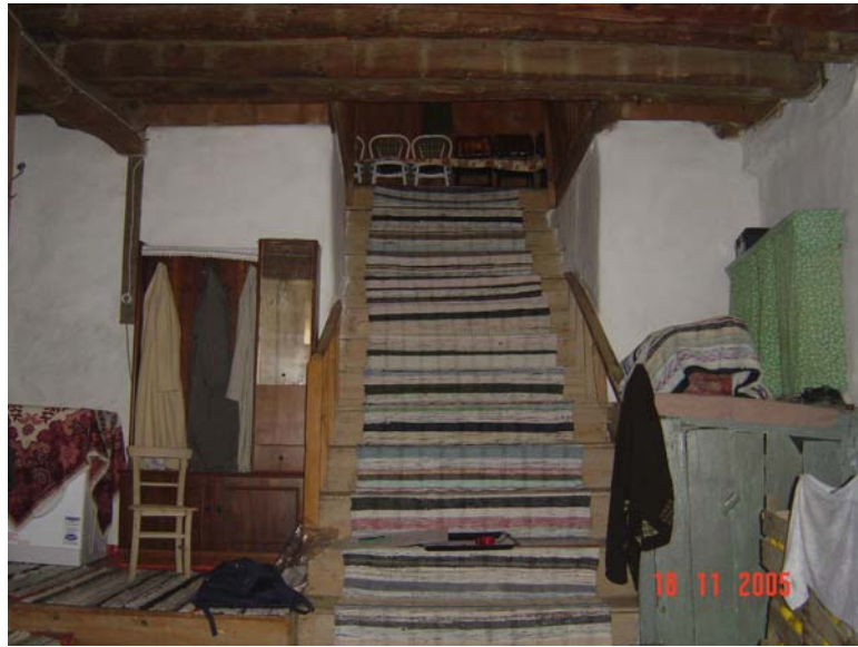
Şekil 5.5 Zemin katta yer alan ahşap merdiven (Z01).
