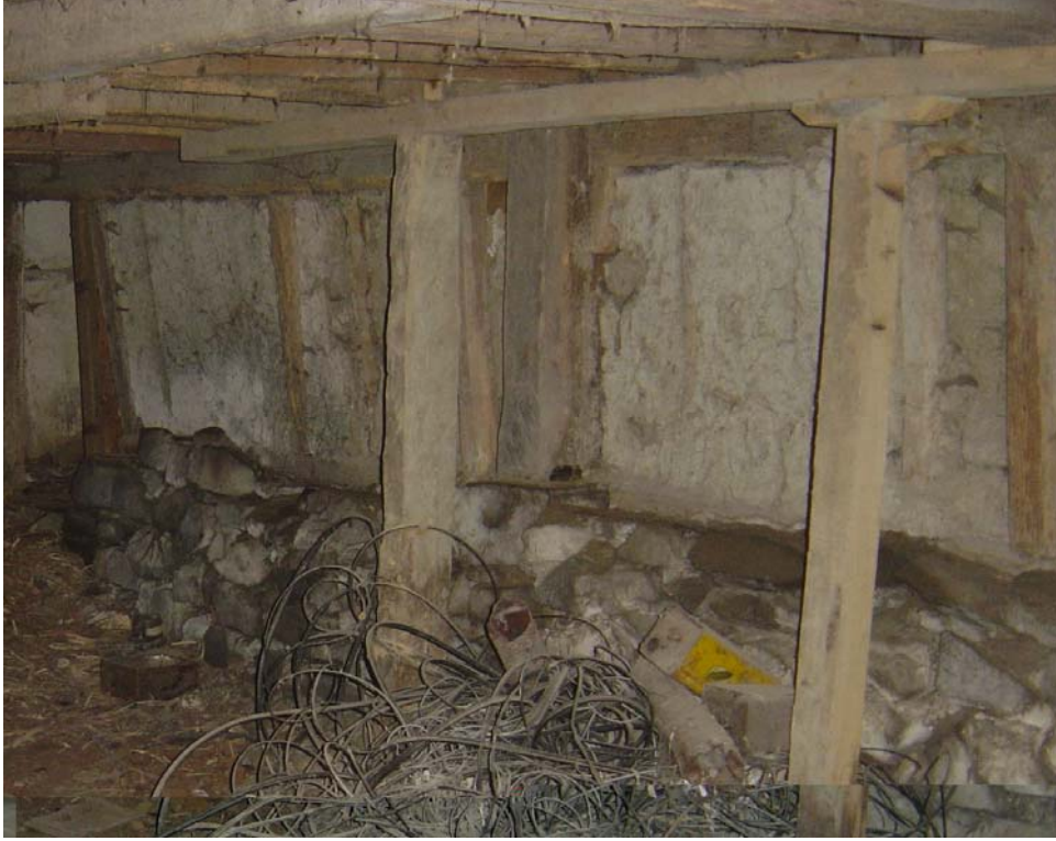
Şekil.4.1 Hacı Rıfatlar Konağı, moloz taş temel ve ahşap çatkılı duvarın birleşimi, 2005.
