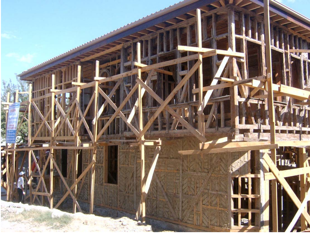
Şekil 6.13 Hacı Rıfatlar Konağı, restorasyon sırasında, 2007.
