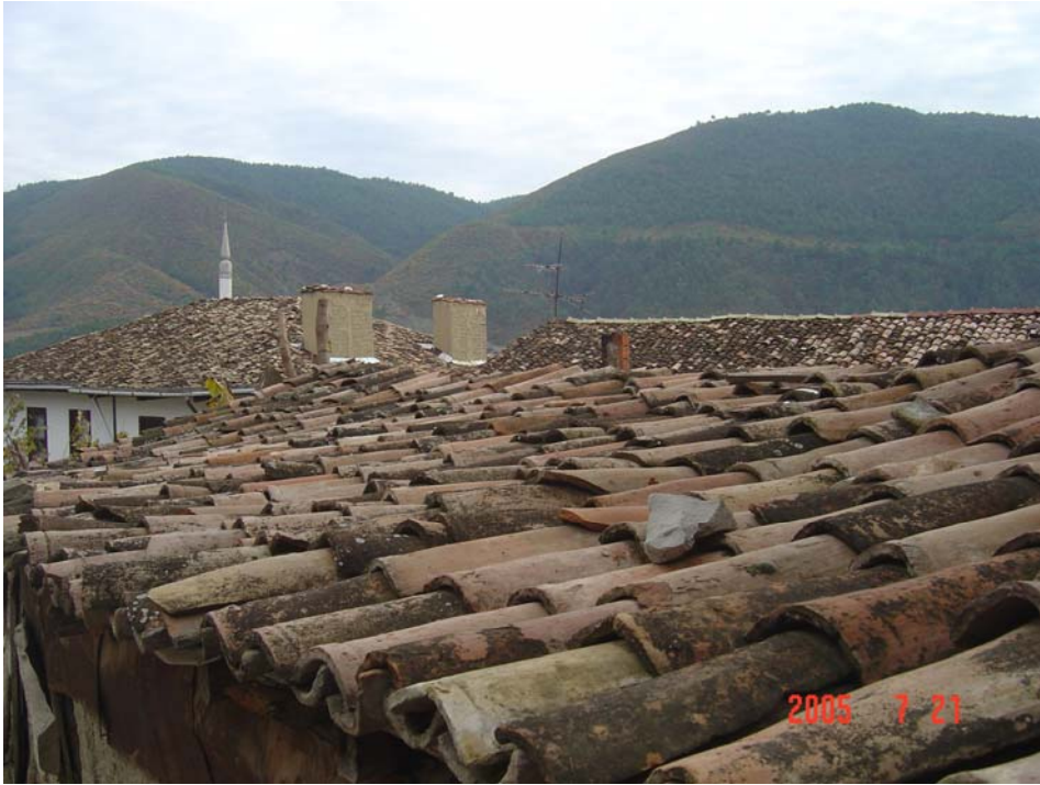
Şekil 4.12 Taraklı, çatıda alaturka kiremit kaplaması, 2005.
