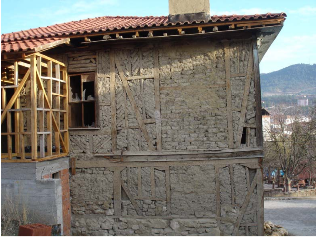
Şekil 4.4 Çakırlar Konağı, moloz taş temel üzeri kerpiç dolgulı ahşap çatkılı duvar, 2007.
