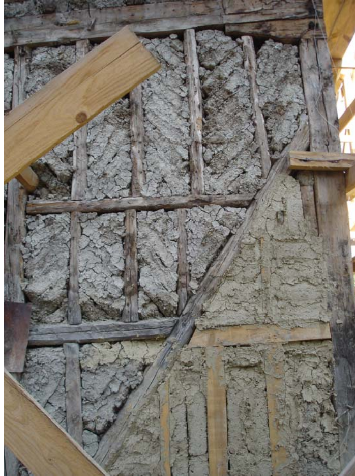
Şekil 4.2 Hacı Rıfatlar Konağı, duvar detayı, 2006
