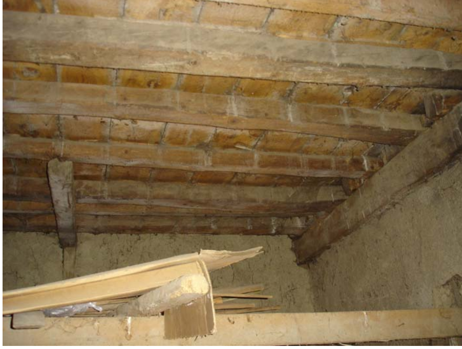
Şekil 4.10 Sadık Özen evi, ahşap döşeme kirişleri ve kaplaması, 2007.
