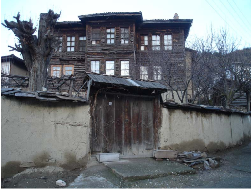
Şekil 5.1 Sadık Özen evi, meydandan bahçe girişi ve bahçe duvarı, 2006
