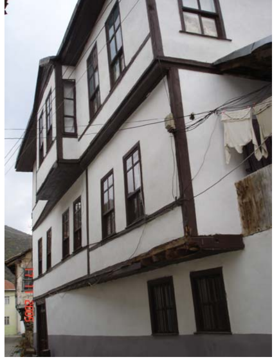
Şekil 4.14 Türbe Sokak, basit konsol çıkma, 2007.
