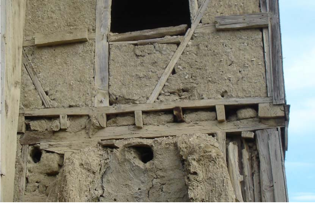
Şekil 4.8 Bahattin Keskin evi, döşeme kirişlerinin ahşap taban üzerine oturması, 2007.
