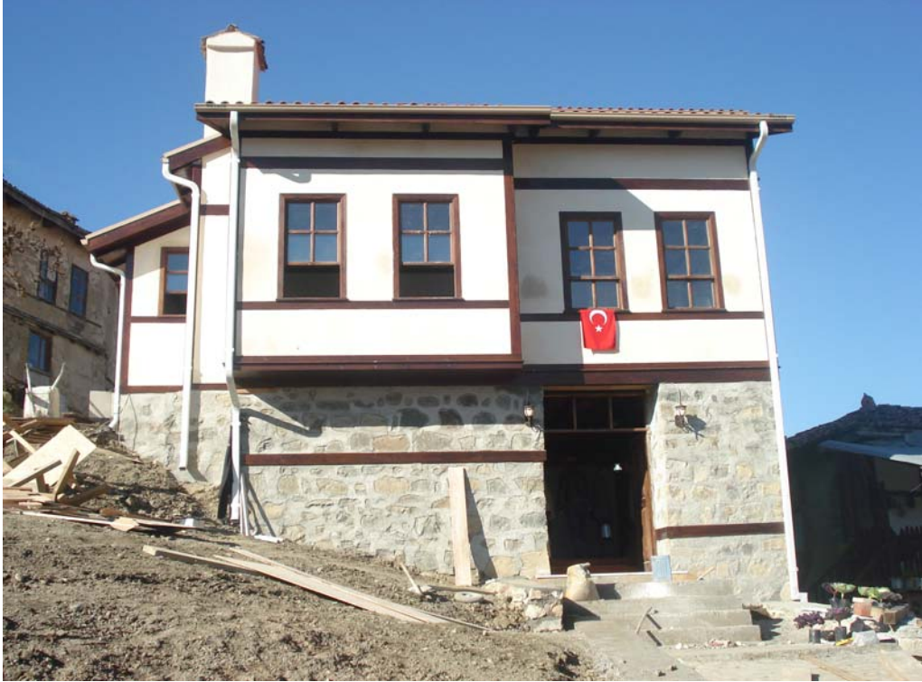
Şekil 6.10 Hisar Konuk evi, Restorasyon sonrası, 2007.
