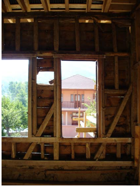
Şekil 4.3 Hacı Rıfatlar Konağı, duvar detayı,2006.
