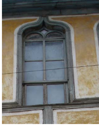
Şekil 4.20 Kemerli giyotin pencere, 2007.
