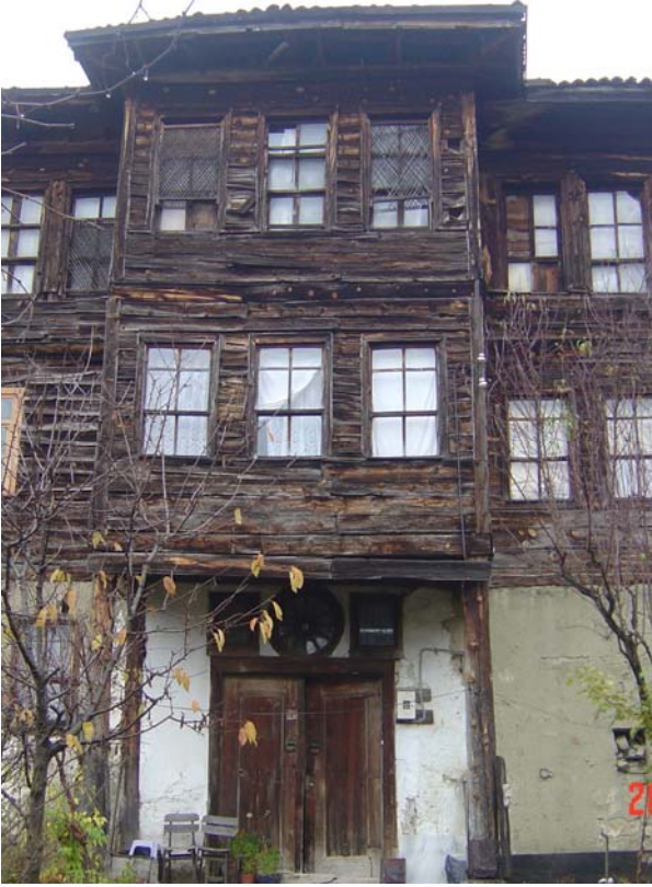
Şekil 4.15 Giriş cephesinde destekli çıkma, 2006.
