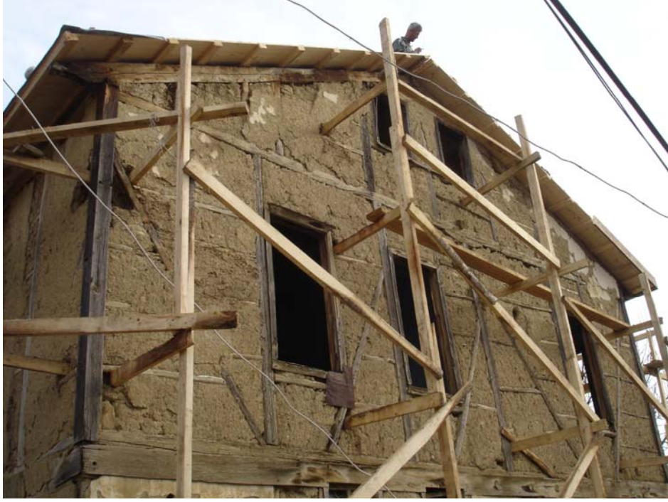
Şekil 4.5 Zeki Cihan evi, kerpiç dolgulu, çamur sıvalı, ahşap çatıklı duvar, 2007.
