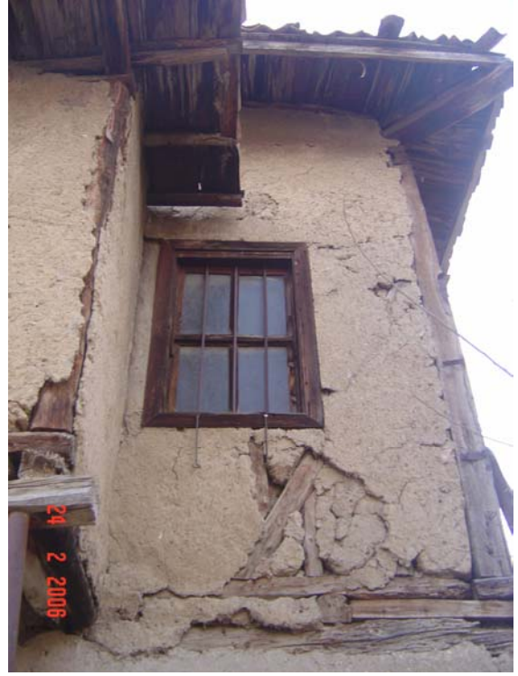
Şekil 4.7 Çamur sıva ile cephenin sıvanması, Sadık Özen evi, 2007.
