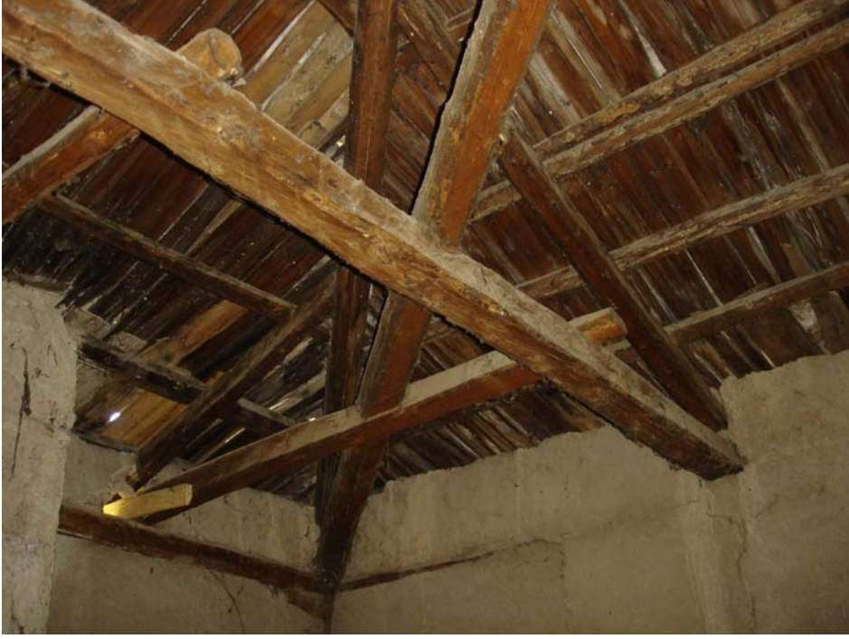
Şekil 4.11 Sadık Özen evi, çatıda ahşap kirişler ve kiremit altı kaplaması, 2007.
