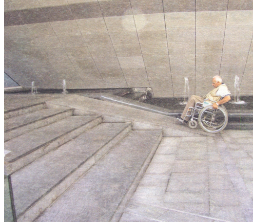
Şekil 4.12 Kötü rampa uygulaması [13]
