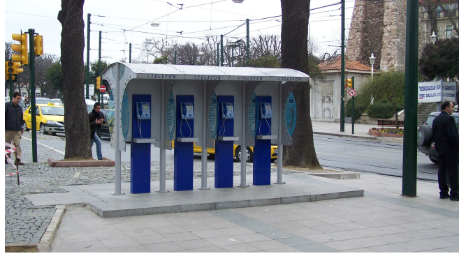
Şekil 4. 9 Çoklu telefon ünitesi örneği
