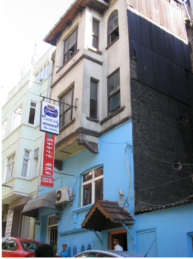
Fotoğraf 8.7 Zemin katı deęiřtirilmiř yapı, Ada 598-Parsel 5
