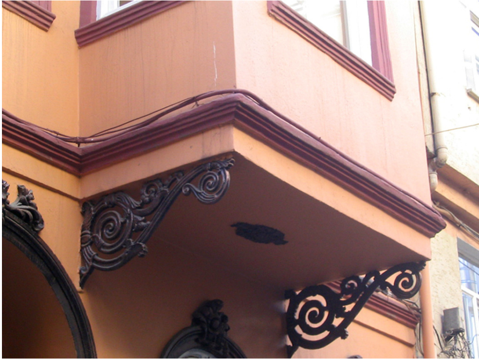
Fotoğraf 6.16 Metal cumba payandası. Ada 609-Parsel 9
