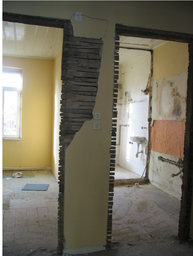
Fotoğraf 5.2 Döşeme ve duvarları ahşap taşıyıcılı kargir yapı iç cephesi ( Ada 618, Parsel 20)
