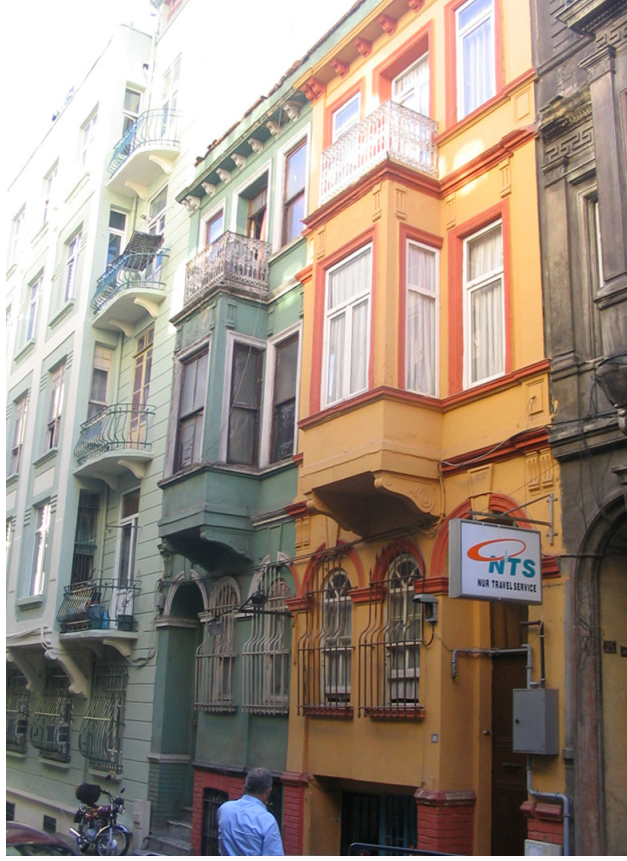
Fotoğraf 5.8 Özgünlüğünü korumuş eski yapı örneği ( Ada 609, Parsel 25-26)
