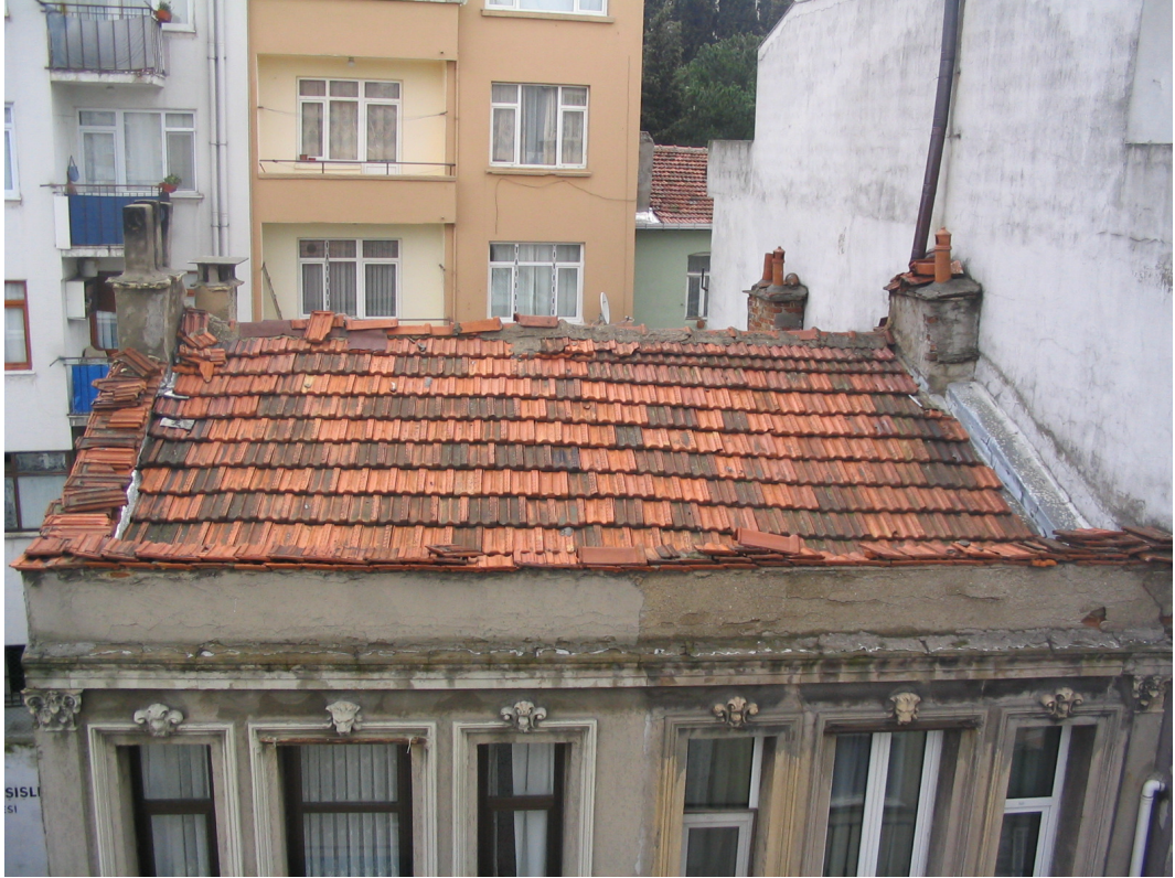
Fotoğraf 7.3 Ön cephe çatı görünüşü ( Ada 621, Parsel 16-17)
