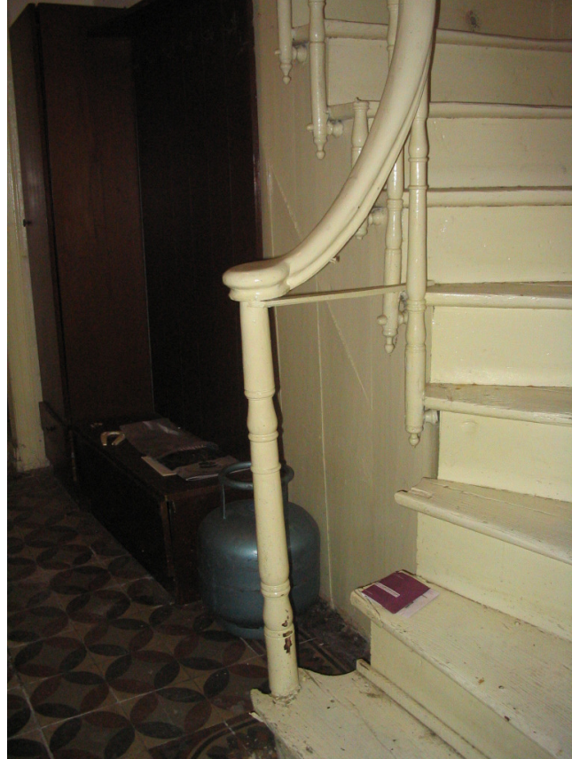
Fotoğraf 7.17 Sağ daire ahşap iç merdiven ( Ada 621, Parsel 16-17)
