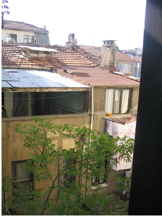
Fotoğraf 7.4 Arka cephe ( Ada 621, Parsel 16-17)
