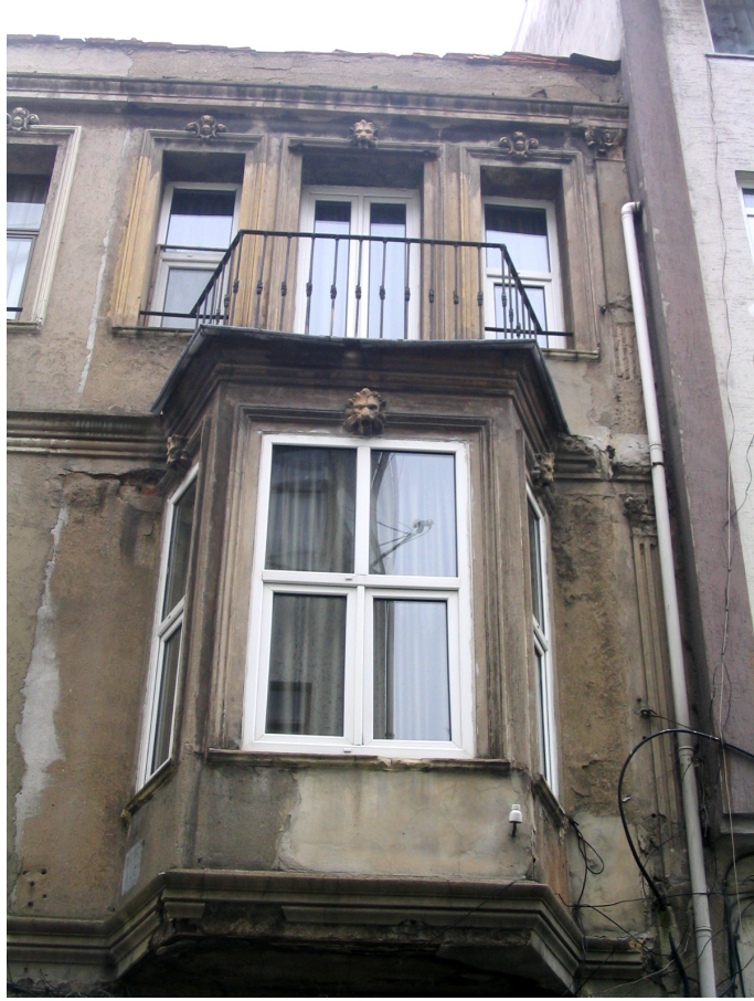
Fotoğraf 7.2 Cumba üzeri balkon ( Ada 621, Parsel 16-17)
