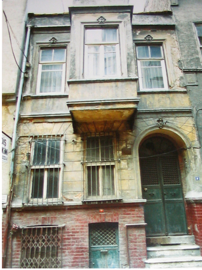
Fotoğraf 8.5 Restorasyon öncesi, Ada 609-Parsel 22 (Kurul Arşivi)
