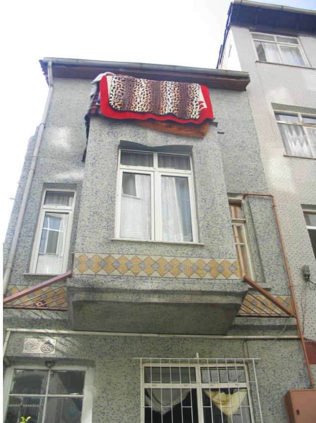
Fotoğraf 8.8 Cephe kaplaması ve pencereleri deęiřtirilmiř yapı, Ada 597-Parsel 17
