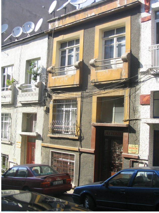
Fotoğraf 5.6 1925-1950 yılları arasında inşa edilmiş 2-3 katlı yapı ( Ada 608, Parsel 5)
