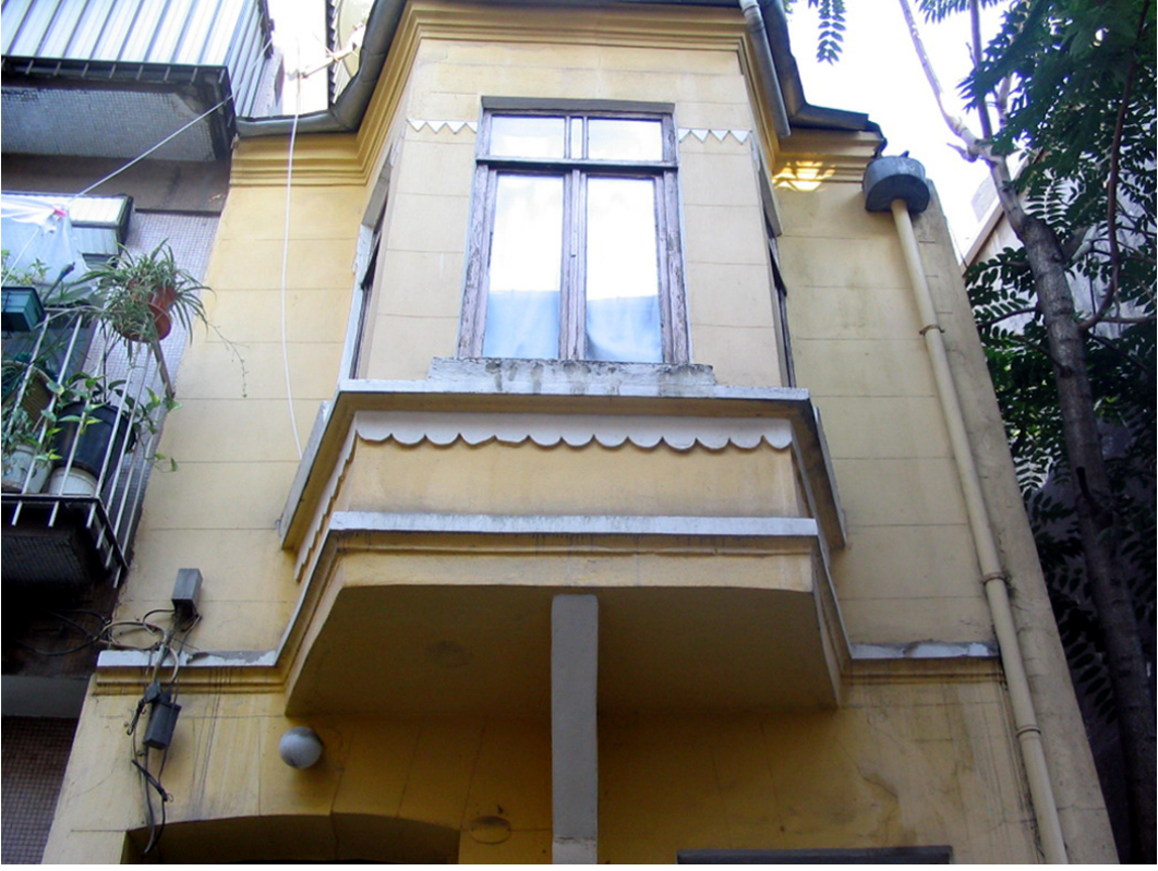
Fotoğraf 6.10 Kenarları pahlı cumba . Ada 612-Parsel 17
