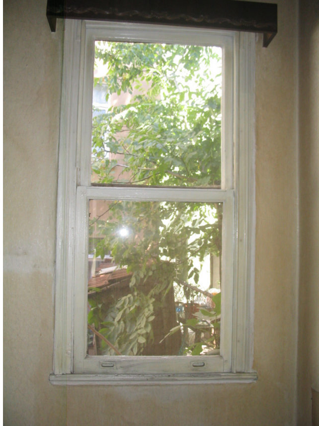
Fotoğraf 7.19 Giyotin pencere iç görünüşü, sağ daire ( Ada 621, Parsel 16-17)
