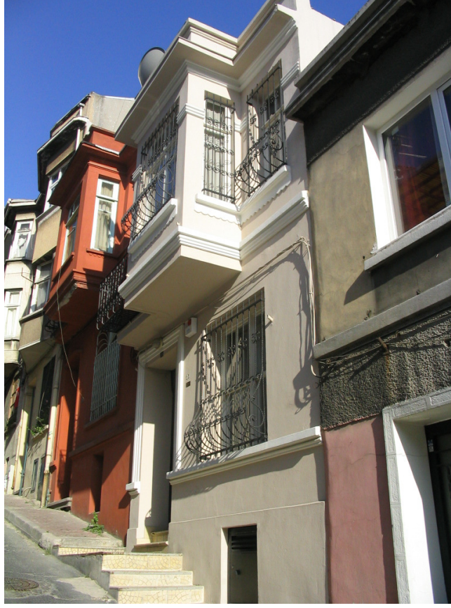
Fotoğraf 6.11 Cumba üzeri çatılı yapı. Ada 608-Parsel 16
