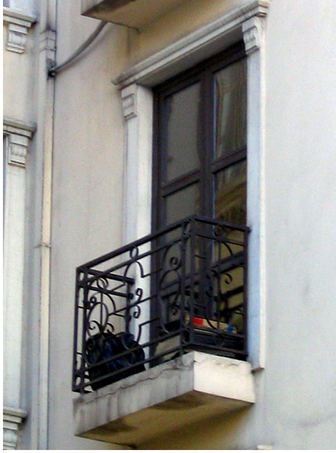
Fotoğraf 6.15 Metal korkuluklu Fransız balkonu . Ada 619-Parsel 1
