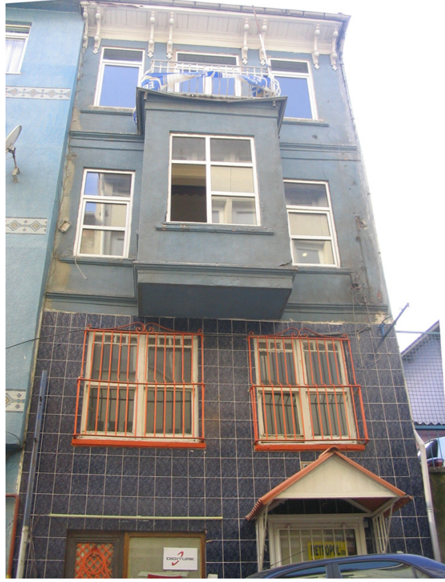
Fotoğraf 5.1 Döşeme ve duvarları ahşap taşıyıcılı kargir yapı dış cephesi ( Ada 618, Parsel 20)
