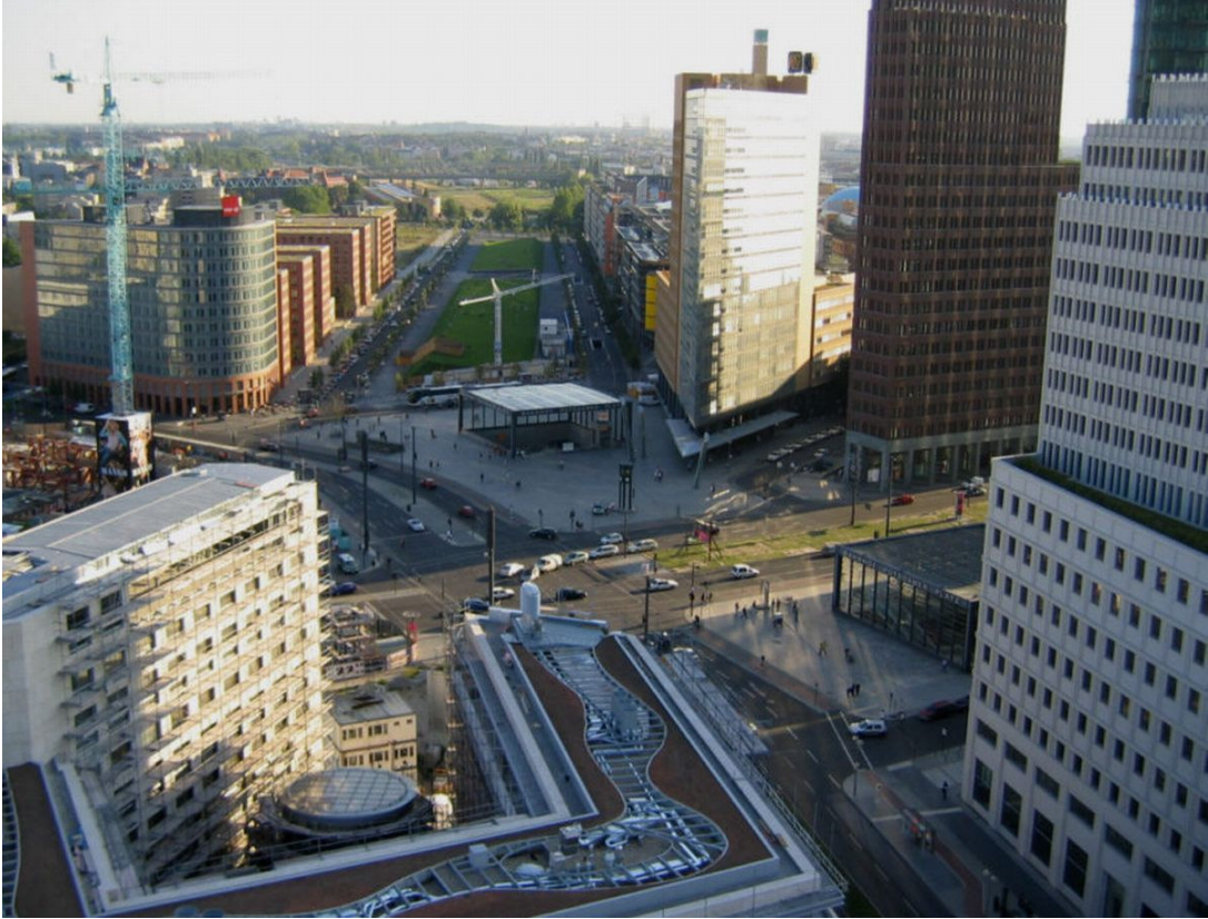
Şekil 4.12, Postdamer Platz Meydanı'nın günümüz hali.
