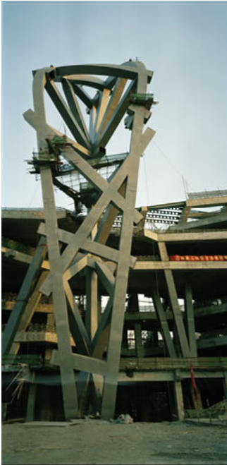
Şekil 4.25 Taşıyıcı eleman detayları
