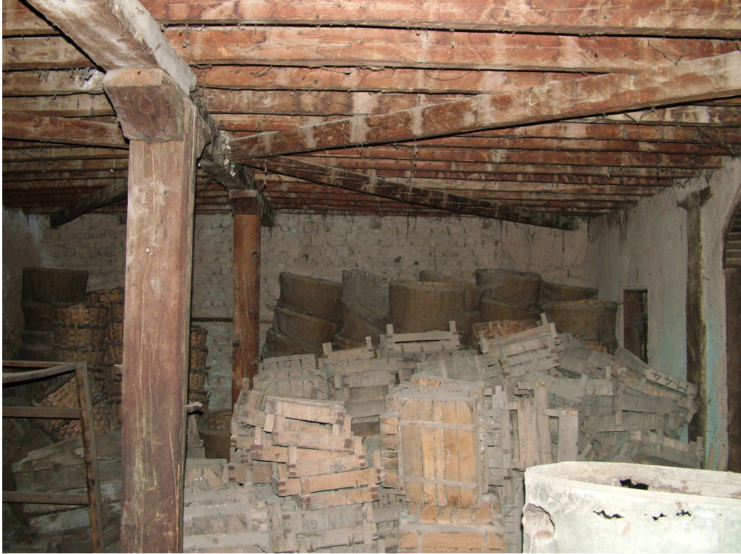
Resim 3.22 Birinci bodrum kattan görünüm
