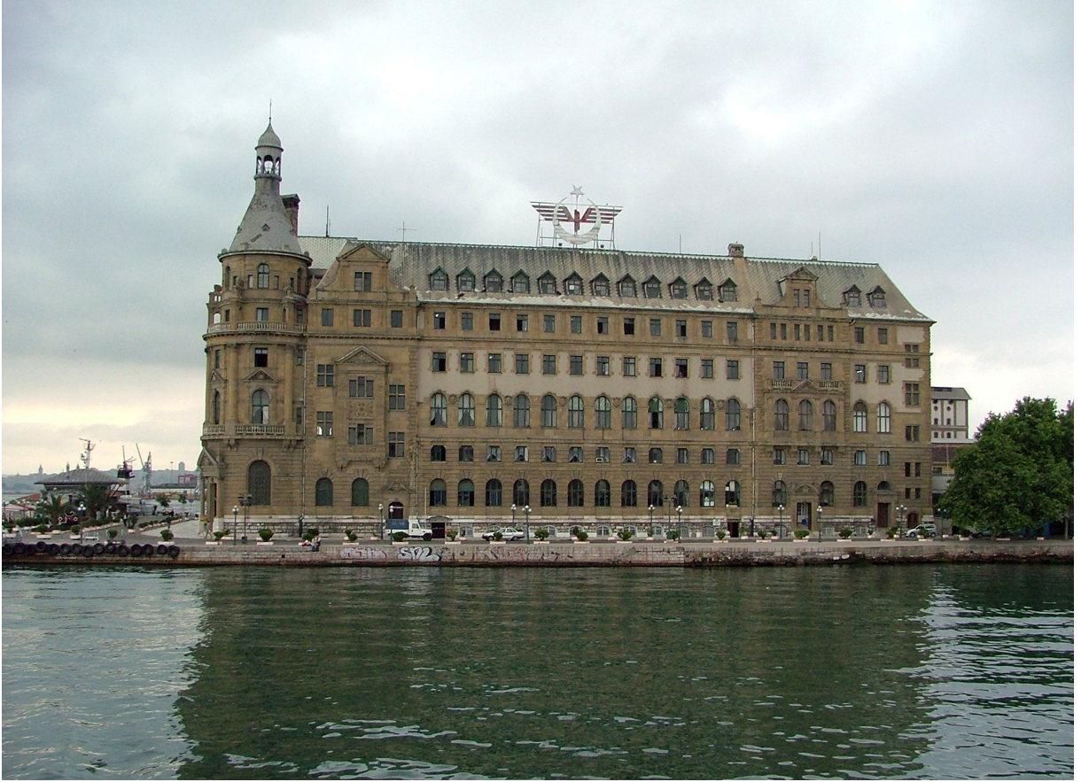
Resim 2.10 Haydarpaşa tren garı sağ yan cephesi (2005)
