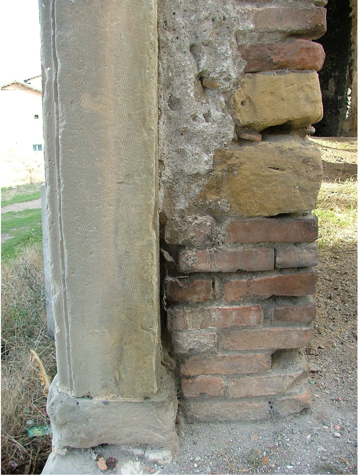
Resim 3.61 Tuğla ve Lefke taşının birlikte kullanımı
