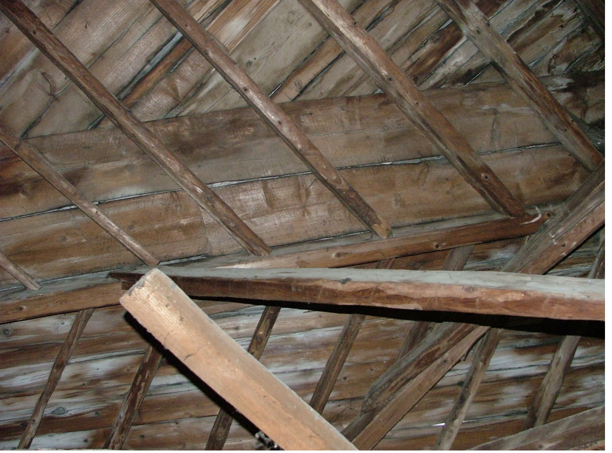
Resim 3.37 Eğime paralel kullanılan kaplama tahtası
