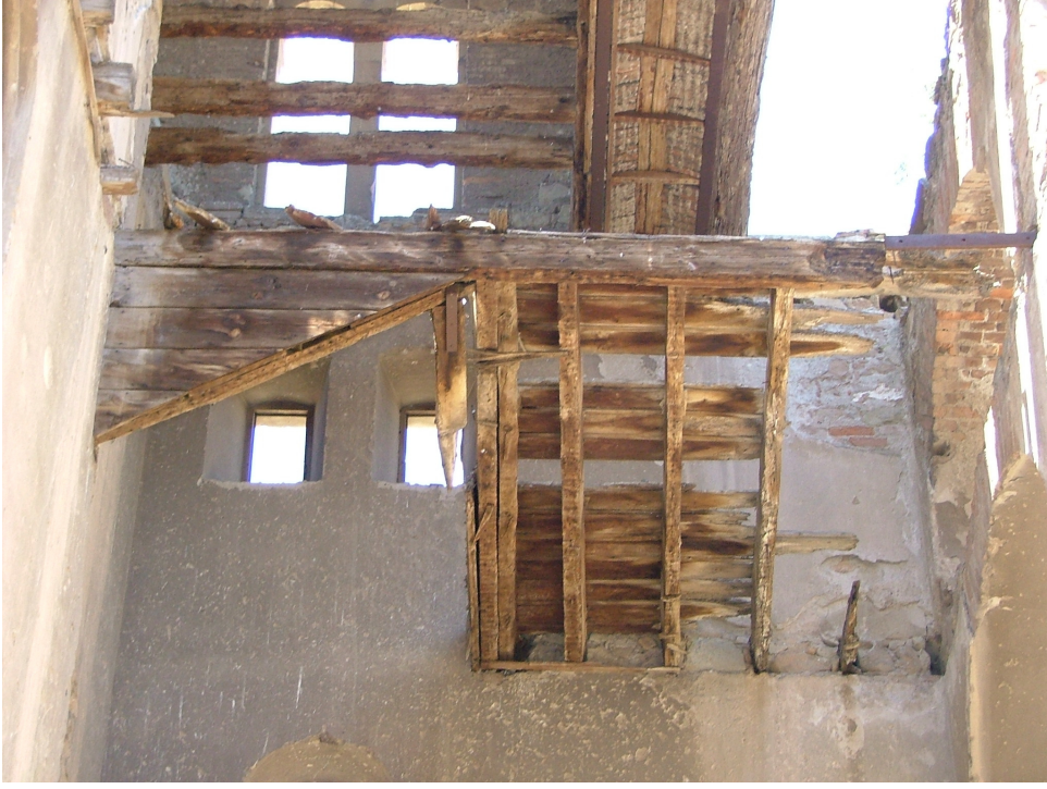
Resim 3.49 Kulelerde ahşap döşeme kalıntıları ve merdiven izleri
