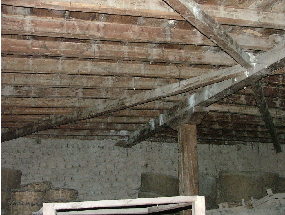
Resim 3.33 Çapraz döşeme kirişleri
