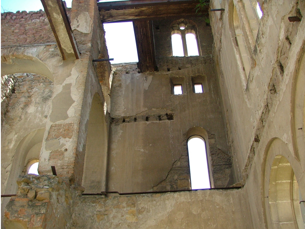
Resim 3.48 Sağ kuleye çıkan merdiven ve döşeme izleri
