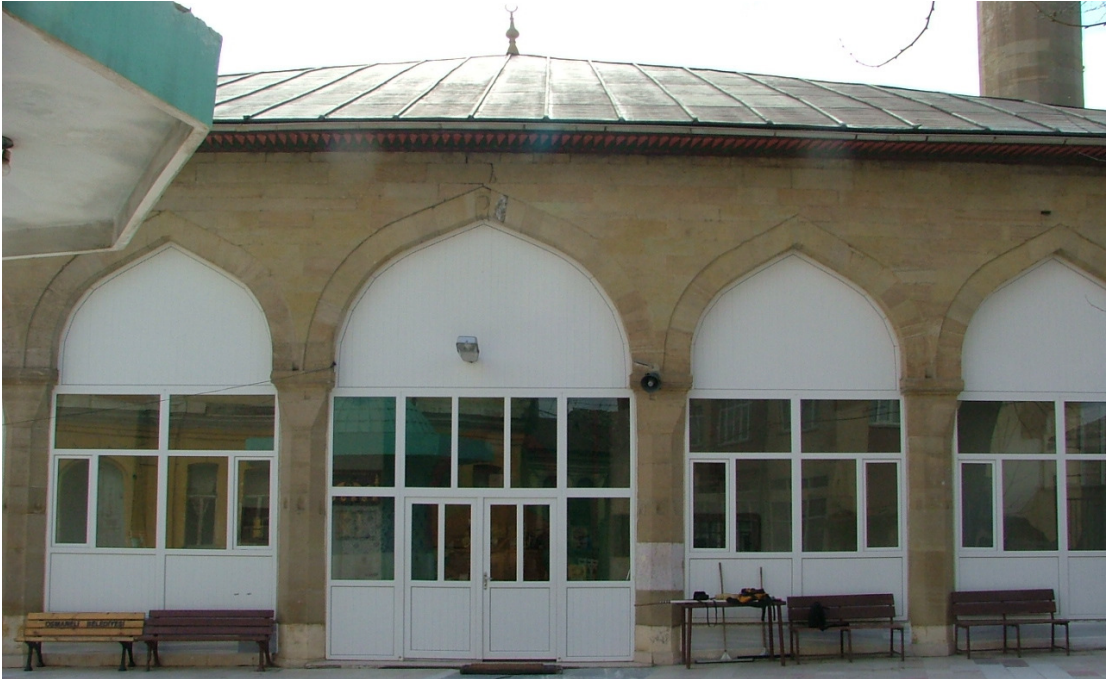
Resim 3.43 Sivri kemerlerle geçilen açıklıklar
