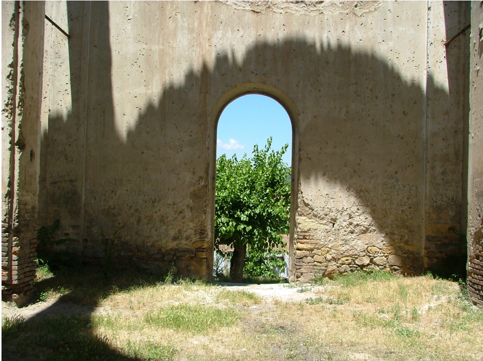
Resim 3.50 Naosun kuzey duvarındaki giriş kapısı
