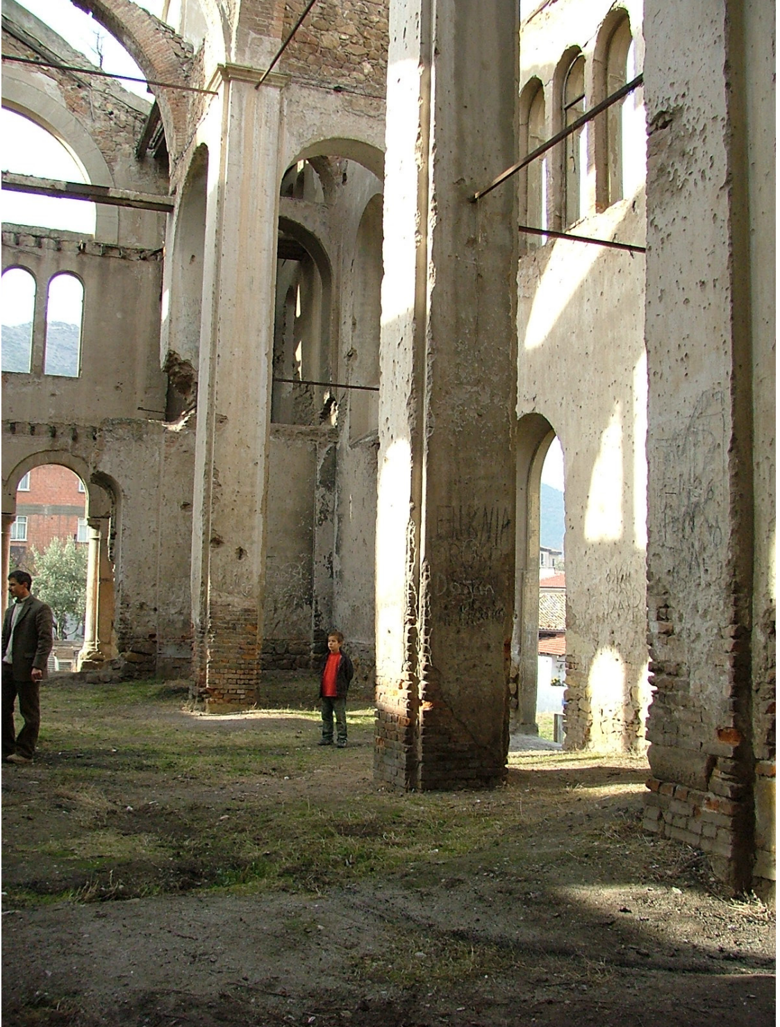
Resim 3.51 Naos içinde bulunan taşıyıcı tuğla ayaklar
