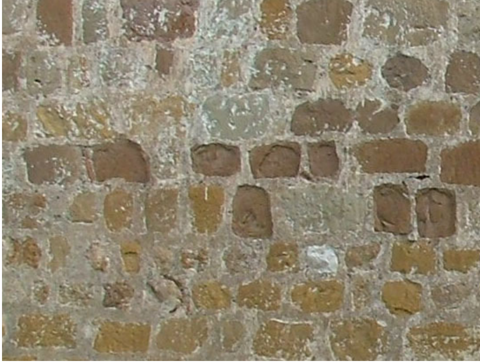
Resim 3.45 Rüstem Paşa Camii'nde kullanılan Lefke taşları
