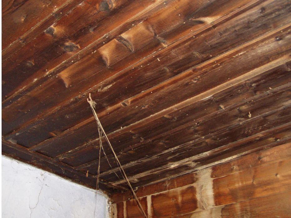
Resim 3.16 Tavan kaplaması yapılmıř mekanlar (zemin kat).
