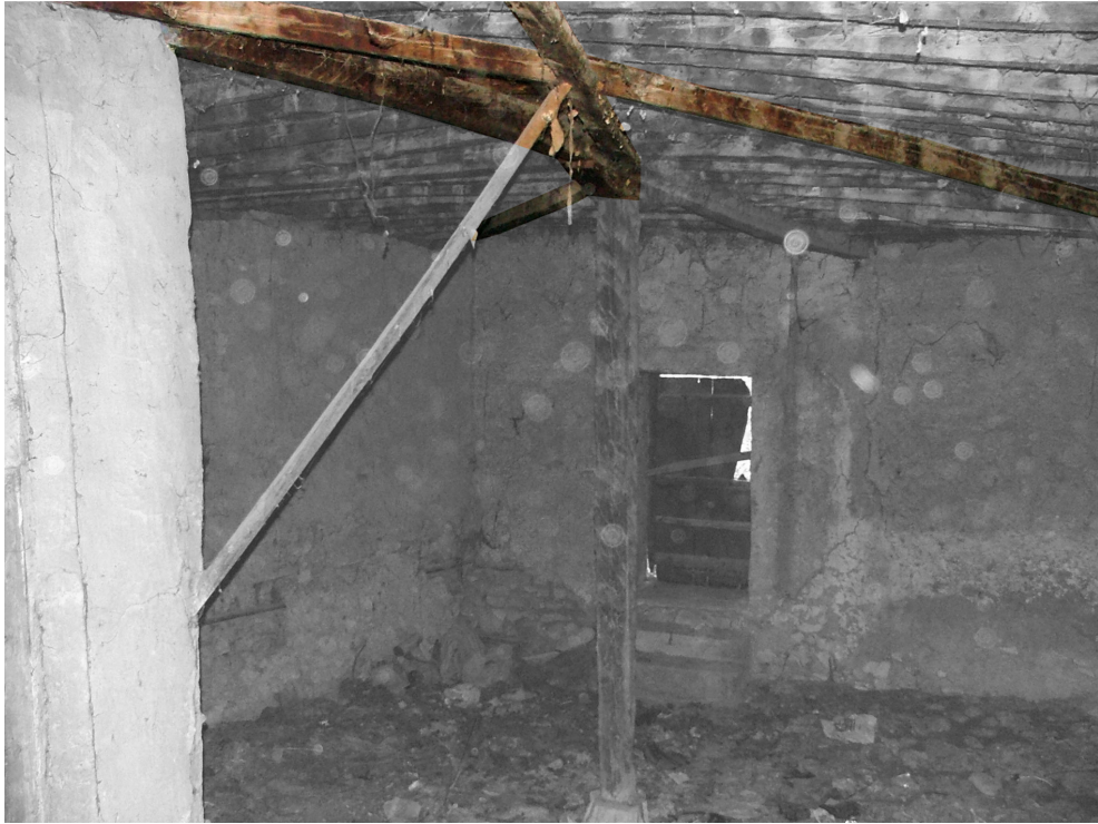
Resim 3.11 Çapraz dşeme kirişleri
