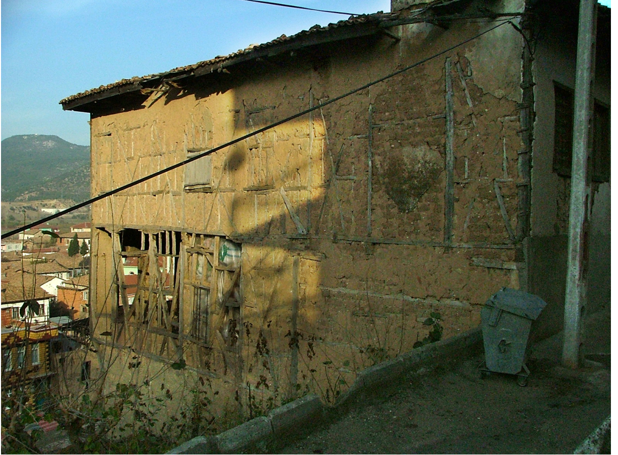
Resim 3.18 Ellezler konağı batı cephesi
