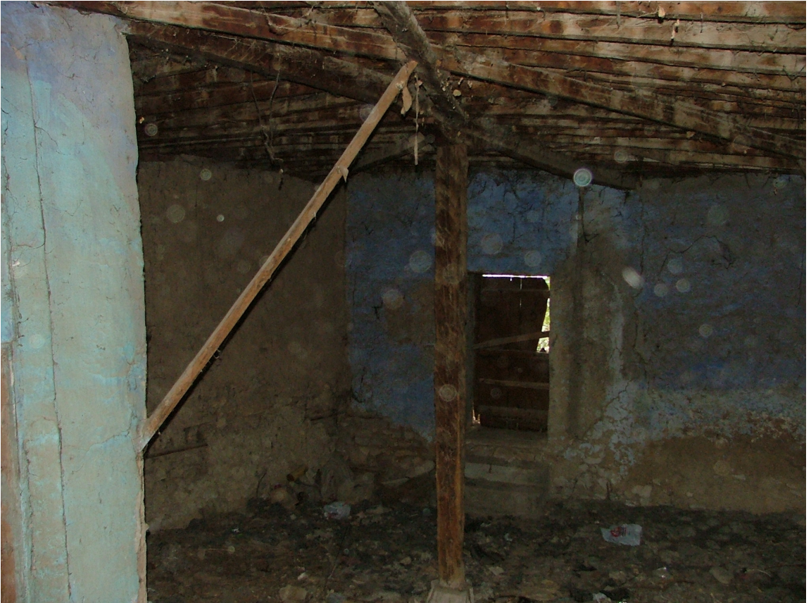
Resim 2.4 Ahşap döşemelerde kullanılan çapraz kirişlemeler
