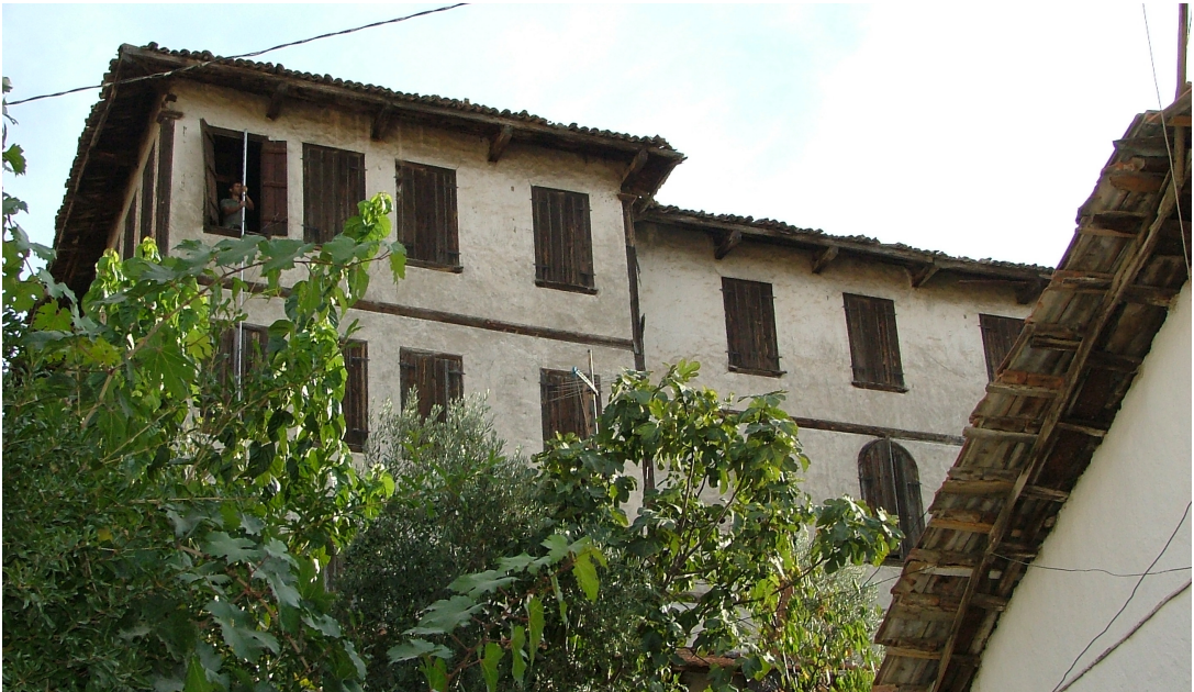
Resim 3.31 Mehmet Özden Evi kuzey cephesi
