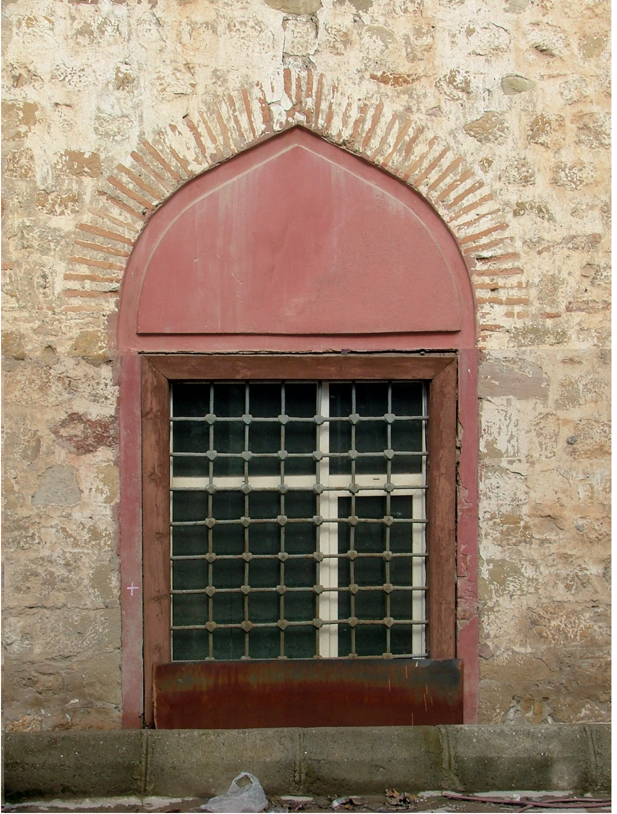
Resim 3.42 Tuğla kemerli pencere açıklığı
