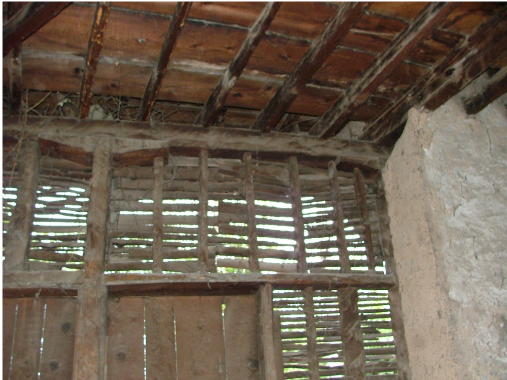
Resim 3.2 Cebecioğlu Konağı'nda tavan kaplaması yapılmamış mekanlar
