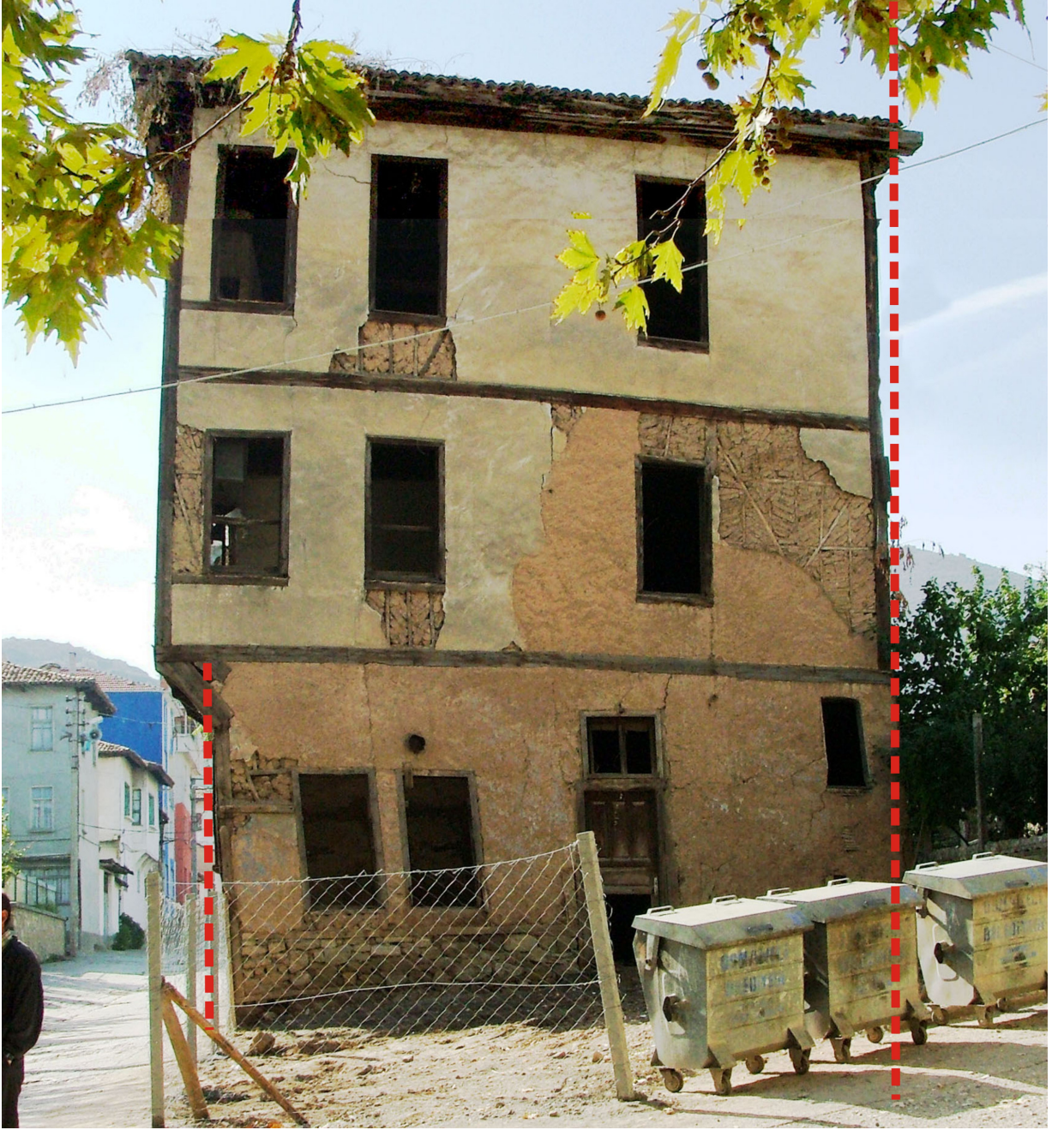
Resim 3.10 Yapıda dönme momenti etkisiyle oluşan düşeyden kaçma
