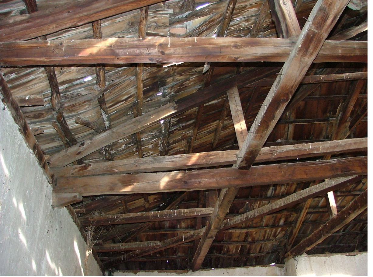
Resim 3.4 Cebecioğlu Konağı çatı konstrüksiyonu
