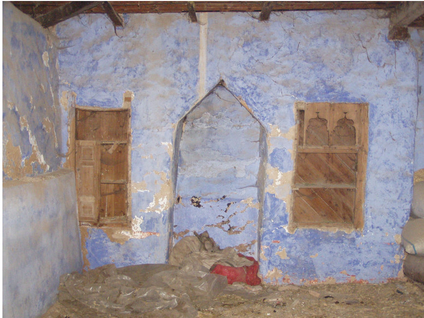
Resim 3.12 Ellezler konağı zemin katta bulunan ocak
