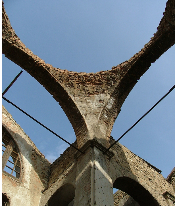
Resim 3.62 Kubbe kasmağı ve tuğla taşıyıcı ayaklar
