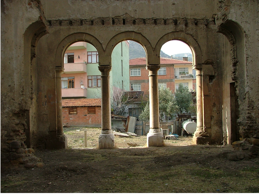
Resim 3.47 Arkada yapıya girişi sağlayan üç açıklıklı duvar ve narteksten naosa girilen ancak günümüzde yıkık olan duvar
