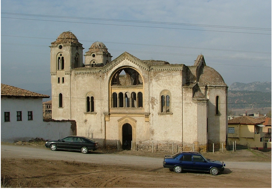
Resim 3.60 Güney cephesi genel görünüşü
