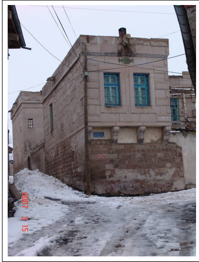
Resim 3.9 Değirmenciler Sokak, No:1, pafta:7, parsel: 1311, 2007
