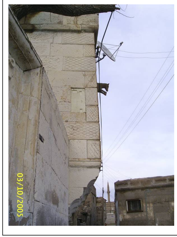
Resim 4.21 Envanter No:09, Kapı No:48, Cumba, taş konsollar ve çörtlen, 2005
