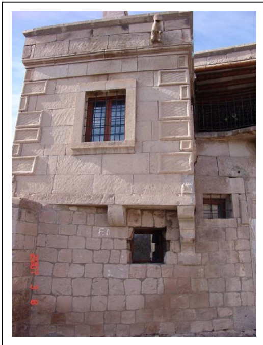
Resim 4.68 Envanter No:06, Kapı No:32, gönye ıkma ve taş konsol, 2007
