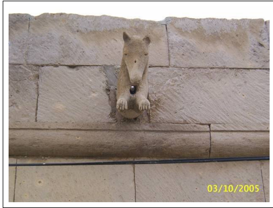
Resim 4.73 Envanter No:09, Kapı No:48, Hayvan biçimli çörten, 2005
