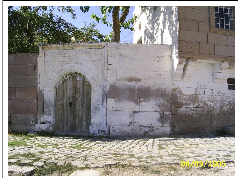
Resim 4.20 Envanter No:09, Kapı No:48, Avlu duvarı ve kapı, 2005
