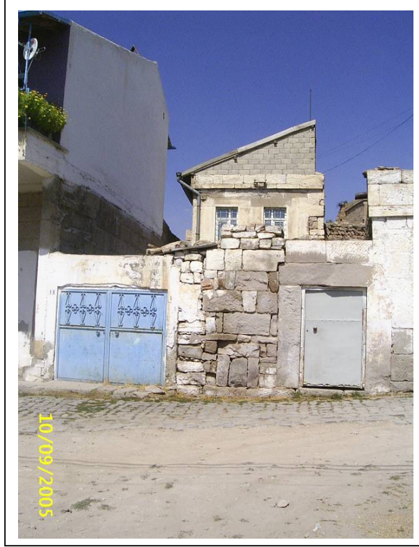
Resim 4.8 Envanter No:51, Kapı No:22, Yeni malzemeler ile yapılmış ekler, 2005
