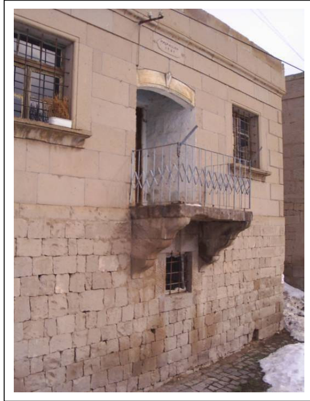
Resim 4.70 Envanter No:10, Kapı No:58, Balkon çıkması ve taş konsol, 2004
