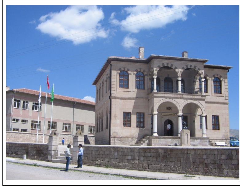
Resim 3.19 Ağırnas Ortaokulu restorasyon sonrası genel görünümü (Ağırnas Belediyesi Fotoğraf Arşivi, 2006)
