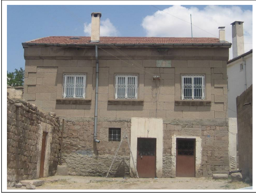
Resim 4.57Envanter No:59, Kapı No:08, Köşe taşları, kat silmesi, cephe düzeni, 2007
