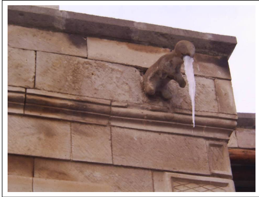
Resim 4.75 Envanter No:06, Kapı No:32, Hayvan biçimli çörten, 2004
