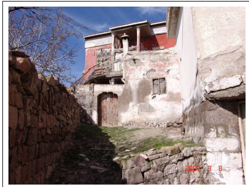
Resim 4.7 Envanter No:17, Kapı No:70 , Yeni malzemeler ile yapılmış ekler, 2007
