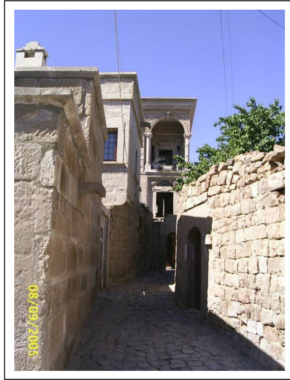
Resim 4.18 Mimar Sinan Evi giriş cephesi, Öztaş Sokak, 2005
