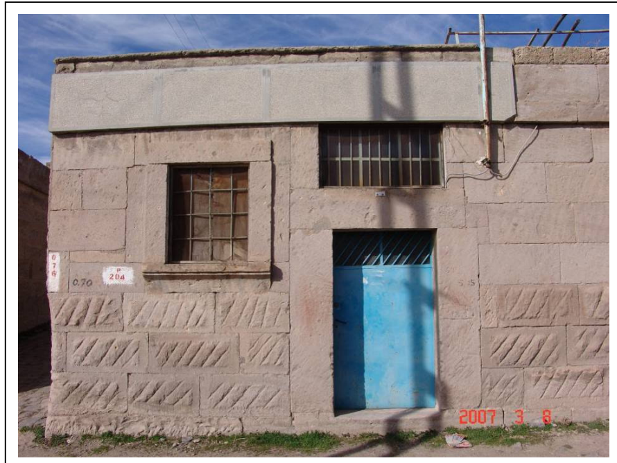
Resim 4.56 Envanter No:53, Kapı No:18/1, Cephe düzeni, çalköşe, tarak izlerinin süsleme olarak kullanımı, 2007
