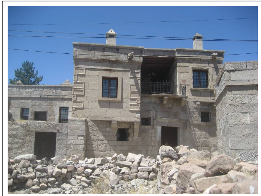
Resim 4.64 Envanter No:06 Kapı No:32–32/1, Cephede pencere düzeni, 2007
