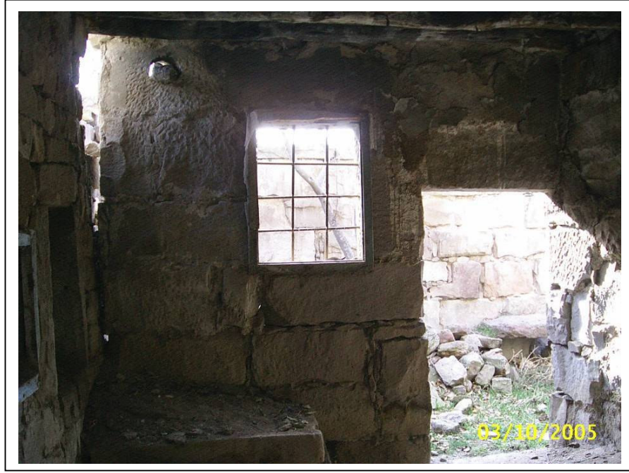
Resim 4.36 Envanter No:11, Kapı No:21, Alt kat odada bulunan duvar nişleri ve çağ taşı, harap olmuş duvarlar, 2005
