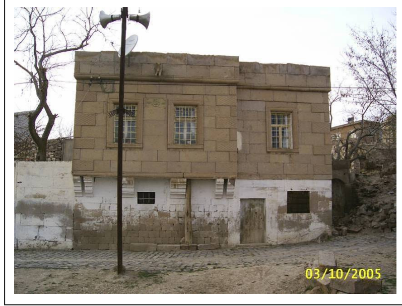
Resim 4.19 Envanter No:09, Kapı No:48, Mimar Sinan Caddesi cephesi, 2005
