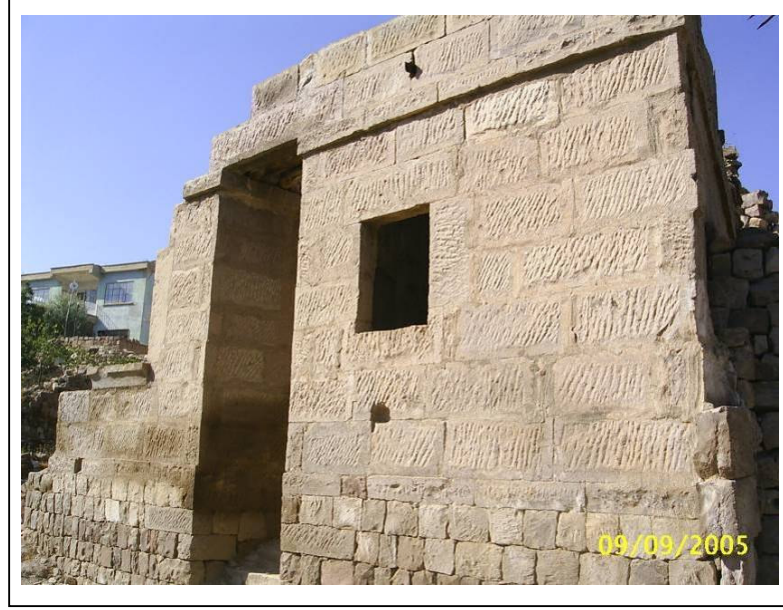
Resim 4.41 Envanter No:13, Kapı No:78, Mimar Sinan Caddesi cephesi
