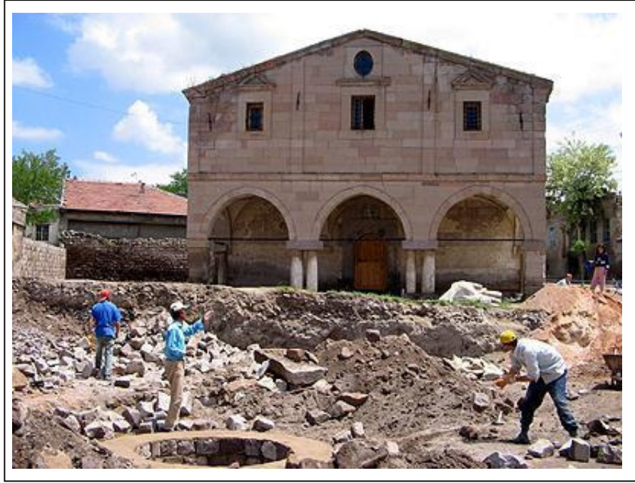
Resim 3.1 Agios Prokopios Kilisesi çevre düzenleme çalışmaları (Ağırnas Belediyesi Fotoğraf Arşivi, 2006)
