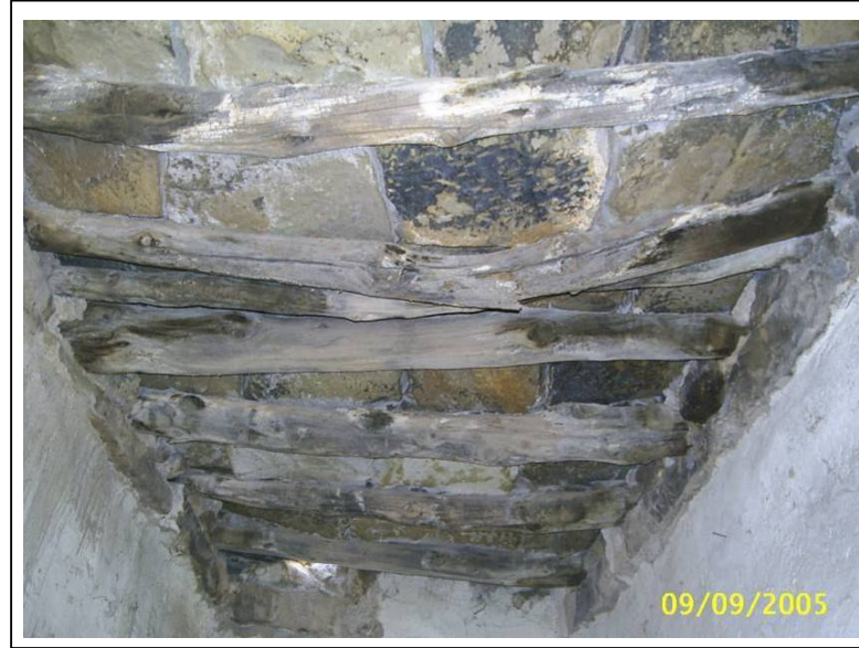
Resim 4.48 Envanter No:13, Kapı No:78, ahşap kirişler, sal ve yassılık taşları, 2005
