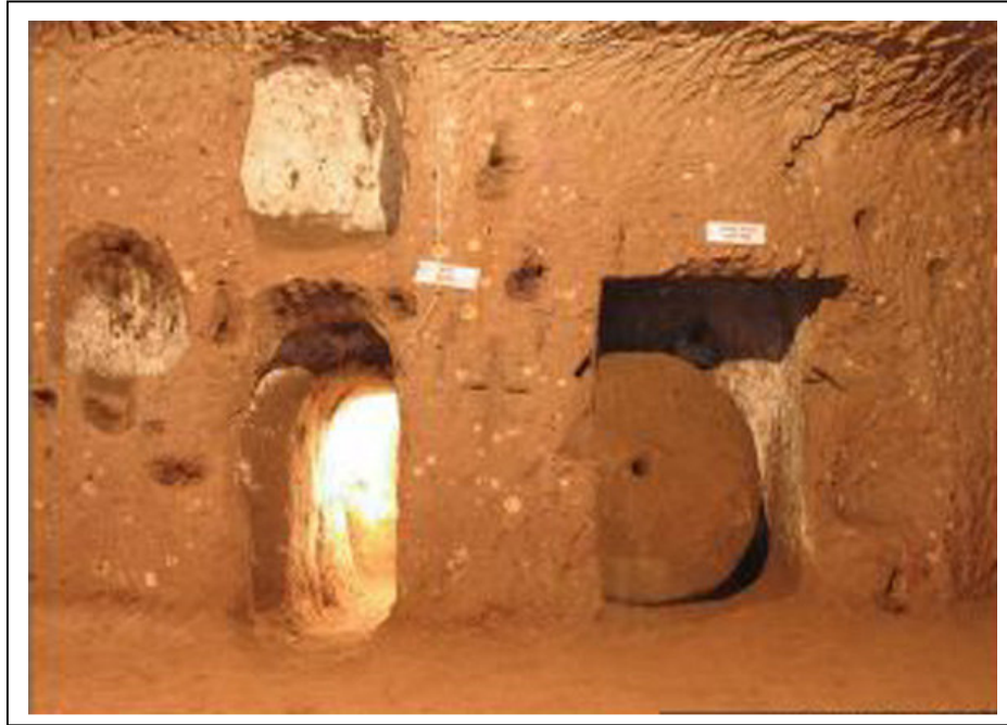
Resim 3.31 Duvar nişleri, giriş kapısı ve sürgü taşı (turhun taşı) (Ağırnas Belediyesi Fotoğraf Arşivi 2006)
