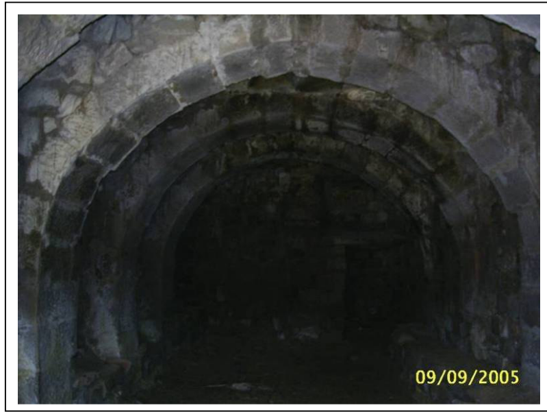
Resim 4.51 Envanter No:11, Kapı No:21, Ahır, arkada mağara girişi ve yüklük, 2005
