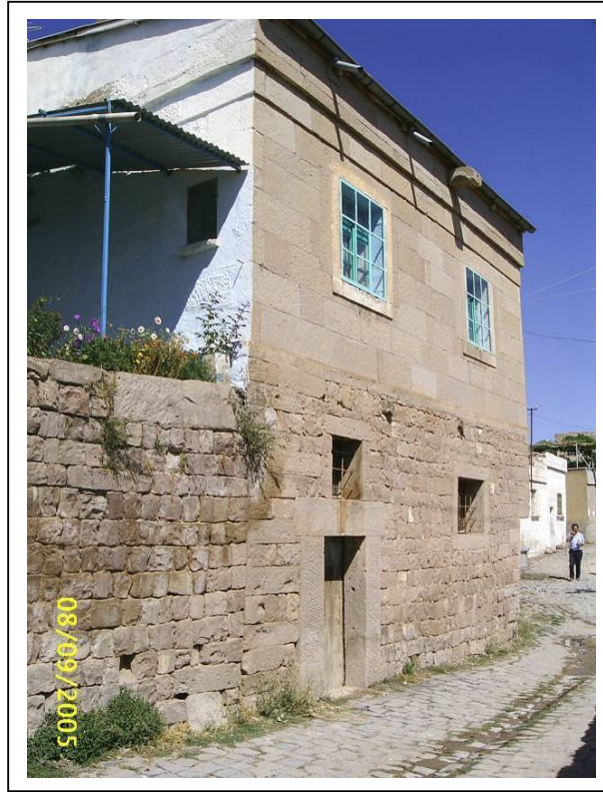
Resim 4.10 Envanter No:04, Kapı No:26, Mimar Sinan Caddesi cephesi, 2005
