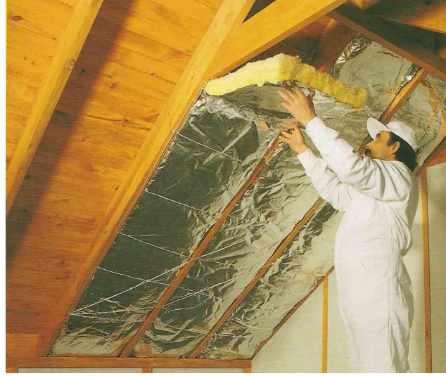
Şekil 4.81 Alüminyum folyo kaplı şiltenin buhar kesiciye gereksinim duyulmadan çatı kesitinde uygulanması (İZOTOPRAKa)
