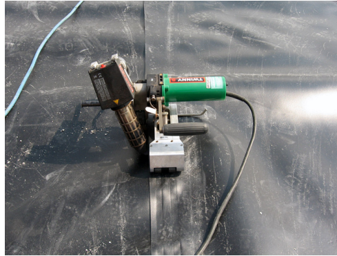
Şekil 4.12 Plastik örtülerin robot kaynak makinesi ile kaynaklanarak birleştirilmesi [35]
