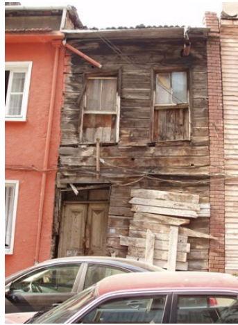
Şekil 3.39 Su ve ısı etkenlerinin oluşturduđu sorunlar nedeniyle bakımsız bir ahşap yapı
