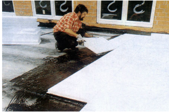
Şekil 4.55 Teras çatı ısı yalıtımında EPS uygulaması [66]
