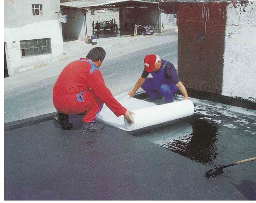
Şekil 4.16 Yalıtım olarak kullanılan karışımın katları arasına taşıyıcı serilmesi (EMÜLZER, 2003)
