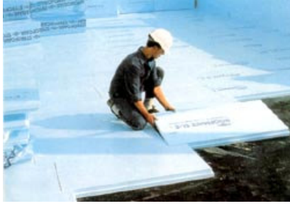
Şekil 4.58 Teras çatı ısı yalıtımında XPS uygulaması [71]
