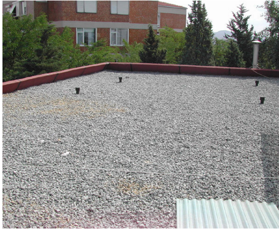
Şekil 3.61 Çatının onarım sonrası durumu [16]
