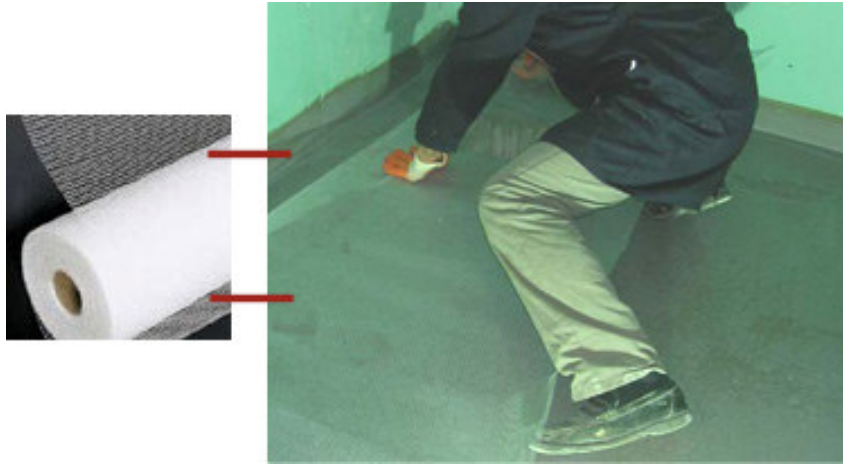
Şekil 4.132 Islak hacimlerde kullanılan sıva filesi ve uygulaması [88]
