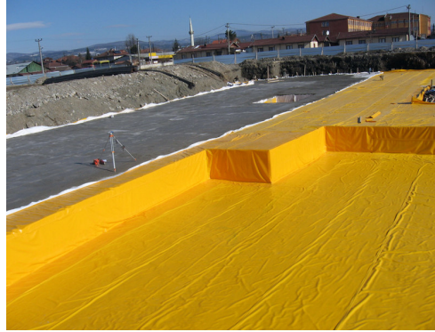
Şekil 4.8 Plastik örtülerle temel yalıtımı yapılması [35]
