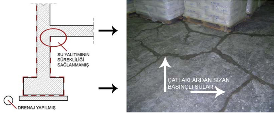
Şekil 3.50 Zemine oturan bodrum kat döşemesinin tasarım aşamasında hatalı detaylandırılması sonucunda, döşemede çatlaklardan basınçlı suların içeri sızması
