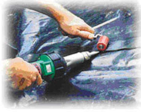
Şekil 4.11 Plastik örtülerin el fön makinesi ile kaynaklanarak birleştirilmesi [34]
