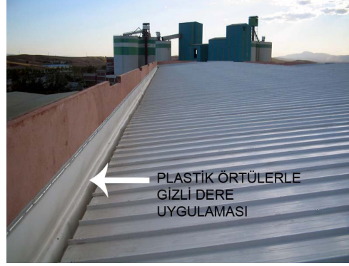
Şekil 4.7 Plastik örtülerle dere yalıtımı yapılması [35]
