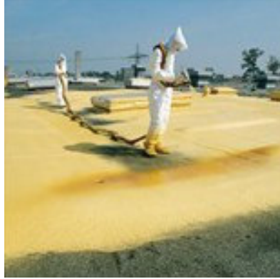
Şekil 4.62 Yapılarda poliüretan sert köpüğün püskürtülmesi yoluyla gerçekleştirilen ısı yalıtım uygulaması [74]
