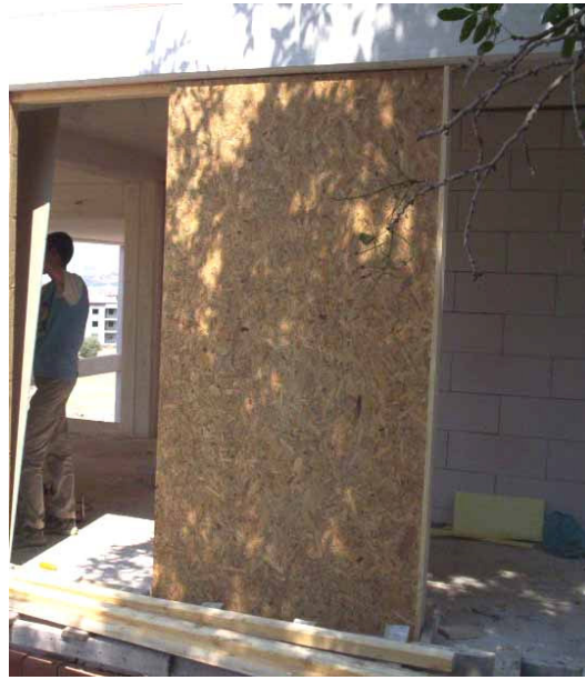
Şekil 4.46 Rende yongasının dış duvarda uygulanması
