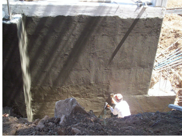
Şekil 4.4 Su yalıtımı yapılacak yüzeyin sıvanması ve ahşap mala ile düzeltilmesi
