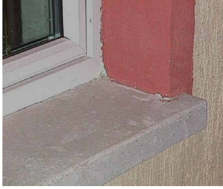
Şekil 3.45 Hatalı bir detay çözümü bulunan denizlik örneği [24]
