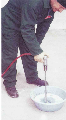
Şekil 4.13 Çimento esaslı karışımın karıştırıcı ile karıştırılması (EMÜLZER, 2003)
