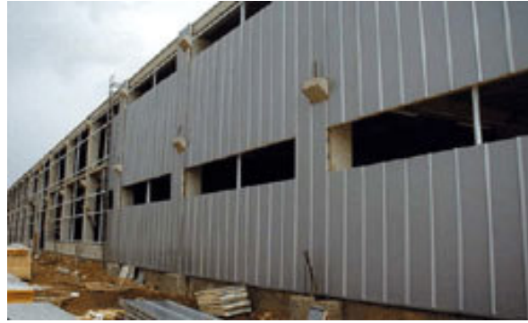
Şekil 4.61 Yapılarda poliüretan sert köpükten oluşturulmuş kompozit panelin dış cephede uygulanması [73]
