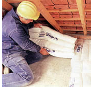
Şekil 4.48 Genleştirilmiş perlit şiltenin kapalı çatılarda uygulanması [58]
