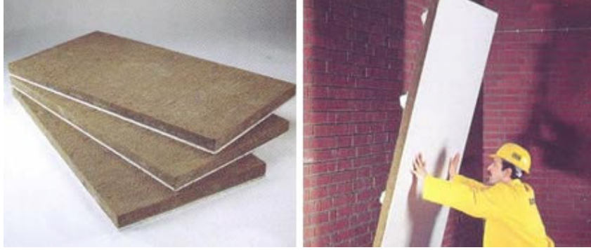
Şekil 4.38 Kalibel ısı yalıtım ürününün duvarda uygulanması [49]
