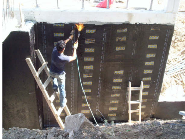
Şekil 4.5 Yalıtım için astarlanmış yüzeye şalümo alevi ile polimer bitümlü örtünün yapıştırılması
