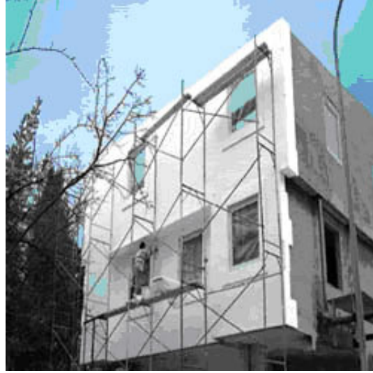
Şekil 4.54 Dış duvar ısı yalıtımında EPS uygulaması [68]
