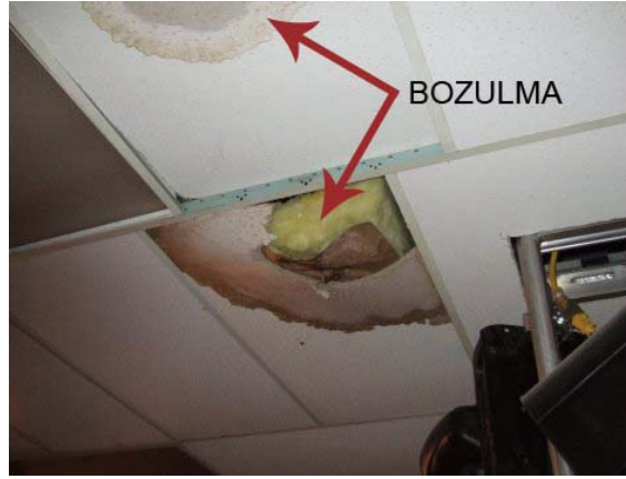
Şekil 3.33 Su ve ısı etkenleriyle asma tavan ürününde bozulma gözlenmesi ve ürünün servis ömrünü kısalması [17]
