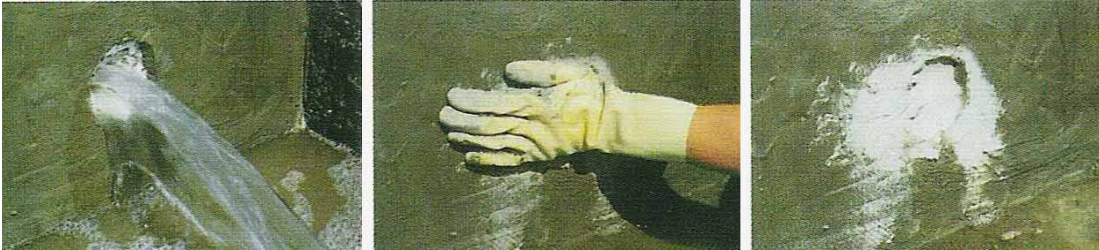
Şekil 4.21 Aktif su kaçağının şok prizli su tıkaçı ile kapatılması (KOSTER Waterproofing Systems)
