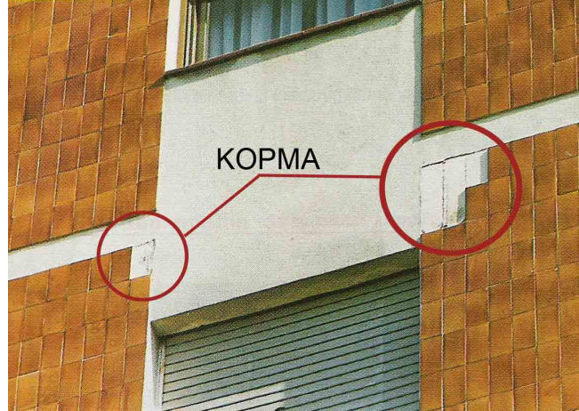
Şekil 3.52 Isıl gerilmelere karşı uyumlu çalışmamış seramik ve bağlayıcısının birbirinden ayrılması (Saint-Gobain Weber Markem YKS, 2002)
