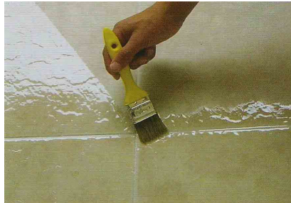
Şekil 4.18 Poliüretan esaslı saydam kaplamanın ıslak hacimde uygulanması (KOSTER Waterproofing Systems)
