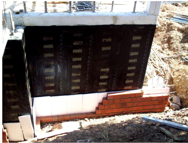
Şekil 4.53 Bodrum kat ısı yalıtımında EPS uygulaması
