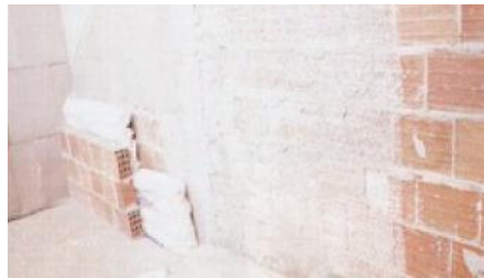
Şekil 4.49 Genleştirilmiş perlit şiltenin çift duvar arasında uygulanması [58]
