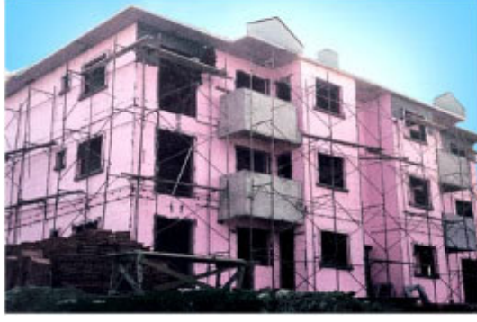
Şekil 4.57 Dış duvar ısı yalıtımında XPS uygulaması [70]
