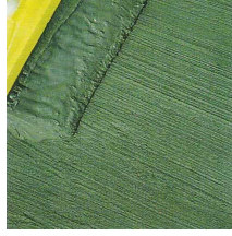
Şekil 4.14 Çimento esaslı karışımın fırça yardımıyla yüzeye uygulanması (KOSTER Waterproofing Systems)
