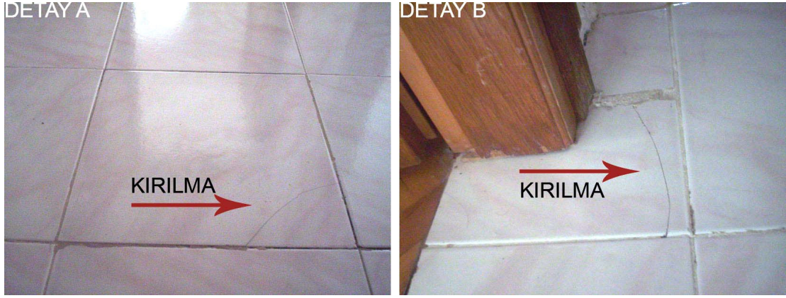
Şekil 3.3 Isı değişimleri ile ortaya çıkan gerilmeler sonucu seramik ürününün dayanımının azalması ve üzerine gelen yükte kırılması
