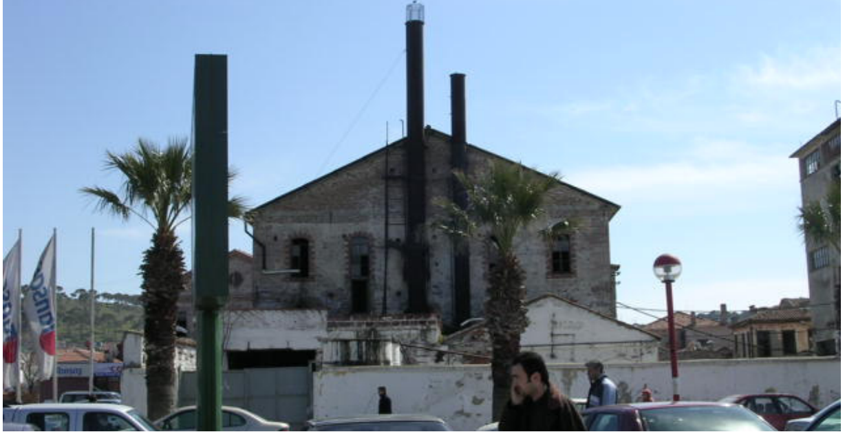
Fotoğraf 4.19 : Ayvalık sahil kesiminde bulunan zeytinyağı fabrikası
