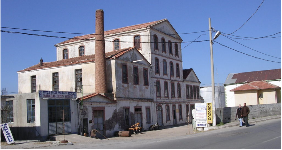
Fotoğraf 4.18 : Ayvalık sahil kesiminde bulunan zeytinyağı fabrikası
