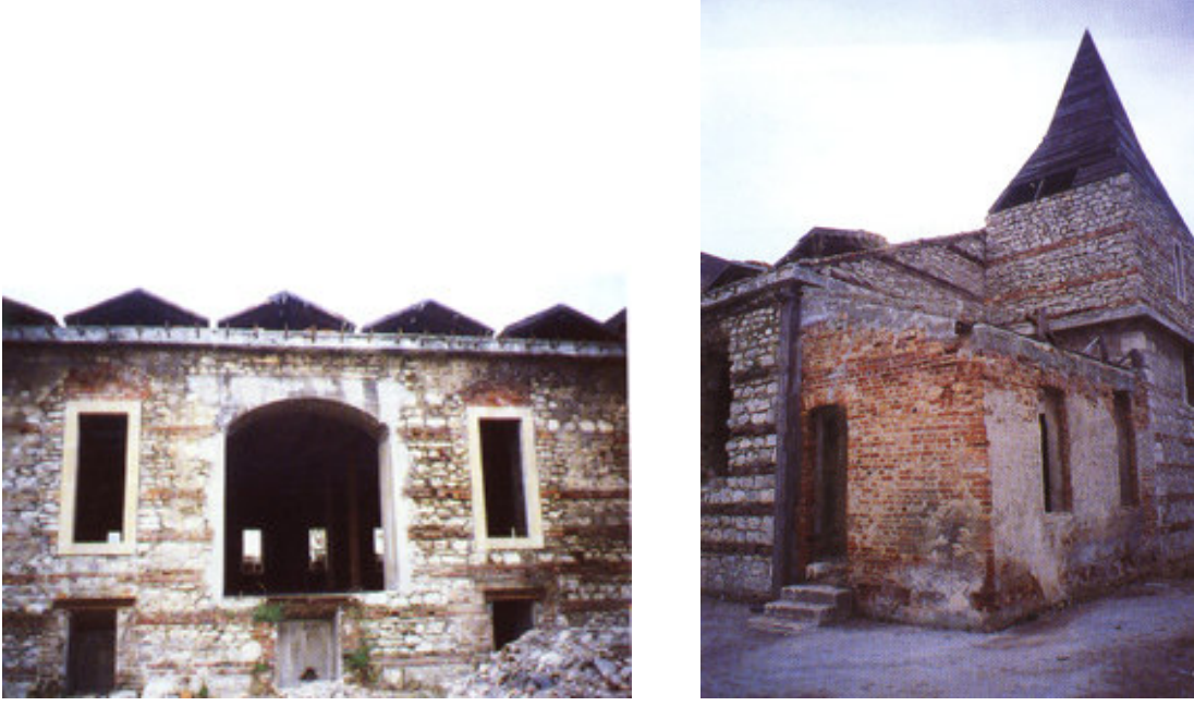
Şekil 8.21 İspirtohane Binası yeniden değerlendirme öncesi
