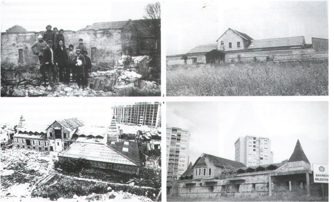
Şekil 8.20 İspirtohane Binası yeniden değerlendirme öncesi
