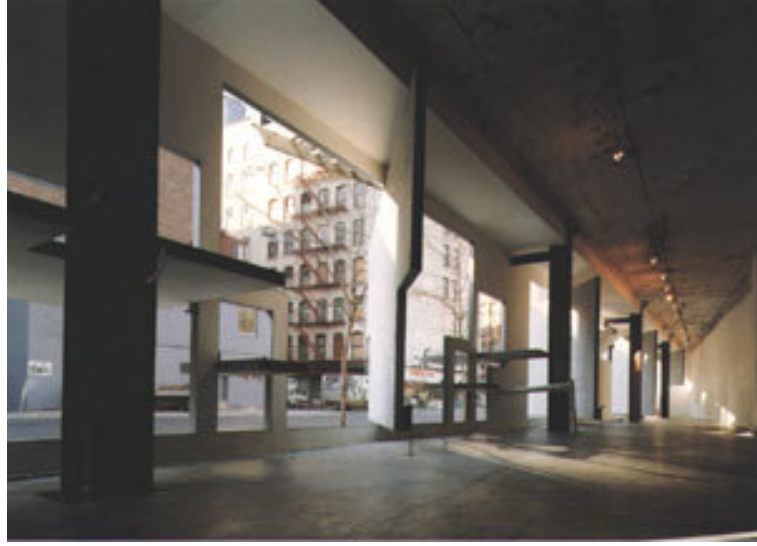
Şekil 7.5 Storefront cephe panelleri içerden görünümü
