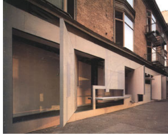
Şekil 7.4 Storefront cephe panelleri açık konumu
