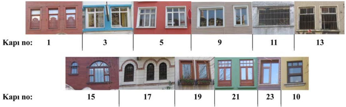
Şekil 3.9 Sultanahmet – Cankurtaran Sokak Kutlugün Sokak’ta pencere ve malzeme incelemesi
