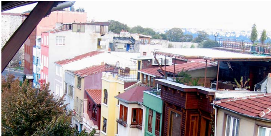
Şekil 3.8 Kutlugün Sokak'ta Çatılar-Gökyüzü İlişkisi
